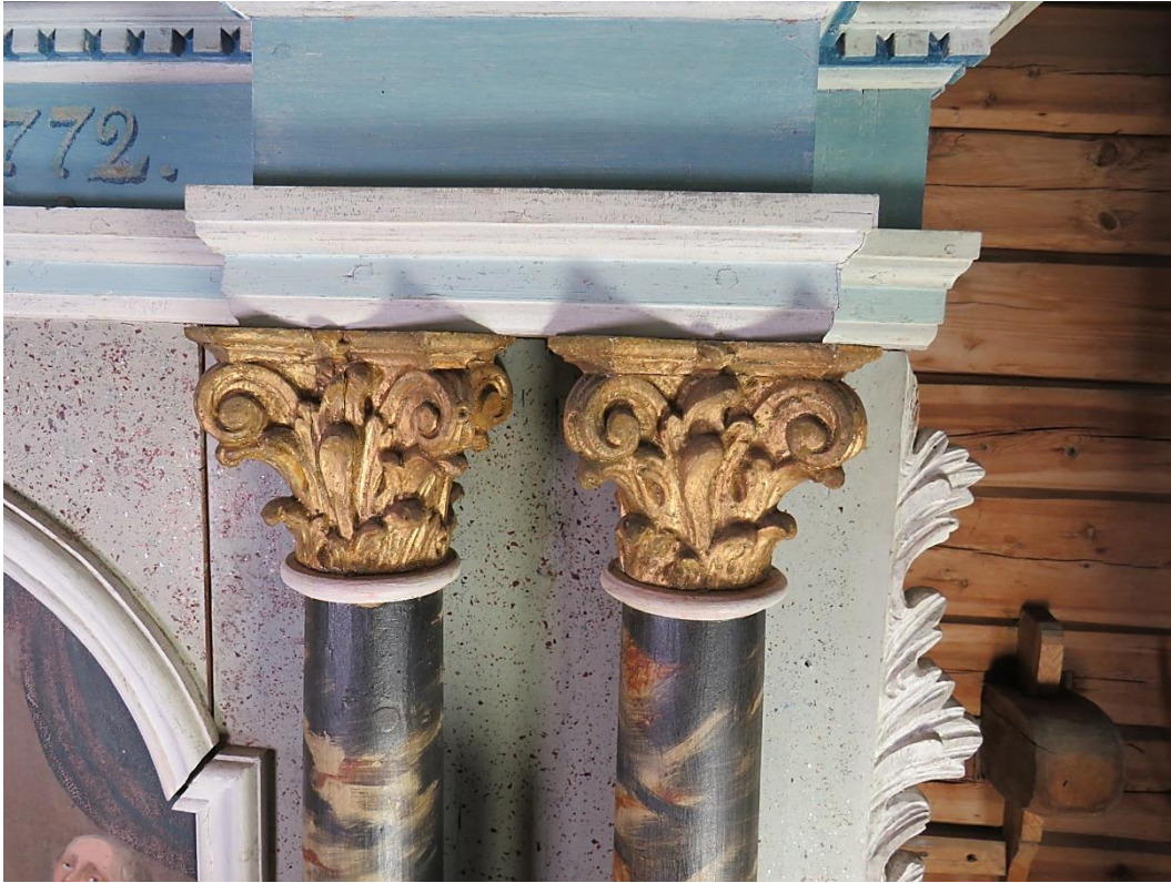
Figur 20 Kapiteler på nordre side konsolidert og retusjert
