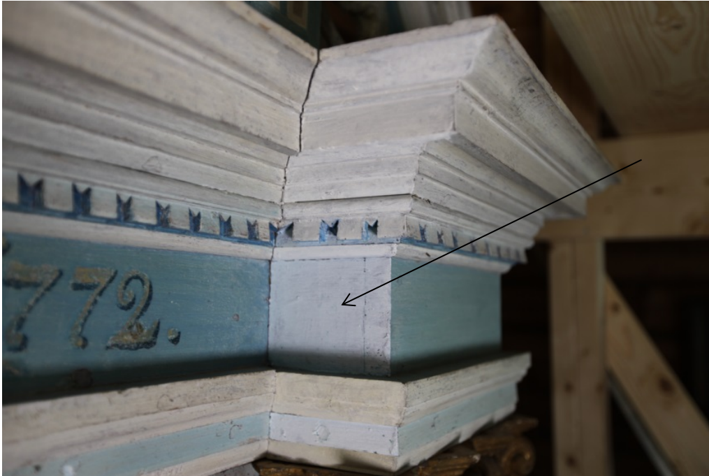
Figur 6 Her sees et felt som ble stående med overmalingen etter restaureringen i 1970
