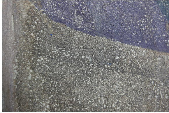
Figur 12: Et område med mange små avskallinger, som muligens skyldes dårlig bundne pigmenter.
