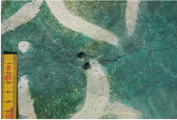
Figur 26: En tidligere sprekk er kittet og retusjert. De to mørke flekkene er limdråper, trolig fra liming av løs puss i dette område.
