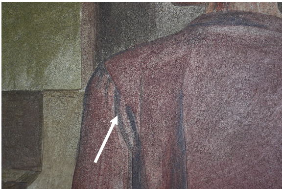
Figur 5: En horisontal og vertikal rissing i pussen tjente trolig som hjelpelinjer.
