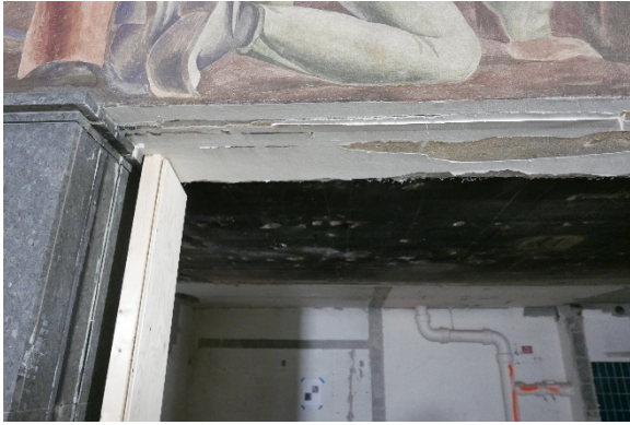
Figur 19: I midtre delen er freskens nedre kant ubeskyttet og sårbar. Her behøves en fysisk beskyttelse for støt.
