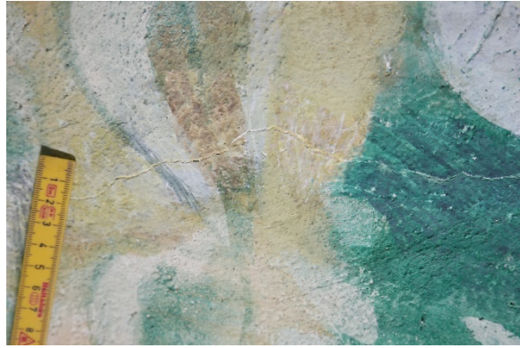
Figur 27: En tidligere sprekk er kittet og retusjert. Pussen er i dag stabil i dette området.
