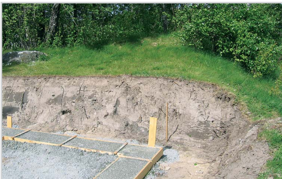
Figur 20. Bygging av campinghytte i gravhaug. Id-nr: 5084. Foto: May-Liss Bøe Sollund, NIKU 2004.
