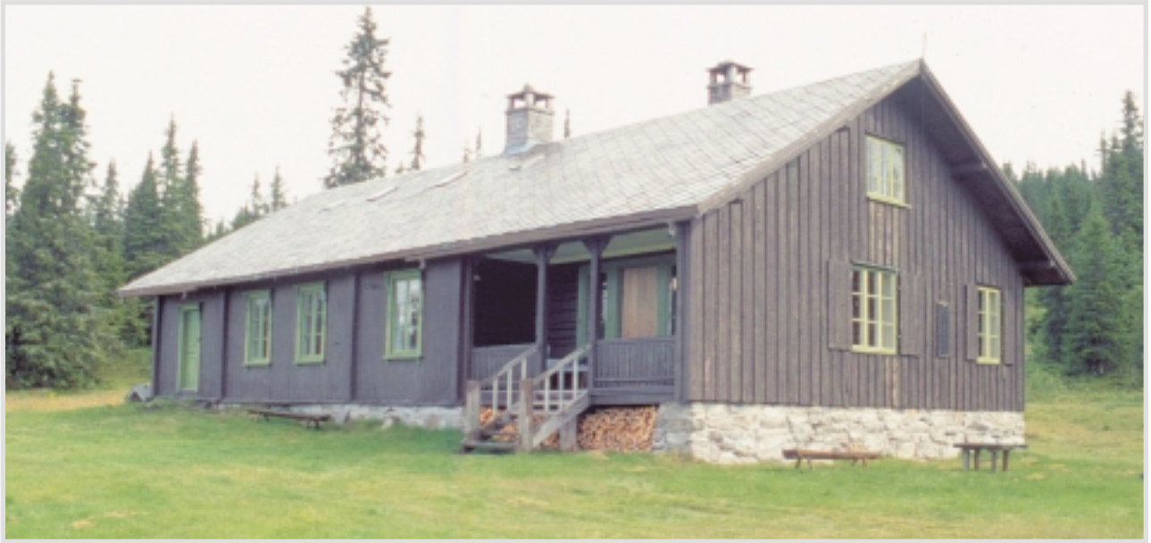
Figur 3. Det nordligste anlegget på Løset Nordsetra er spesielt interessant. Setra ble anlagt i 1890 og ble opprinnelig bygd i laft som kombinert seterstue med velutviklet tilberedning- og lagerrom samt egen boligdel for gårdsfolket. Med egen boligdel er den et tidlig eksempel på hytte i denne delen av landet. Den var uttrykk for et moderne anlegg i samtiden og avspeiler endringer som gjorde seg gjeldende i seterdriften rundt 1890. Foto: Thomas Lie.
