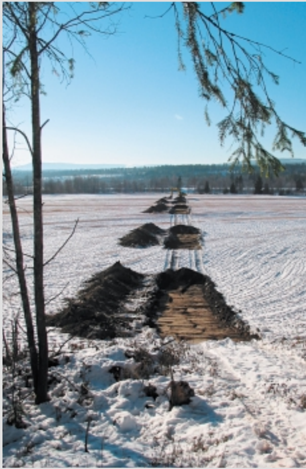
Figur 4. Sjaktning i en rørledningstrase på Alme, Åmot kommune, litt for sent på høsten. Foto: Kjetil Skare, Hedmark fylkeskommune.
