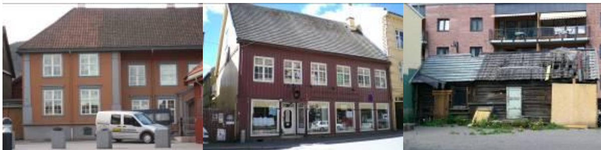
Fra før 1700. Tollbugata 54 og 14, Webergs gate 7 (Foto: NIKU 2006/2009).
