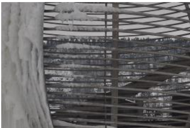
Detalj fra vindeltrappa på Union brygge (Foto: Brandengen skole 2010).
