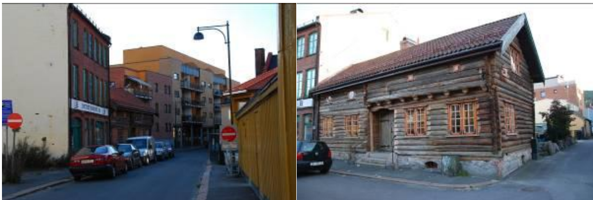
Schultz gate 38 og 36. Fabrikbygning og delvis rekonstruert tømmerhus (Foto: NIKU 2006/2009).
