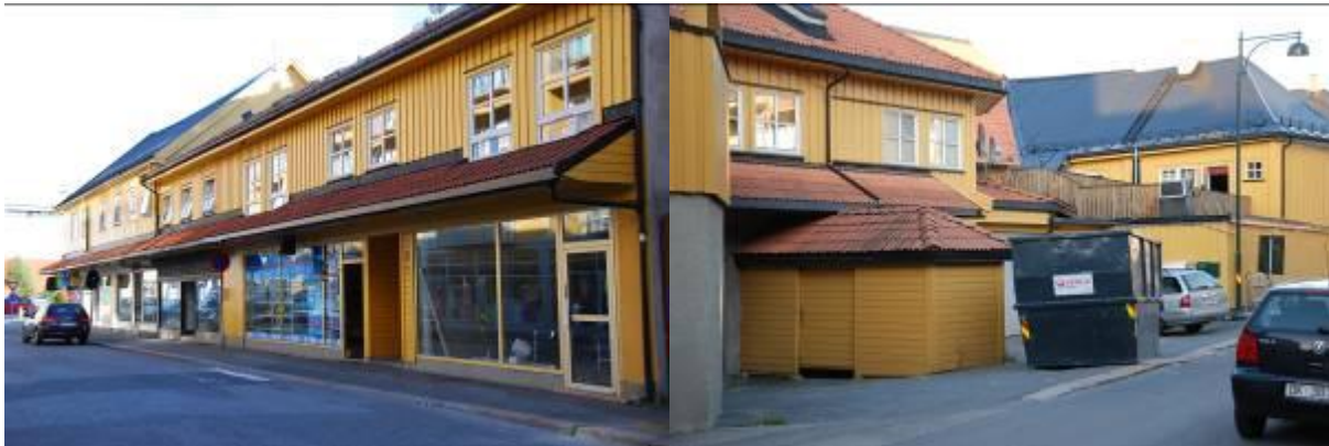
Tollbugata 16. Levende bygning fra 1600-tallet til vår tid (Foto: NIKU 2006/2009).
