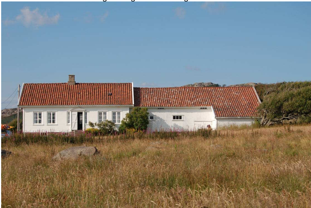
Figur 2. Martine Pennes hus, også kalt Penne-huset, et tradisjonelt Lista-hus der bolig og fjøs-/løedel er bygget sammen (Foto: NIKU)
