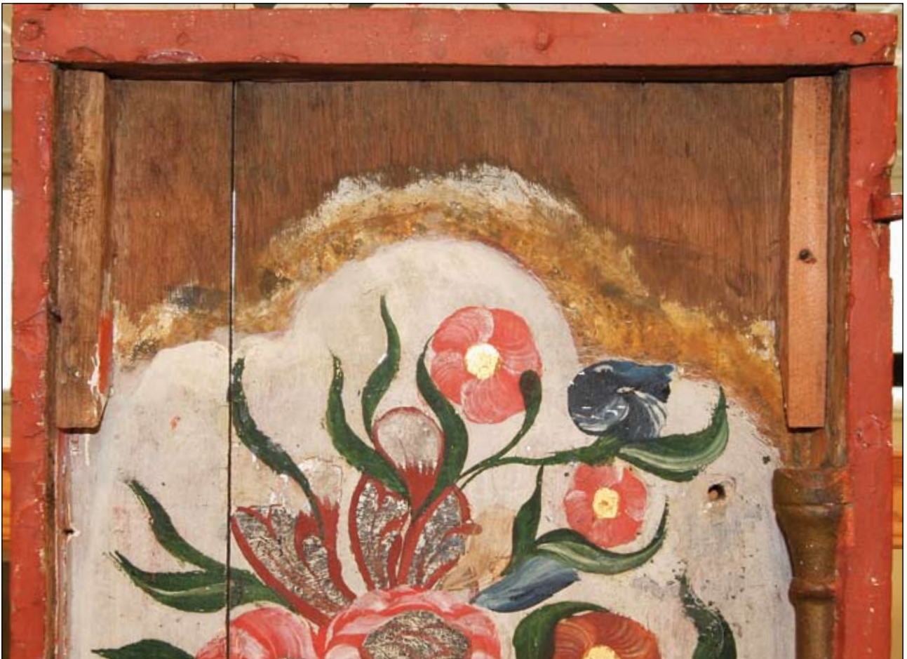
Figur 7. Arkadebuene er festet til lister som igjen er limt til fløyen. Til venstre et originalt feste, til høyre en sekundær list. Hengslene er festet til belistningen. Foto: Mille Stein, NIKU, 2006.
