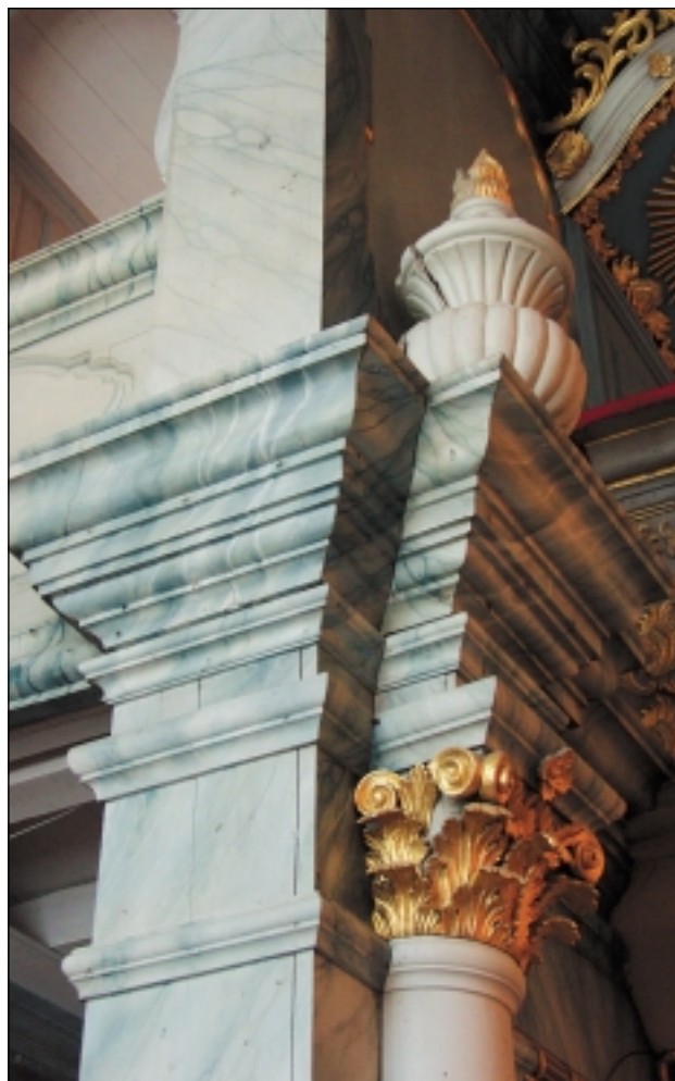
Figur 30. Detalj av alterveggenes sydside. Bildet viser partier med meget nedbrutt opprinnelig maling og dekor. Skadene er forårsaket av UV-strålingen gjennom vinduene. Det er også andre klimarelaterte og mekaniske skader. Foto J. Brønne 2002.
