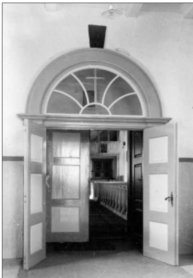
Figur 21. Våpenhuset. Ny mellomdør inn til skipet. Bildet er trolig tatt umiddelbart etter at dørene er satt inn i 1922, idet dørene fremdeles har i to gråfarger. Se den historiske oversikten. Veggene har på dette tidspunktet malt brystning. Brystningen må da være malt mellom 1915 da rommet ble pusset opp, og ca. 1922. Ukjent fotograf, ant. Domenico Erdmann.
