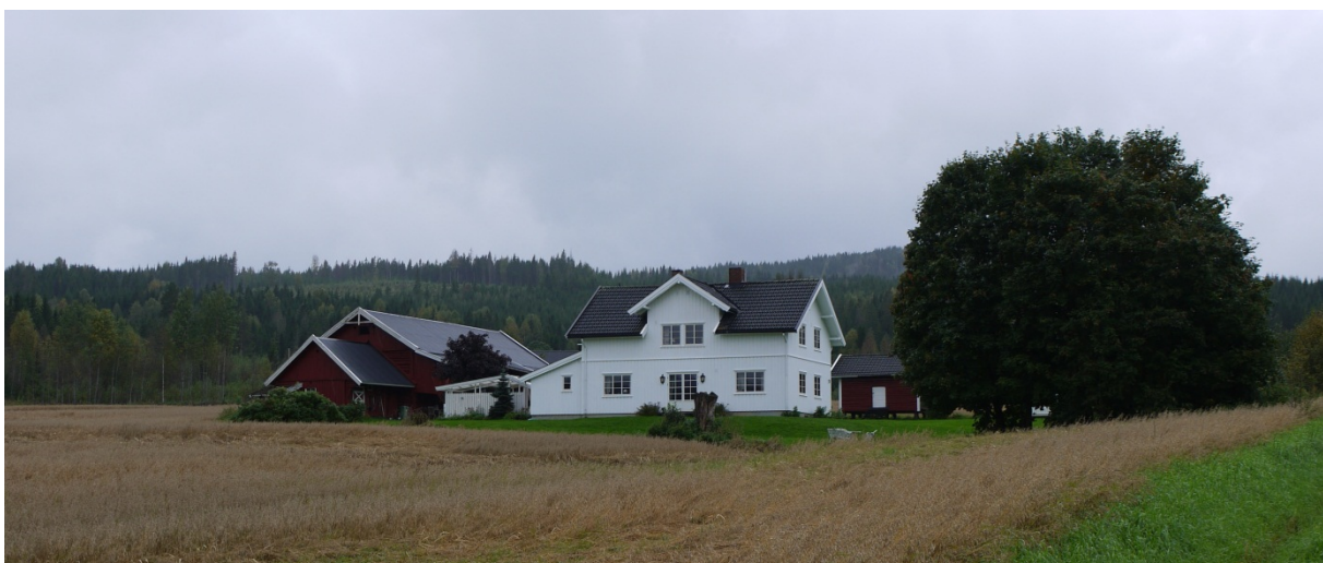
02330017038: Bygningene på Søndre Nøkleby i Øvre Hakadal er intakt og ikke sterkt endret. Foto: ÅD, NIKU 2011
