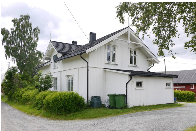
02330004003: 76 % av de undersøkte bygningene i Nittedal kommune ligger i spredtbygde områder, slik som gården Store Ramstad. Tapsandelen er lavere i de spredtbygde områdene enn i de tettbygde (3 % mot 8 %). Foto: LM, NIKU 2011.
