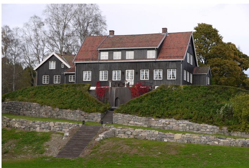
02330009043: I 3. omdrev var andelen endrete bygninger noe større i tettbygde enn i spredtbygde områder, mens det i 2. omdrev var omvendt. Våningshuset på Røtnes gård, som ligger i den tettbygde kretsen Mo, er registrert med C-liten endring både i 2. og 3. omdrev. Foto: JS, NIKU 2011.
