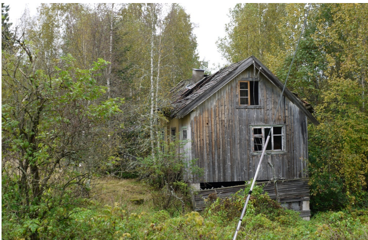
02330012013: Også Nedre Berger er fraflyttet. Her er forfallet kommet lenger, og våningshuset er registrert som sterkt truet i 3. omdrev. Foto: ÅD, NIKU 2011.
