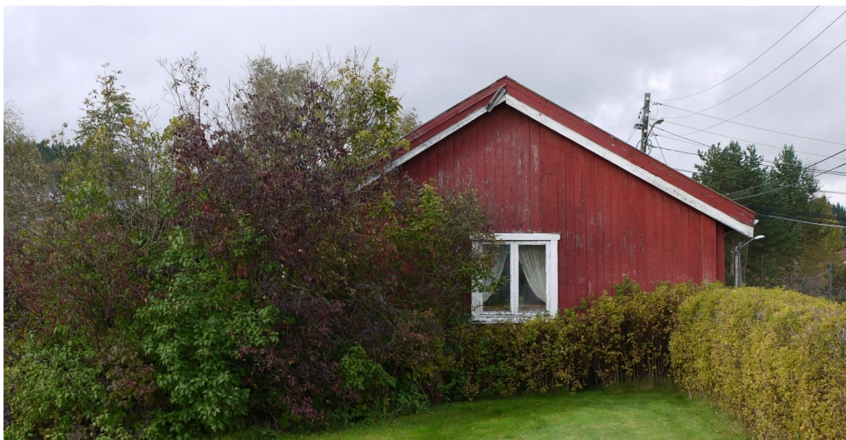
02330002041: Selv om Nittedal var en ren landbrukskommune før 1900, finnes det også fra denne tiden frittstående boligbebyggelse uten spesifikk tilknytning til landbruket, slik som denne boligen på Gjelleråsen. Foto: JS, NIKU 2011.
