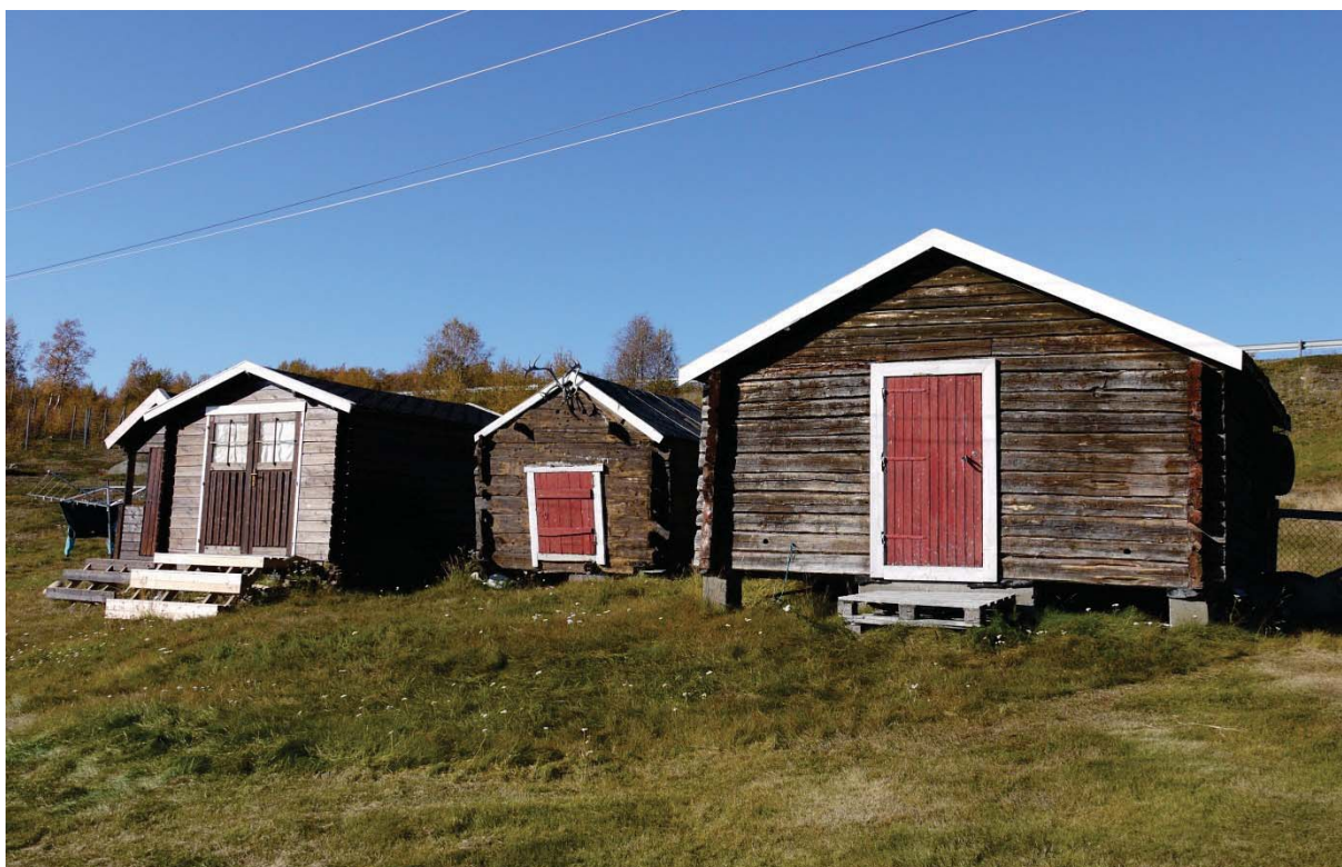
2011004003: Burekke i Mieronjævre. Den midterste bygningen er med i undersøkelsen.
