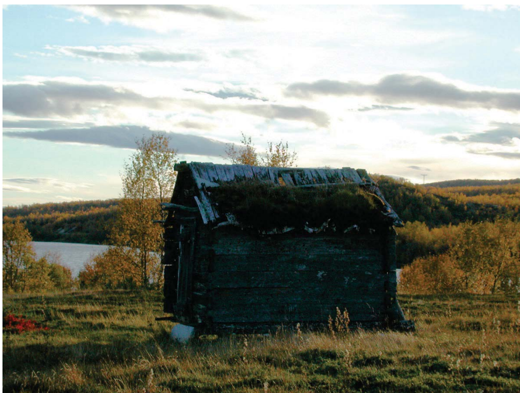
20110004009: Taket på dette stabburet i Mieronjævre var i dårlig forfatning i 2005. Foto: Kulturminnekompaniet 2005.
