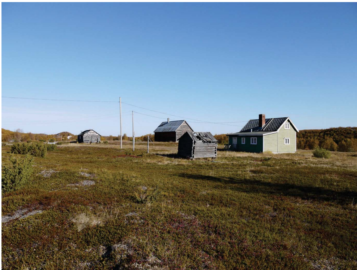
20110004009: Fraflytting og bygninger som går ut av bruk er en viktig årsak til forfall, slik som for dette stabburet i Mieronjævre.
