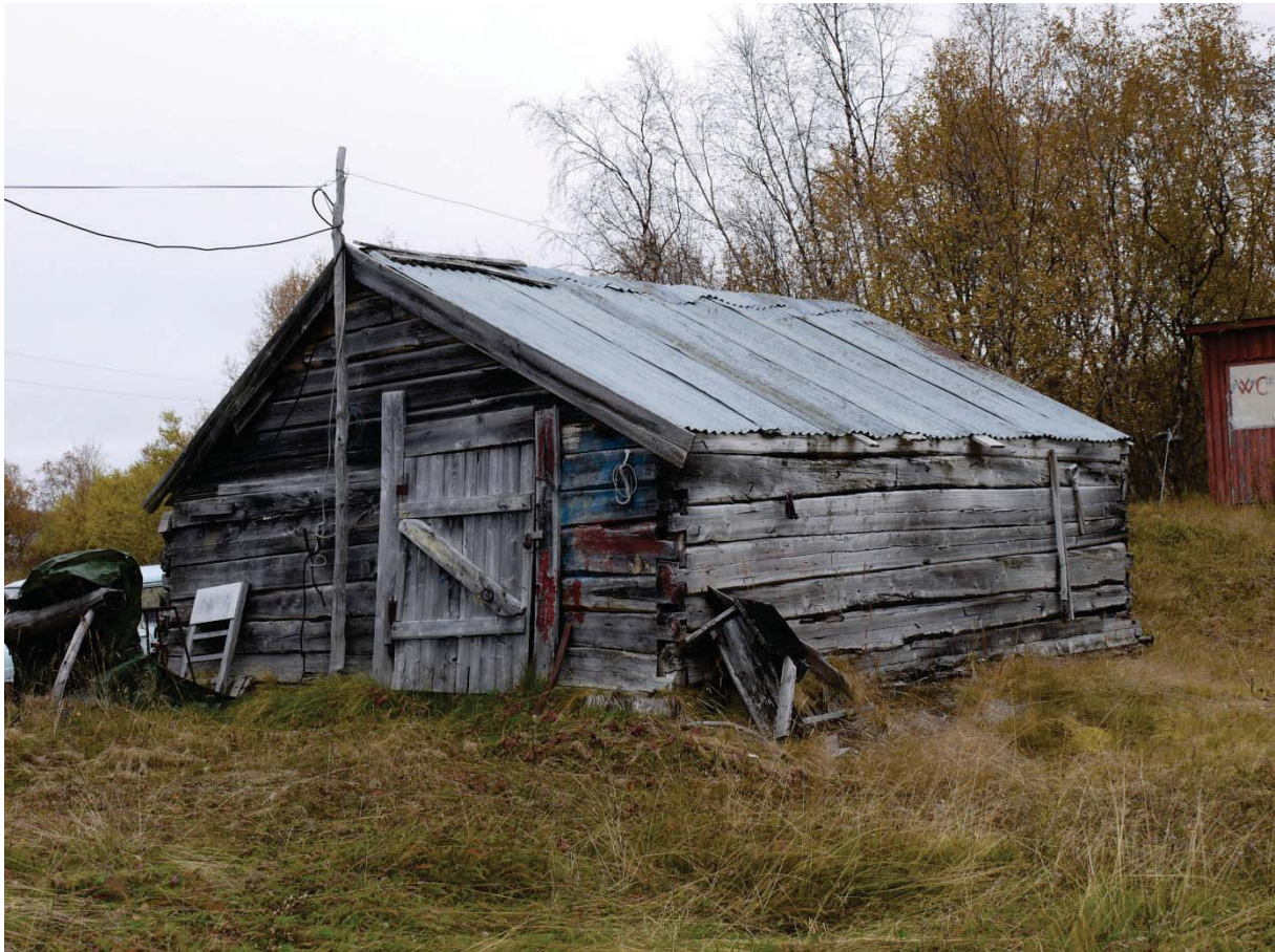
20110004040: Denne bygningen er registrert som stabbur i den opprinnelige SEFRAK-registreringen, men har tidligere vært våningshus på gården.
