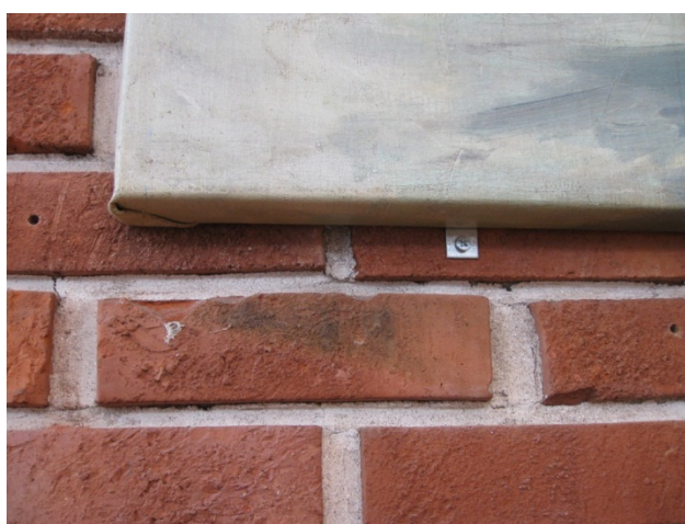
Illustrasjon 26: Montering til veggen med beslag som skjules av pynterammen. Her sees nedre, venstre hjørne.
