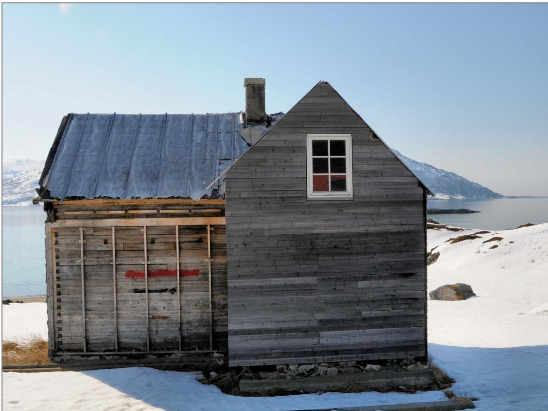
Figur 56: En eldre bygning består av lag på lag med skiftende materialbruk og vedlikehold, skiftende eiere og historier. Foto: Elin Rose Myrvoll, 2009.
