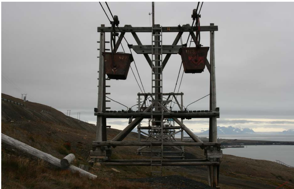
Foto 1 Taubanebukkene langs Burmaveien. Taubanesentralen samlet alle taubanetraseene og sendte dem videre i en trase ut langs Burmaveien til utskipningskaia på Hotellneset. Foto: AC Flyen, NIKU
