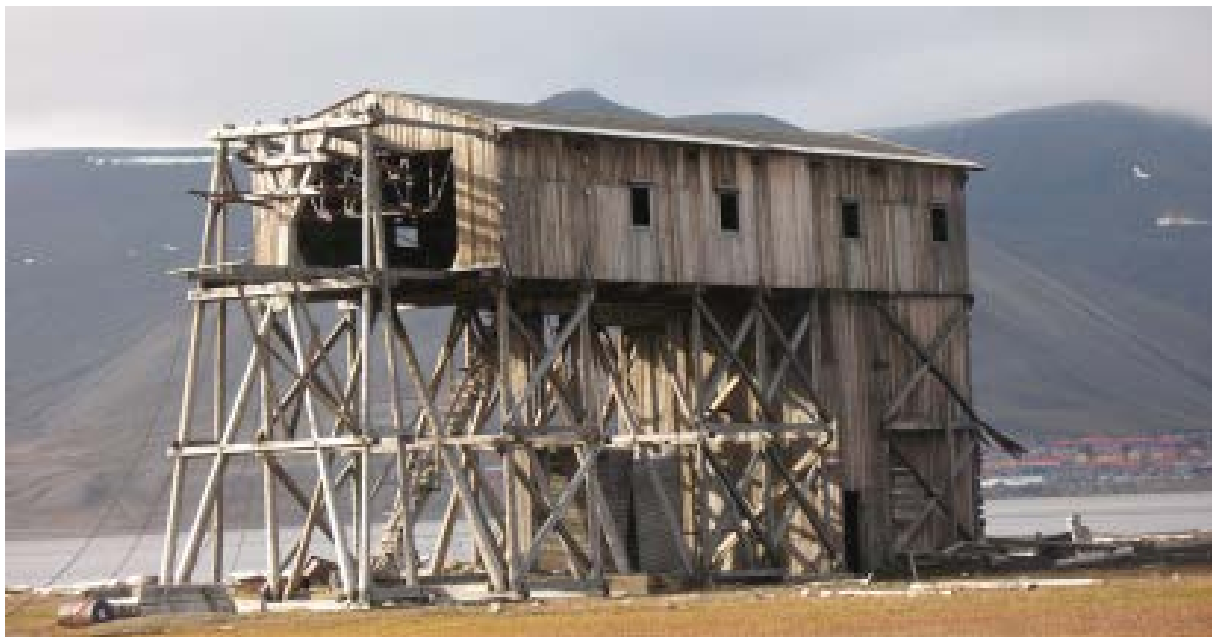
Foto 24. Taubanesentralen på Hiorthhamn. Mesteparten av treverket står ikke i direkte bakkekontakt, men står på støpte fundamenter. Treverket er derfor mindre utsatt for soppangrep. Foto: AC Flyen, NIKU
