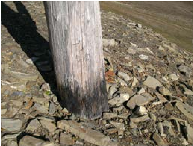
Foto 26 I mange tilfeller var det ikke noen synlige tegn til råtesoppkader i overflaten av treverket. Misfargingen skyldes opptrekk av kullpartikler og ikke svertesopp/råtesopp. Foto: J. Mattsson, Mycoteam
