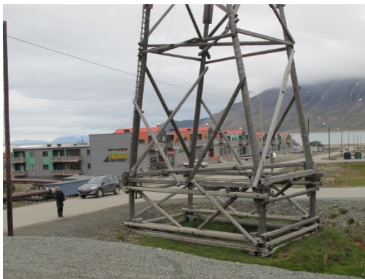
Foto 17 Ekstra strenge sikkerhetskrav må gjelde for råtesoppskadede taubanebukker inne i Longyearbyen. Foto: J. Mattsson, Mycoteam
