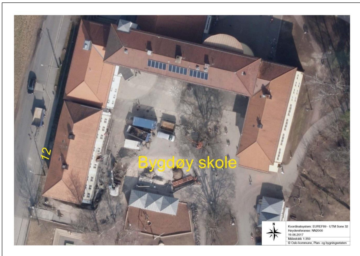
Figur 65 - Flyfoto fra 2014 som viser at det har foregått gravearbeid innenfor skolegårdens nordøstre hjørne. Kart utarbeidet av Oslo kommune, Plan- og bygningsetaten.
