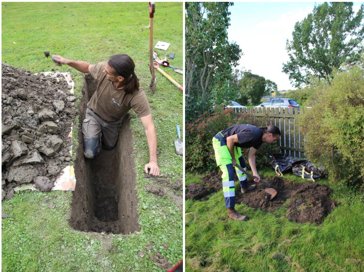
Figur 5: Manuel Gabler fra NIKU graver prøvestikk/-sjakt i Claus Borchs vei 3 - delprosjekt A3 (venstre) og Lørenveien 18 – delprosjekt B2 (høyre). MK/NIKU.
