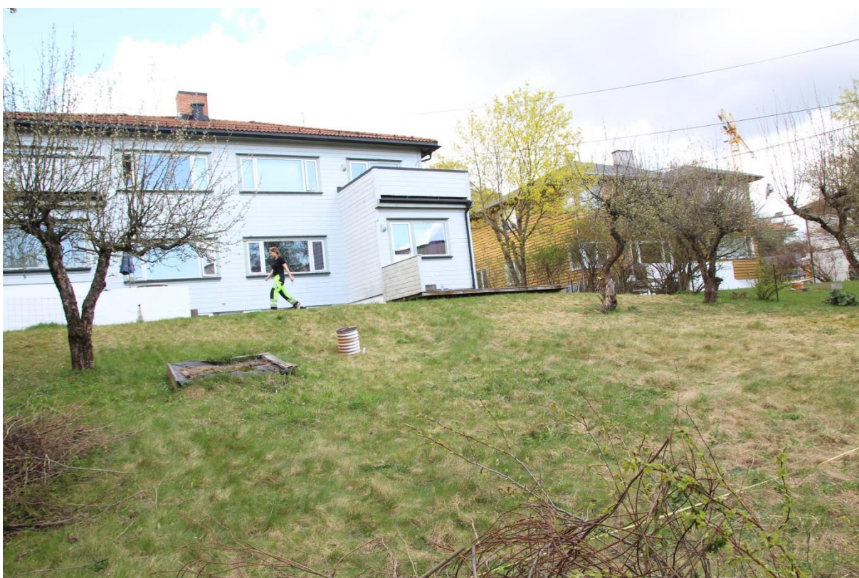
Figur 19 - Delområde B6, Lørenveien 26 sett mot øst. Foto: IH/NIKU.
