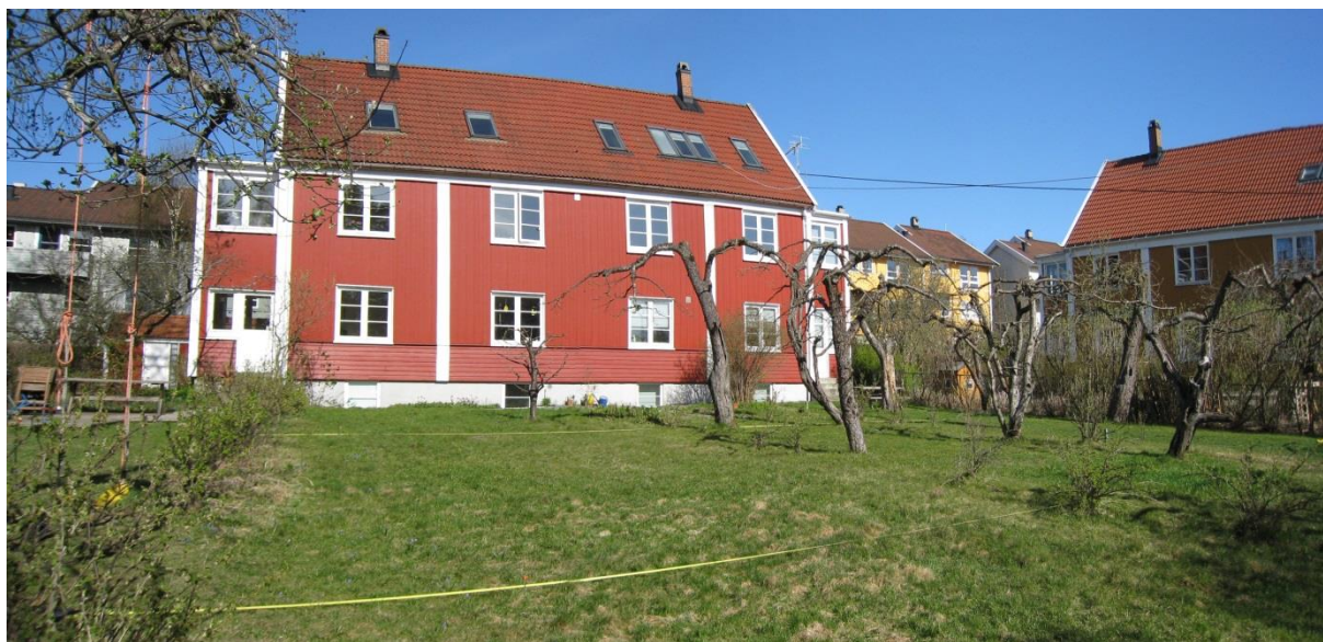
Figur 10 - Delområde A2, Ugleveien 6 sett mot nordvest. Foto: MK/NIKU
