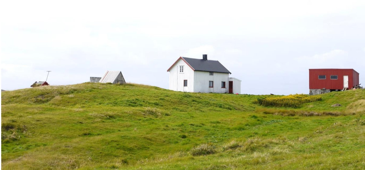
18150110098: Prosentvis tap av SEFRAK-bygninger har vært noe lavere i spredtbygde områder enn i tettbygde i alle omdrev av kontrollregistreringen, mens andelen truete/sterkt truete SEFRAK-bygninger er høyest i spredtbygde områder. Hysvær i Vega kommune. Foto: Å. Dammann/NIKU 2013
