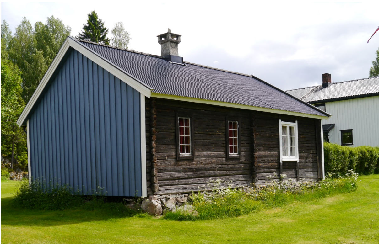
04200001039: 28 % av de gjenstående SEFRAK-bygningene er registrert med minste endringsgrad (C-endring). Mye av det alminnelige bygningsvedlikeholdet faller inn under denne kategorien, blant annet ny takteking, som på dette våningshuset i Eidskog. Foto: K. Fageraas/NIKU 2012
