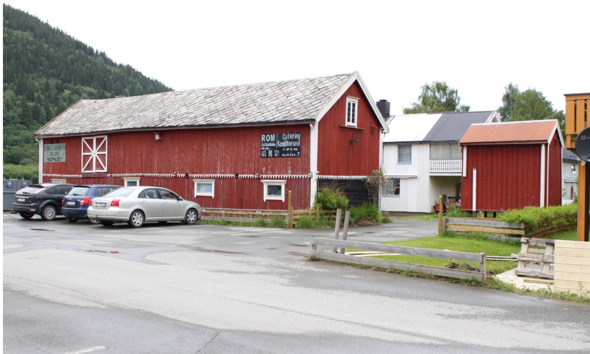
16530018045: I tettbygde områder, som Lundamo langs E6 gjennom Melhus, er andelen bygninger som er tapt på grunn av riving høyere enn i spredte områder. Økt tilflytting gir økte tomtepriser og høyere arealutnyttning, og innklemt, eldre bebyggelse er utsatt. Foto: J.C. Eldal/NIKU 2013
