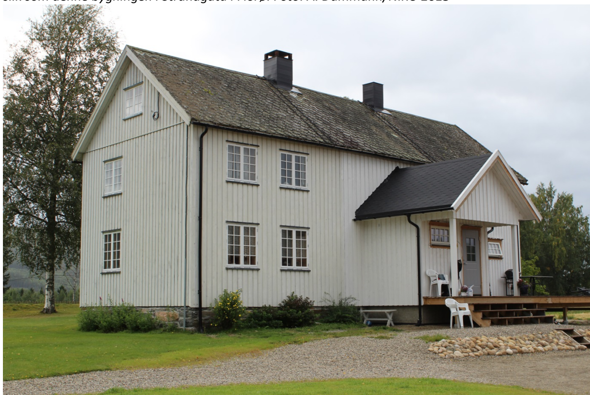
17360010059: 15 % av de gjenstående SEFRAK-bygningene har liten volumendring (B-endring), for eksempel et tilbygd inngangsparti, som dette våningshuset i Snåsa. Foto: R. Meyer/NIKU 2013
