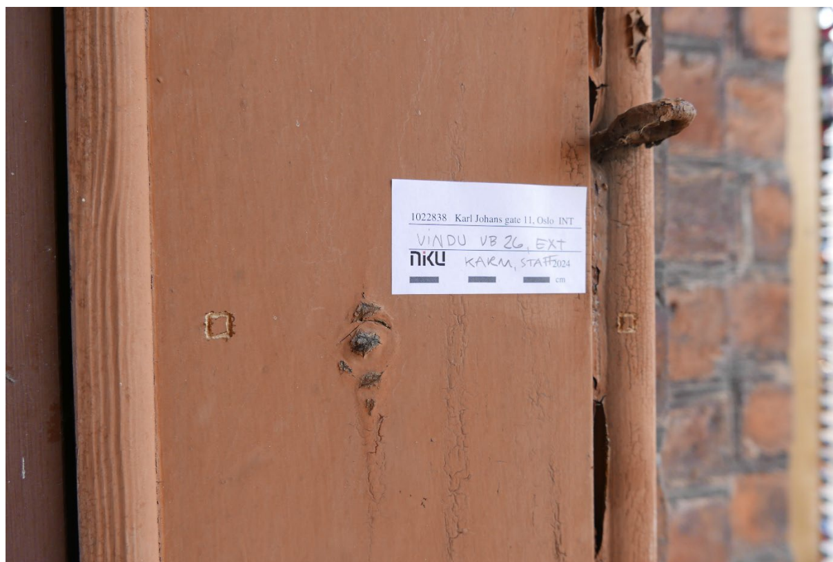
Figur 24 VB23. Eksteriør karm og staff. Uttaksted materialprøver.
