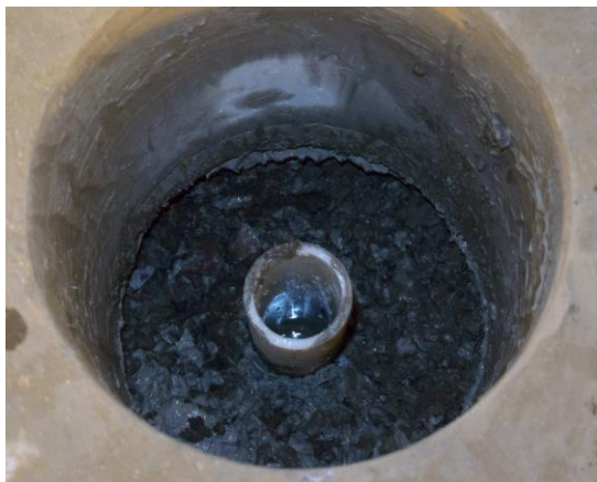
Miljøbrønn 5 ble spylt og rengjort og senket ned i gulvet april 2014
