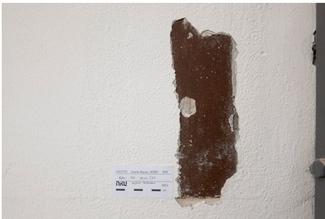
Figur 45 Rom 231. Nord for trappa mellom rom 231 og 225 er det avdekket et vertikalt felt med mørk rødbrun linoljemaling. Kodet til NCS S 7020-Y80R/7010-Y90R (ikke korrekte koder, mangler dybde). Dekoren er ikke kartlagt. Foto: NIKU, 2023.
