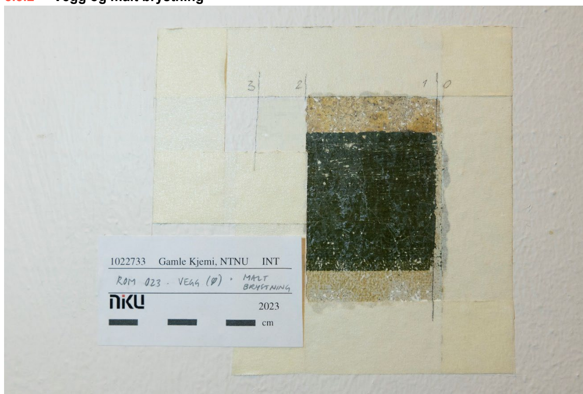
Figur 20 Rom 023. Avdekking av tidligere malte brystninger på østveggen. Foto: NIKU, 2023.
