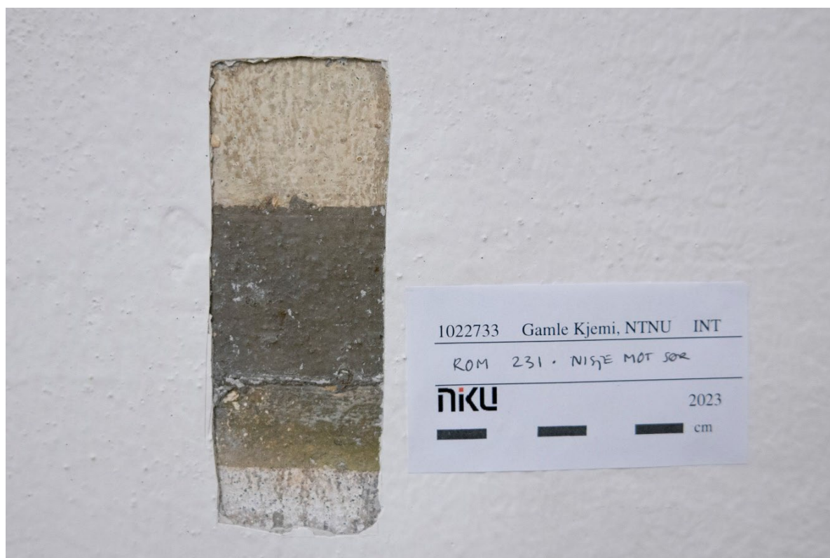
Figur 44 Rom 231. I den høye nisjen i trappa mellom rom 231 og 238 er det avdekket et felt med noe som likner på de malte brystningene ellers i bygningen. Men malingstypene skiller seg fra de andre ved at det her er brukt en vannløselig emulsjonsmaling/limfarge nedfor den malte brystningslisten. Dekoren er ikke kartlagt. Foto: NIKU, 2023.
