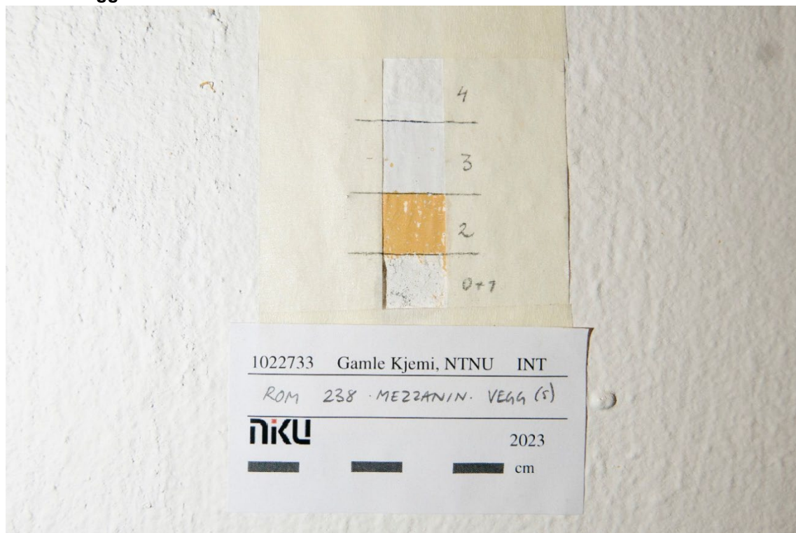
Figur 46 Rom 238. Lagvis avdekking på nordvegg (feil himmelretning på merkelappen). Hvit limfarge. Foto: NIKU, 2023.
