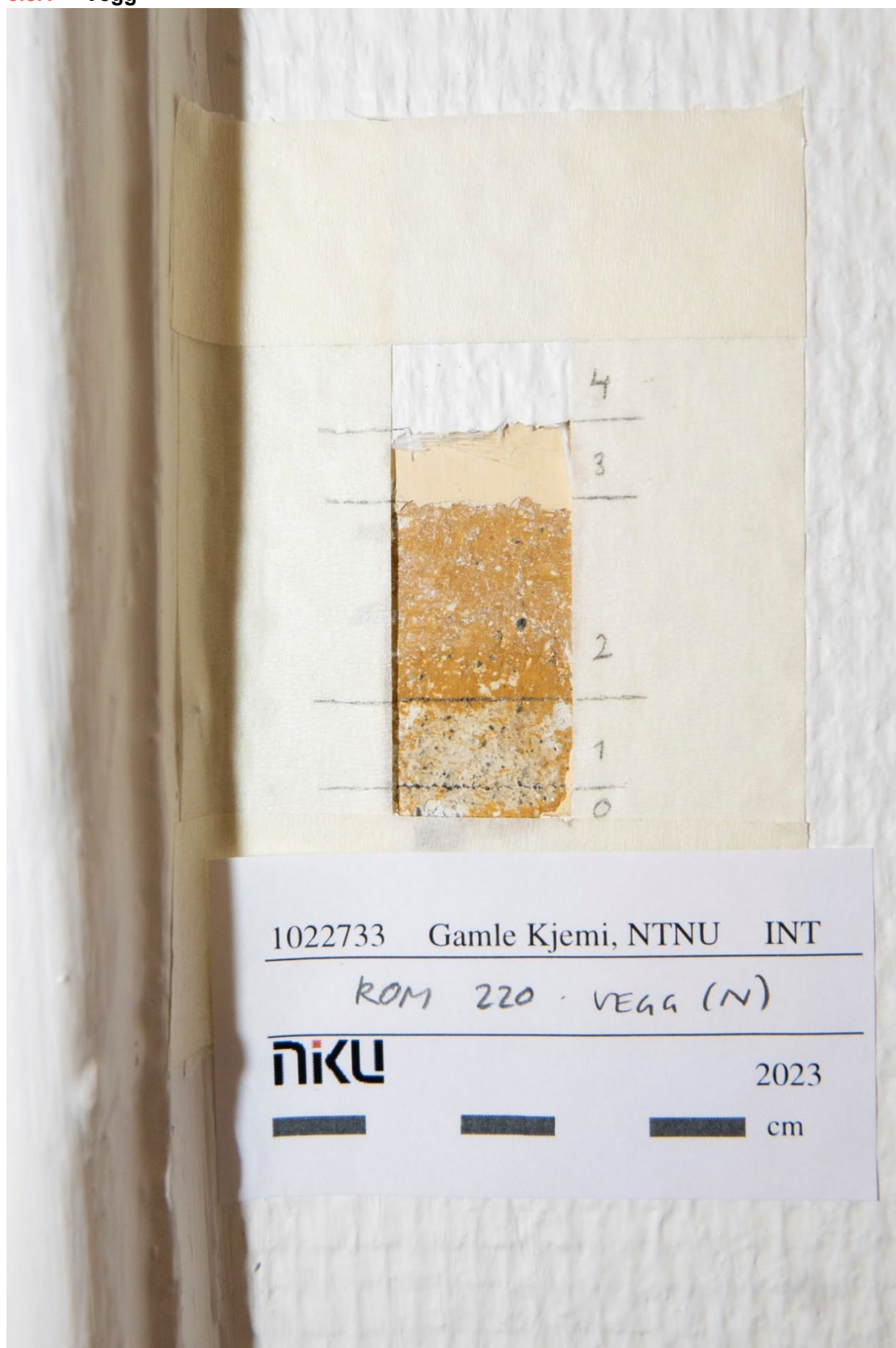
Figur 37 Rom 238. Lagvis avdekking på vegg. Det oransje laget er løselig i lunkent vann. Samme farger er malt på hele veggen. Foto: NIKU, 2023.
