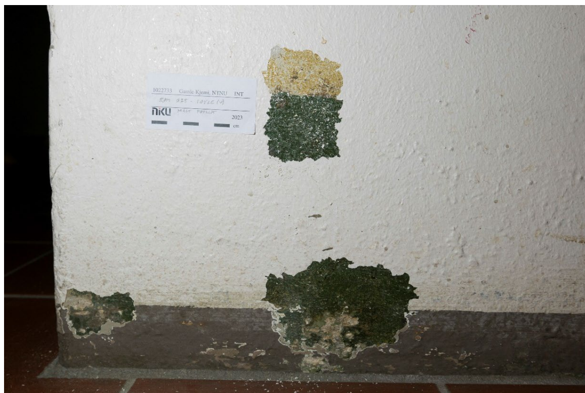
Figur 31 Rom 025. Avdekking av tidligere malt fotlist og feielist på vestsiden av søylen i rommet. Feielisten er svært nedbrutt. Foto: NIKU, 2023.
