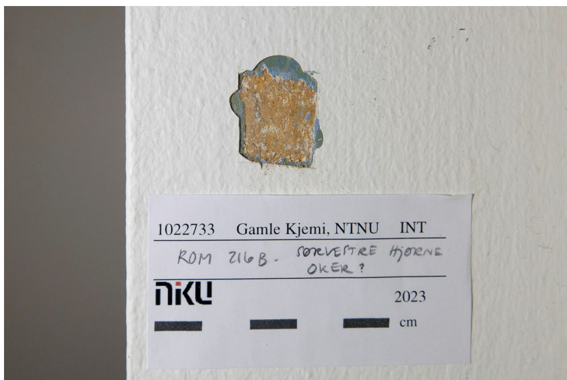
Figur 49 Rom 216B. I sørvestre hjørne i trappa er det avdekket et okerfarget lag nederst mot pussen. Dette er kun funnet her, og ikke andre steder i trapperommet. Laget er trolig en tykk seis, men omfanget er ikke kartlagt. Foto: NIKU, 2023.
