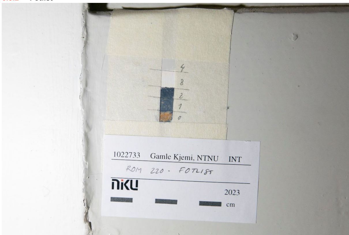
Figur 40 Rom 220. Lagvis avdekking på fotlist mot nord. Foto: NIKU, 2023.
