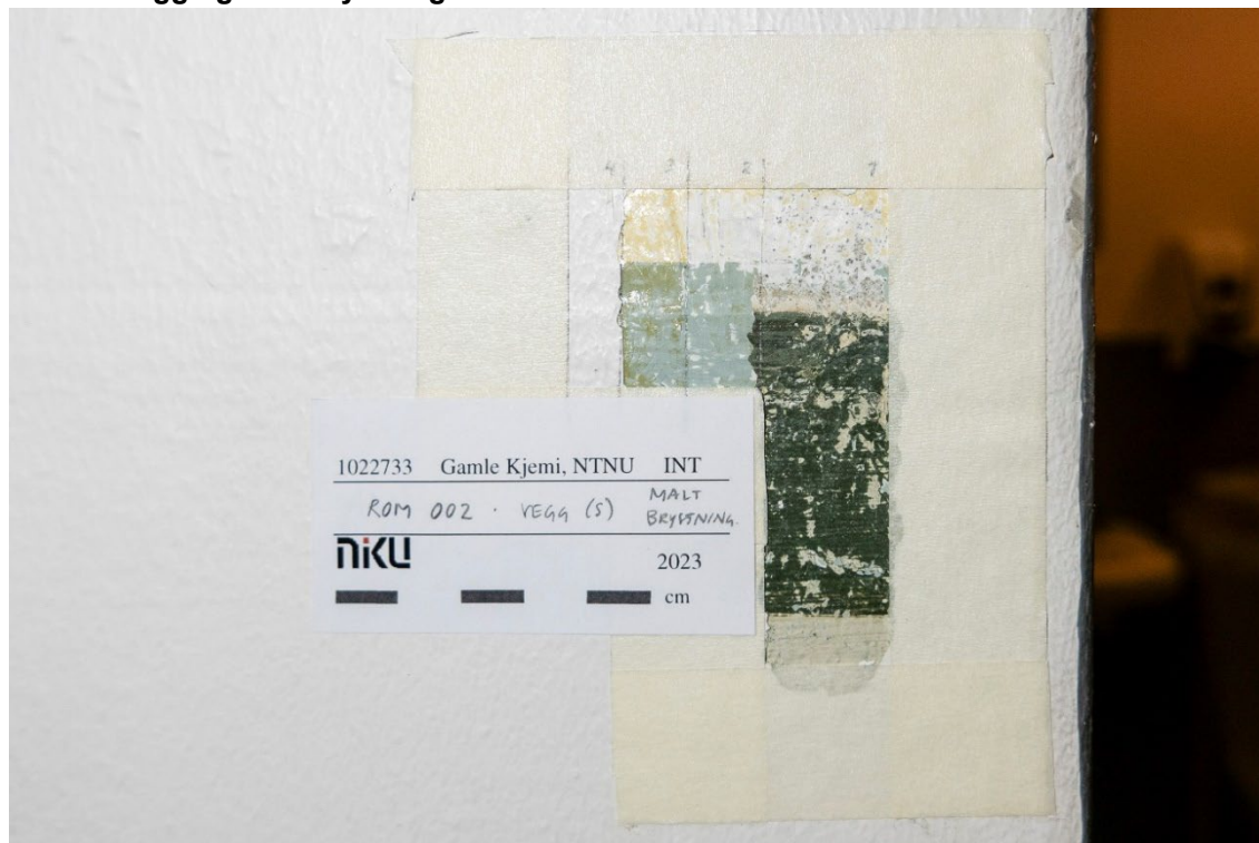
Figur 13 Rom 002. Avdekking av tidligere malte brystninger på sørveggen. L2 (med mørk grønn brystningslist) er malt i samme høyde som L1 (hvit brystning uten malt list). Begge brystningen er malt som en fortsettelse av brystning i rom 025, 023 og 002A. Den misfargede lakken, som også er funnet i rom 023 og 025, ligger over den gråblå brystningen som også er funnet i rom 123. Man kan derfor fastslå at lakken er påført relativt seint, mulig ved oppussingen på 1970-tallet. Foto: NIKU, 2023.
