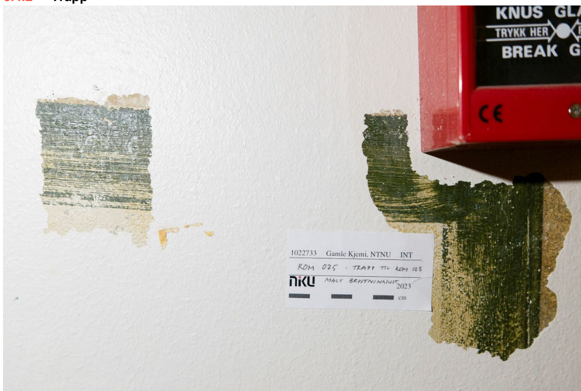
Figur 34 Rom 025. Avdekking av tidligere malt brystning og brystningslist i trappen. Lista er malt som en fortsettelse av lista i rom 025. Foto: NIKU, 2023.
