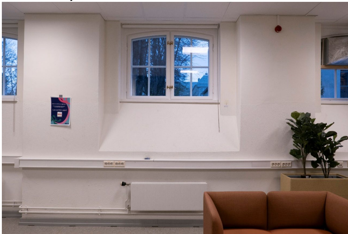
Figur 16 Rom 012. Pussen på nordveggen og i vindusnisjene er nyere. Foto: NIKU, 2023.
