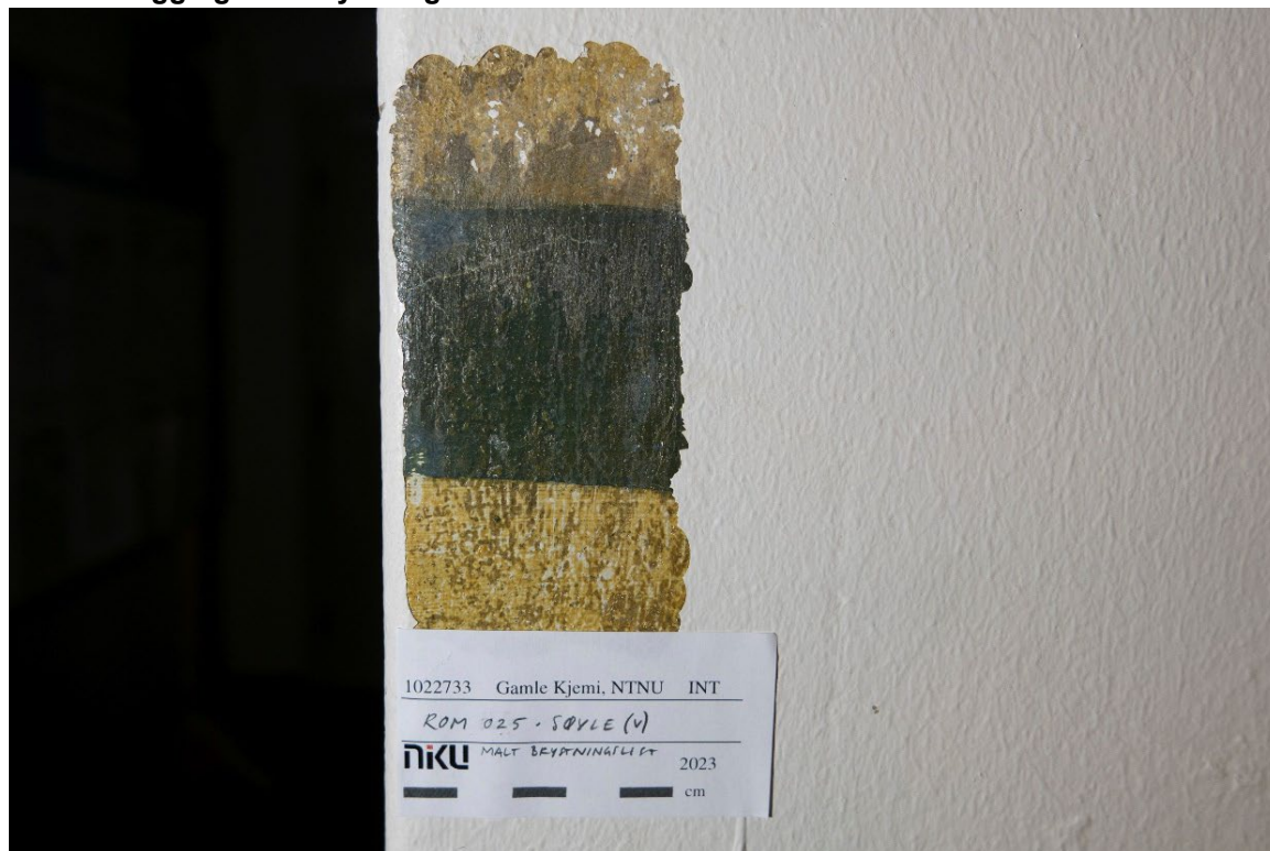
Figur 30 Rom 025. Avdekking av tidligere malte brystninger på vestsiden av søylen i rommet. Foto: NIKU, 2023.
