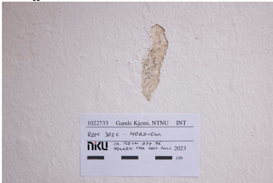
Figur 50 Rom 302C. Det er funnet små spor etter et mørkere lag, men laget er ikke sammenhengende og er funnet i forskjellige høyder. Laget er ikke tolket som et malingslag og er ikke kartlagt. Ellers kun hvite lag. Foto: NIKU, 2023.
