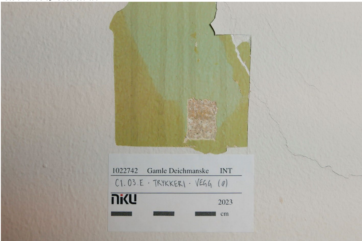
Figur 3 Vegg. Emulsjonsmaling eller oljemaling. Grå. Tynn, transparent lakk. Sparkel og grønn oljemaling (NCS S 2020-G30Y/2010-G30Y) er vurdert som et sekundært lag. Foto: NIKU, 2023.
