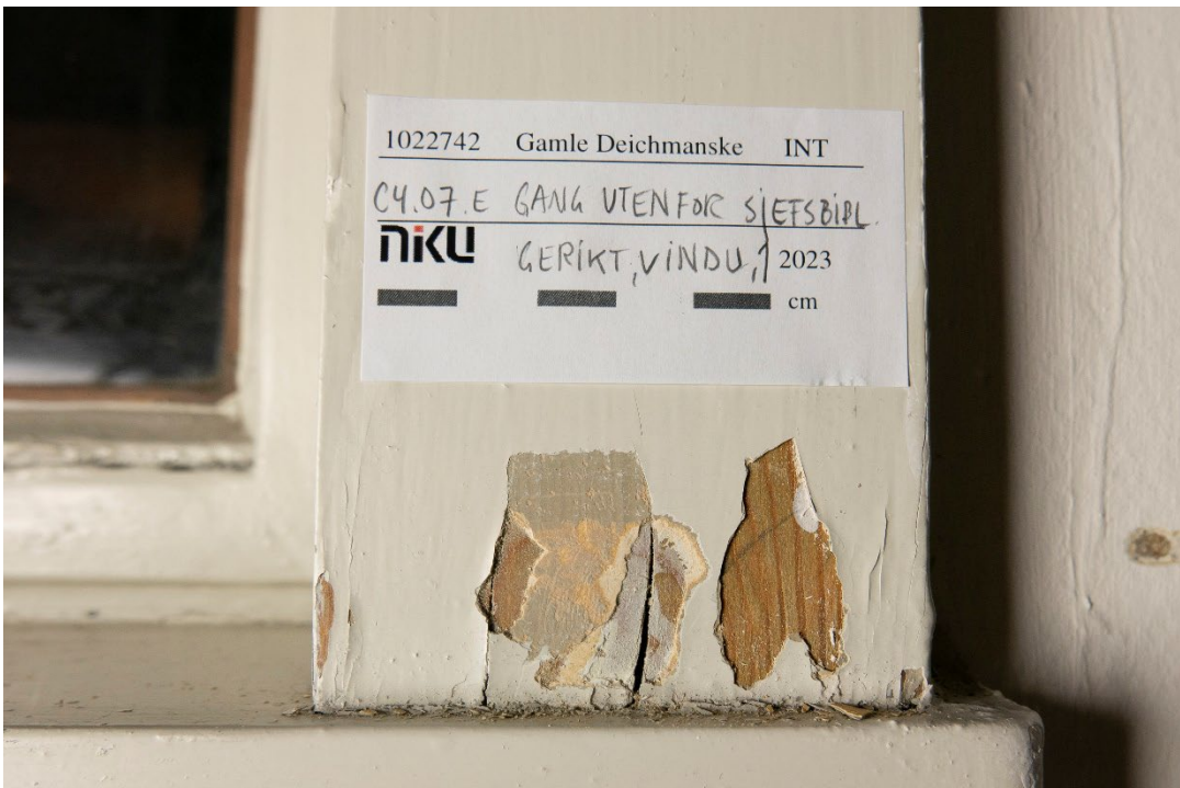
Figur 3 Vindusgerikt. Oljemaling. Grå. Foto: NIKU, 2023.
