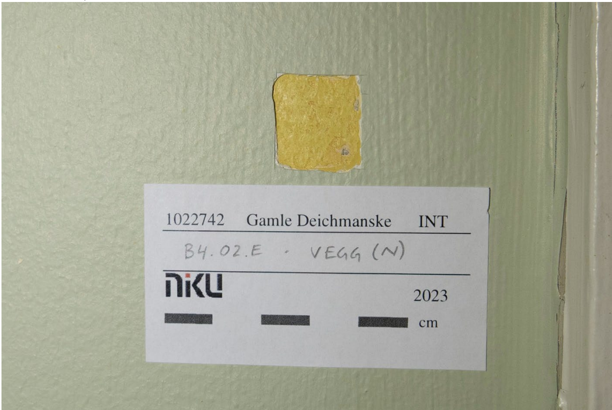
Figur 2 Vegg. Emulsjonsmaling eller oljemaling. Gulgrønn. Foto: NIKU, 2023.
