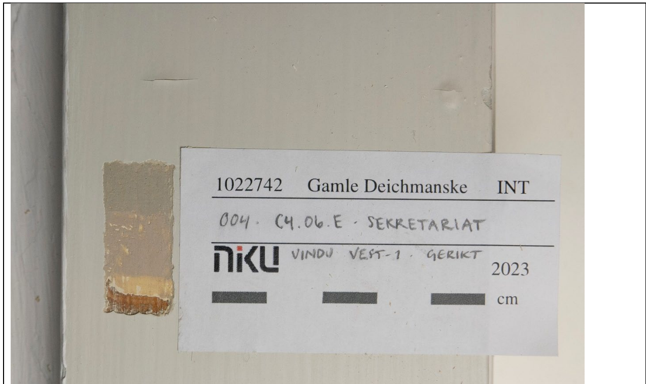
Figur 5 Vindusgerikt. Oljemaling. Lys gråbeige. Foto: NIKU, 2023.
