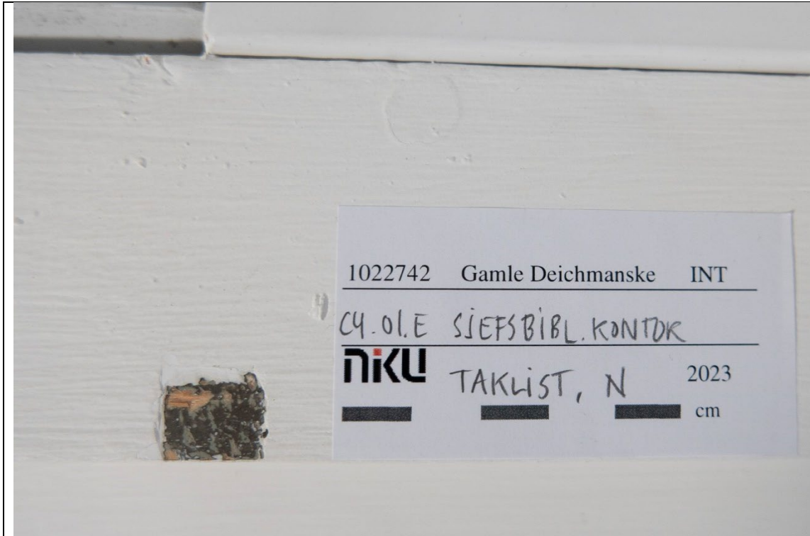
Figur 8 Taklist. Oljemaling og lakk. Mørk grå/svart. Foto: NIKU, 2023.
