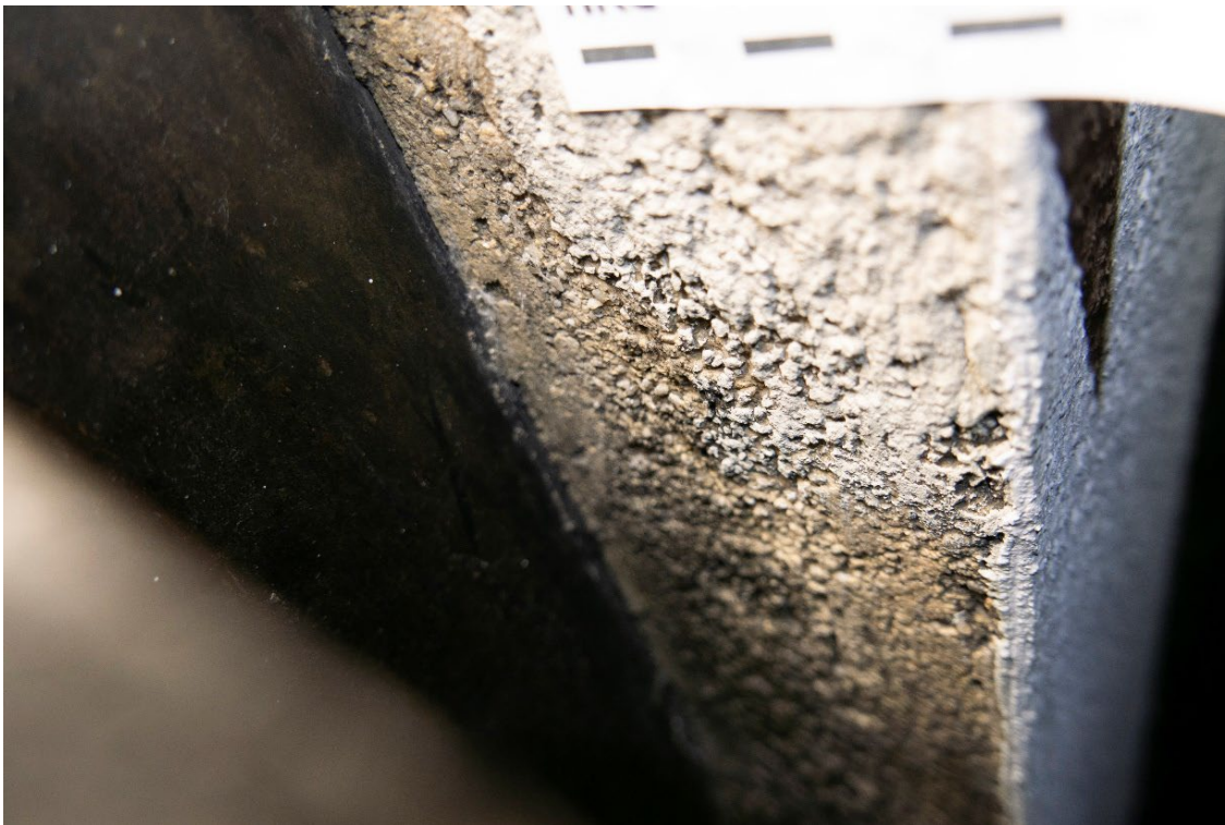
Figur 3 Pusset del av kvadratiske søyler. Uovermalt flate på utilgjengelig områder på side inn mot trapp. Foto: NIKU, 2023.
