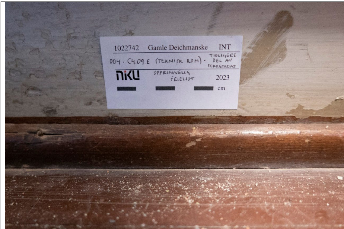
Figur 8 Fotlist. Opprinnelig list funnet bevart i teknisk rom i C4.09.E. Rødbrun og transparent oljemaling. Foto: NIKU, 2023.
