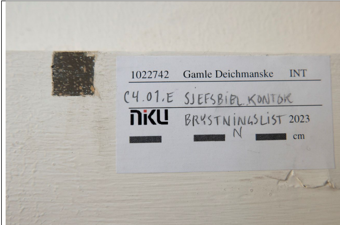
Figur 16 Brystningslist. Oljemaling og lakk. Mørk brun/svart. Foto: NIKU, 2023.
