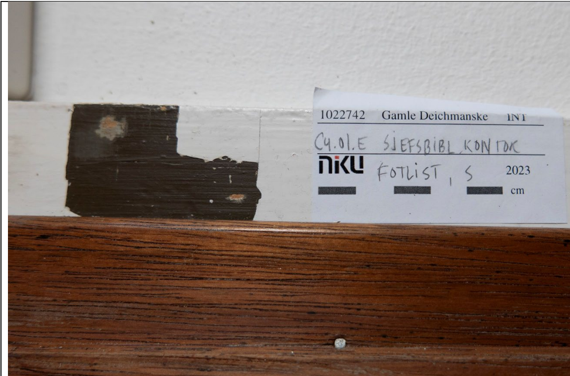
Figur 22 Fotlist. Oljemaling og lakk. Mørk grå/svart. Foto: NIKU, 2023.
