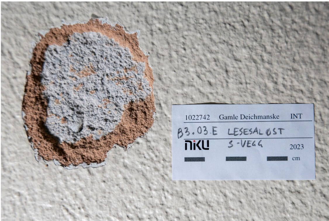
Figur 7 Vegg i B3.03.E. Innfarget puss med marmortilslag. Rødbrun. Foto: NIKU, 2023
