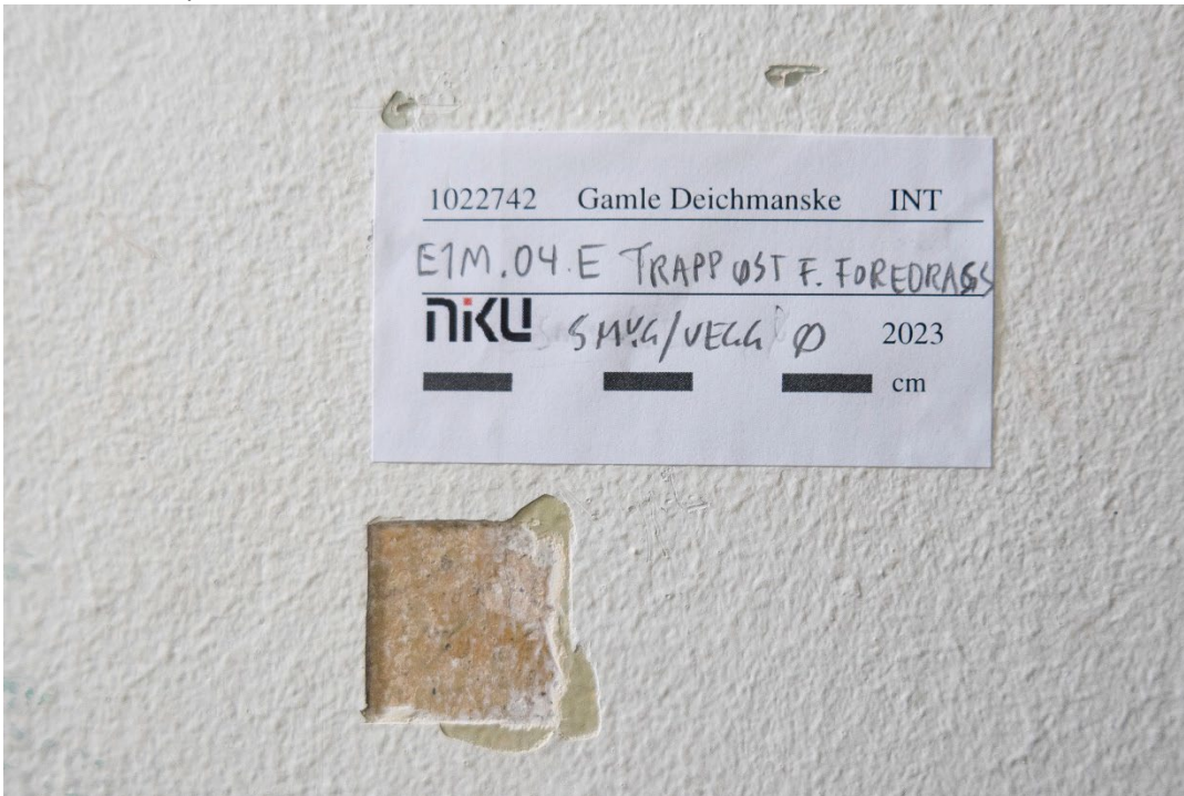
Figur 2 Vegg. Emulsjonsmaling eller oljemaling. Tynn, transparent lakk. Grå. Foto: NIKU, 2023.
