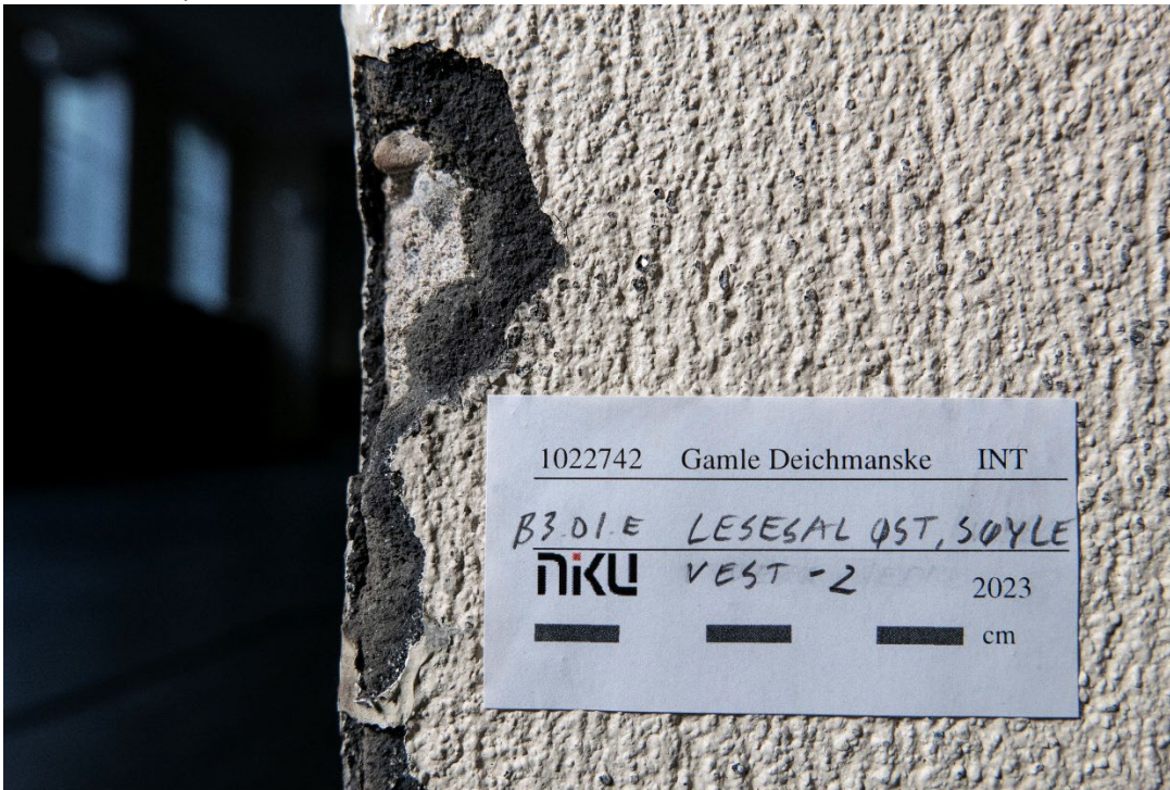
Figur 3 Kvadratiske søyler mellom de to rommene. Innfarget puss med marmortilslag. Sannsynligvis overpigmentert mørtel, ettersom pusslaget smitter kraftig. Foto: NIKU, 2023.
