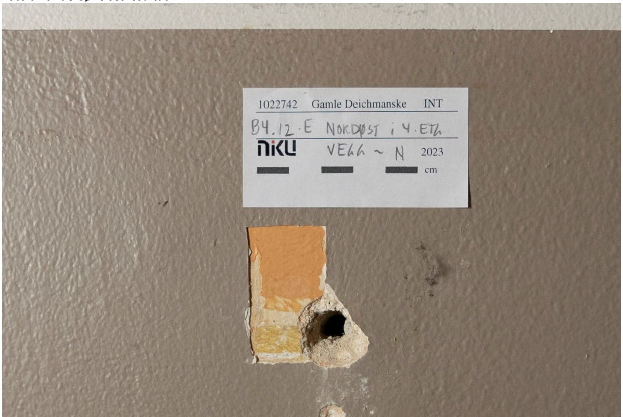
Figur 2 Vegg. Emulsjonsmaling eller oljemaling. Grålig rød. Foto: NIKU, 2023.
