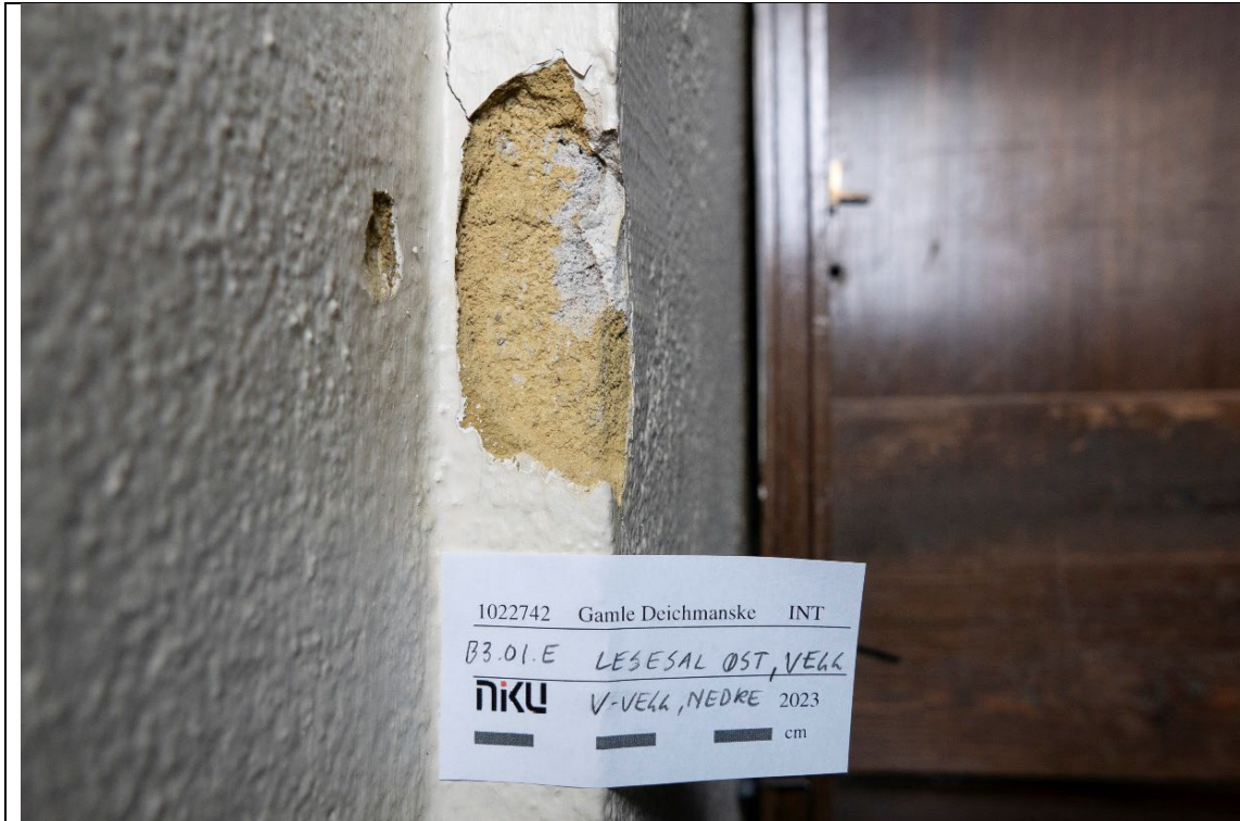
Figur 6 Vegg i B3.01.E. Innfarget puss med marmortilslag. Gul. Foto: NIKU, 2023.
