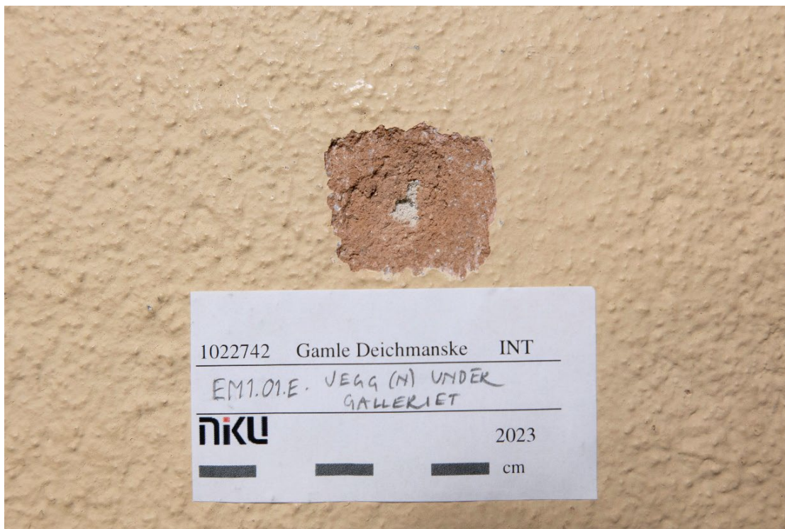
Figur 10 Vegg i rom under galleriet. Vegg. Innfarget puss med marmortilslag. Lys rødbrun. Foto: NIKU, 2023.
