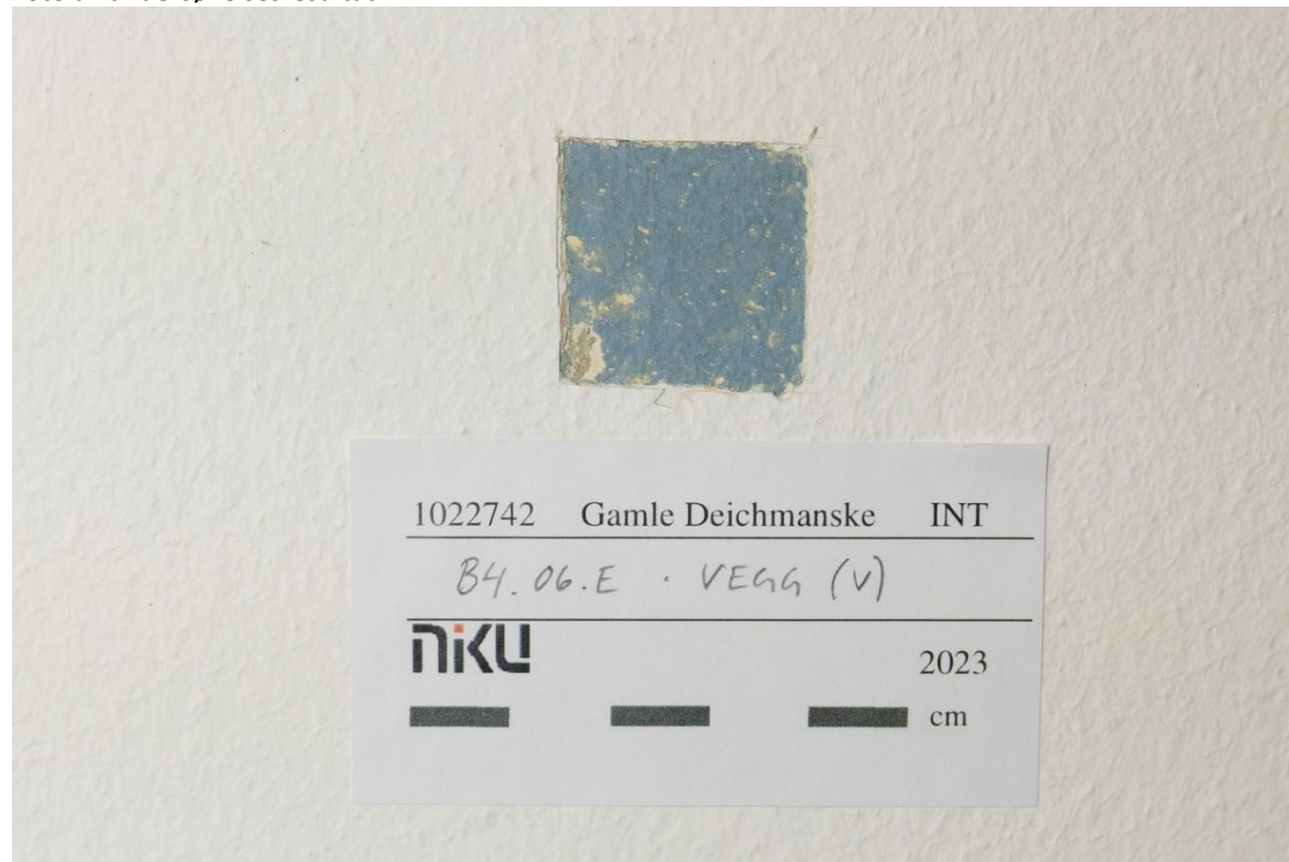
Figur 2 Vegg i B4.06.E. Emulsjonsmaling eller oljemaling. Blå. Foto: NIKU, 2023.
