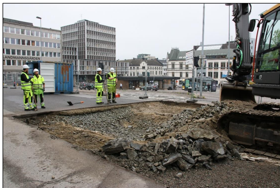
Figur 3. Oppstart arkeologisk overvåking, foto mot sørvest. Cf55620_NIKU_0002.JPG
