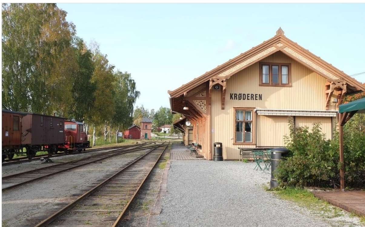
Figur 41 Stasjonsbygning og godshus, vanntårn i bakgrunnen. Foto: NIKU 2023.
