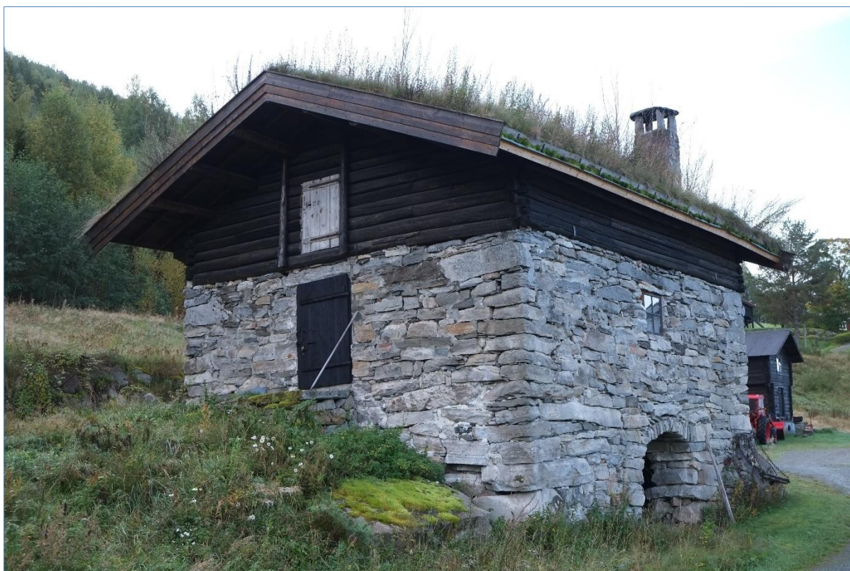
Figur 14 Bratterud. Steinfjøs/låve. Foto: NIKU 2023.
