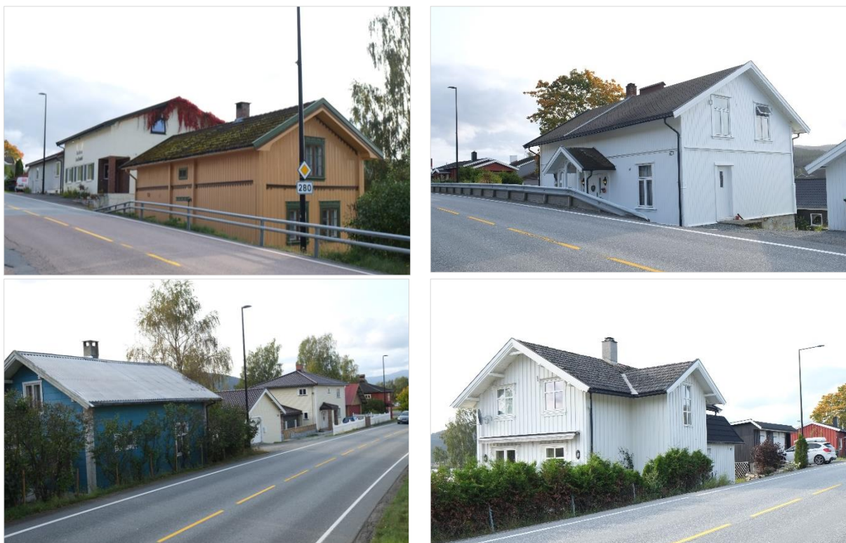
Figur 30 Eldre bygninger langs Krødergata. Foto: NIKU 2023.
