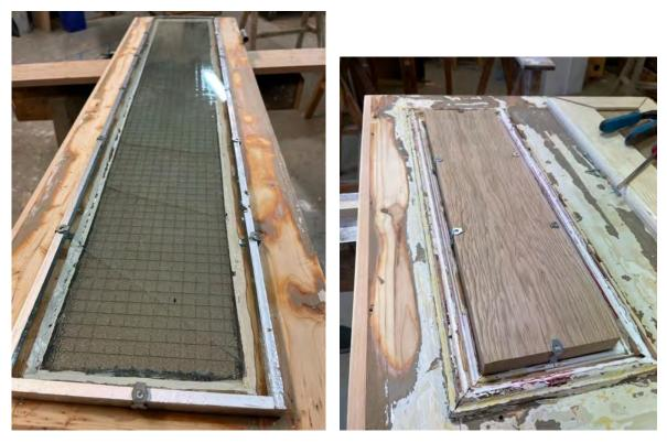
Figur 3 Glasset, levert i aluminiumsramme, ble festet med tilklipte hullbånd og skruer. Skruene ble satt rett ned i ramtreet. Foto: Kris & Kjells Møbelsnekkeri AS
