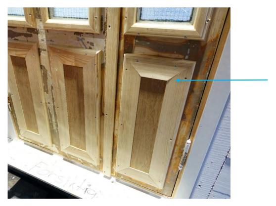
Figur 7 På baksiden av døren ved målepunkt TC25. Øvre list ligger ikke i plan med de to vertikale listene i hjørnene og det har trolig vært en avstand mellom listen og treplaten. Kanskje har dette forårsaket den lokale temperaturstigningen ved TC25. Foto: André Korsaksel/Byantikvaren i Oslo
