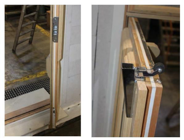
Foto 5: Bilde til venstre viser passiv fløy med innfelt volumøkende list, sluttstykke og kantskåte. Bilde til høyre viser toppen på aktiv fløy med innfelt volumøkende list og dørlukker.
