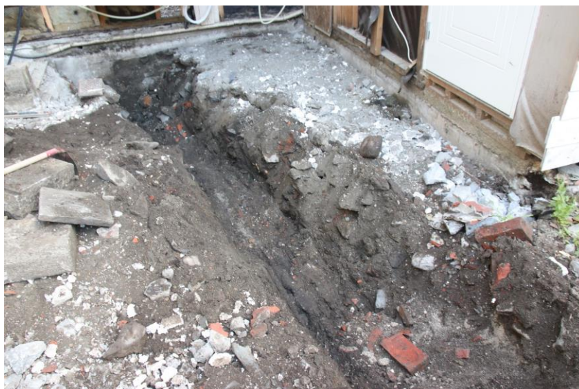
Figur 10. Ferdiggravd dreneringsgrøft i bakgården til Jomfrugata 5. Sett mot NØ. Da64001_011.
