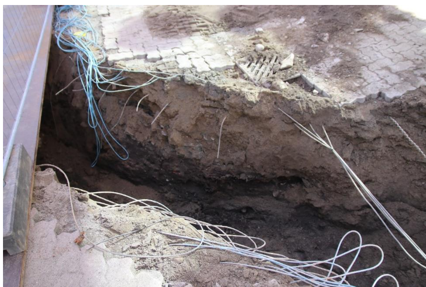
Figur 6. Nordre del av tverrgående vannledningsjakt. Oversikt. Sett mot V. Da64001_006.
