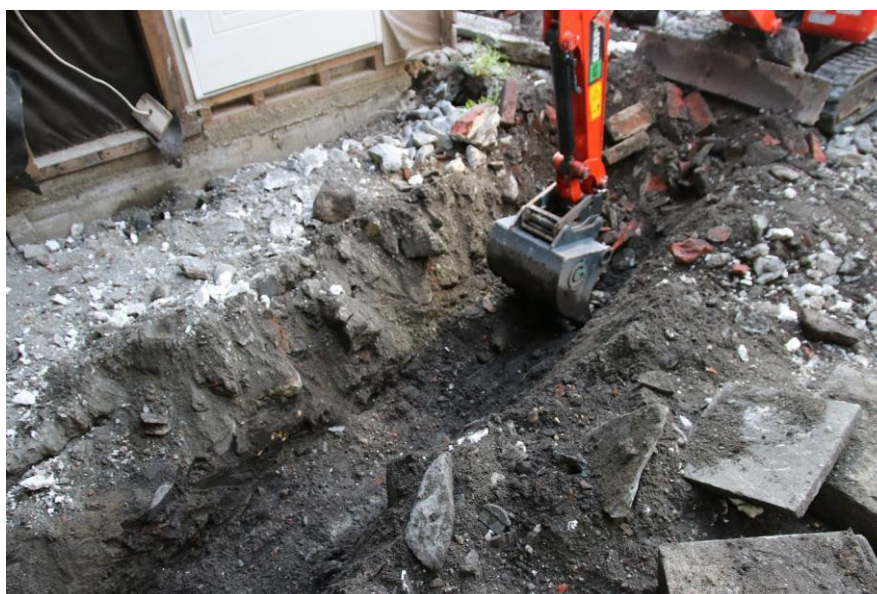
Figur 11. Dreneringsgrøften i bakgården til Jomfrugata 5 under graving. Sett mot SØ. Da64001_010.
