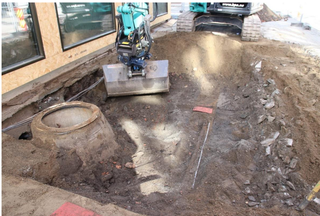
Figur 3. Delvis utgravd grop for fettsskille langsmed grunnmuren til Jomfrugata 3. Sett mot V. Da64001_001
