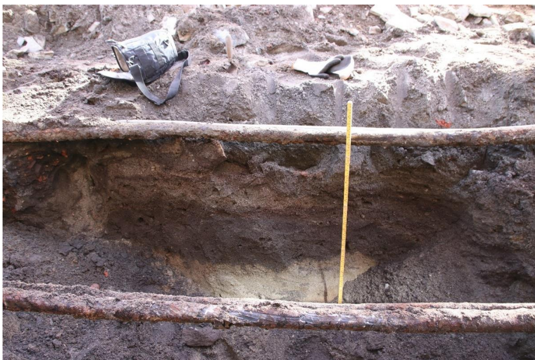
Figur 4. Profil 1. Parti med kulturlag (dyrkingsjord og etterreformatoriske lag) over elvesand i nordre profilvegg til gropen til fettutskiller. Sett mot N. Da64001_002
