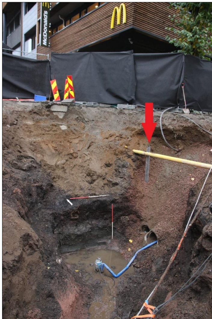
Figur 17. Borepunkt SK4012 med brønnrør markert med rød pil fra prosjektet Rådhusgaten, nedre del – overvannsprosjektet 2020 . Cf53984_NIKU_875143.
