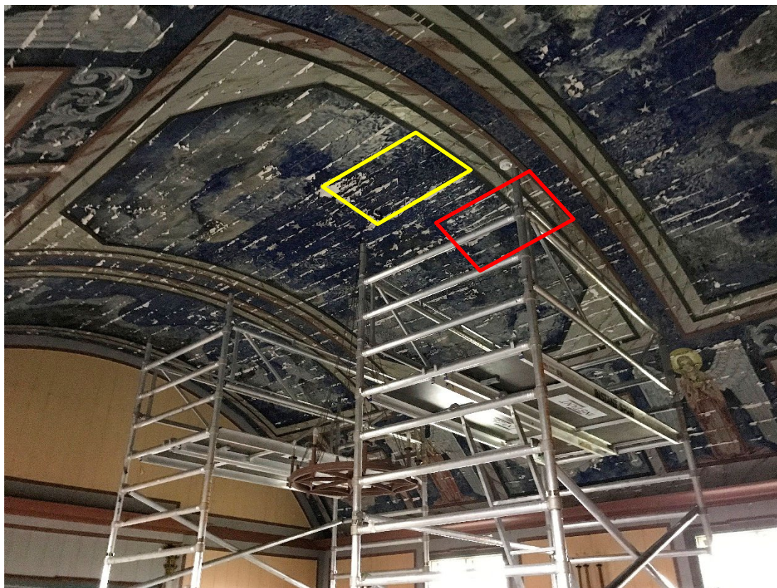
Figur 1 Detalj av takmaleriet i Blaker gravkapell. Rød firkant viser området der testfelt for konsolidering ble oppført i 2022. Gul firkant viser område der det ble konsolidert i 2023.
