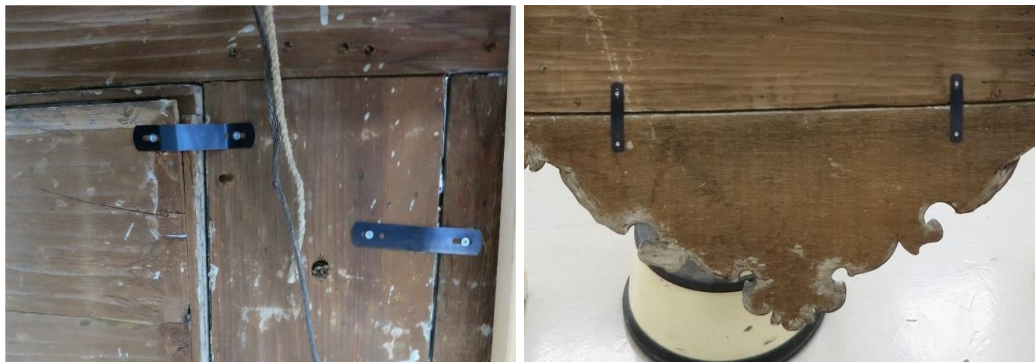
Fig 22. Montering av beslag på epitafiets bakside for å stabilisere konstruksjonen og gjøre den tryggere å håndtere
