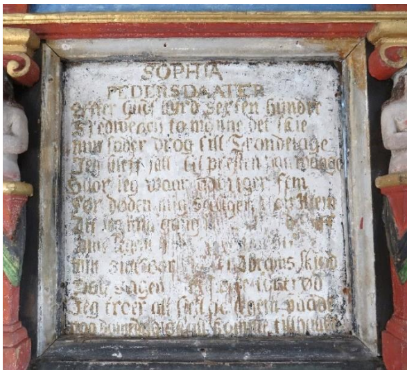
Figur 5 Utsnitt, innskriftsfeltet før behandling. Opprinnelig et sortfarget felt med forgylte bokstaver. Original sort farge er nesten helt tapt og i dag ses nesten kun den hvite grunderingen
