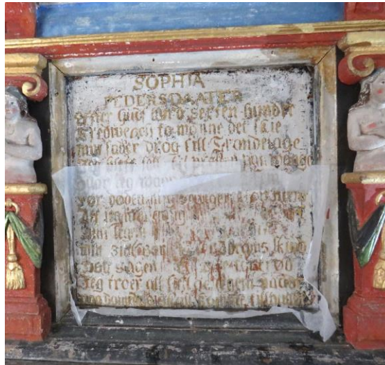
Figur 14 Underveis i flatekonsolideringen av innskriftsfeltet
