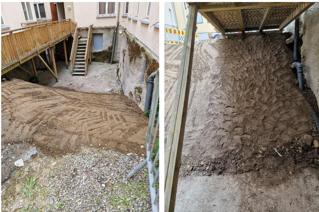
Figur 7: Miljøprofil 1 og skråning ned mot betonggulv etter tildekking med egnede masser. T.v.: Sett mot øst. Foto: Da64649_0009. T.h.: Sett mot vest. Foto: Da64649:0010.
