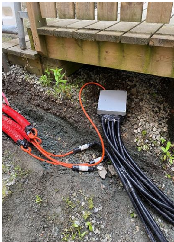
Figur 13: Vanntett koblingsboks, denne ble gravd ned i grusmassene. Foto: Cautus Geo AS.
