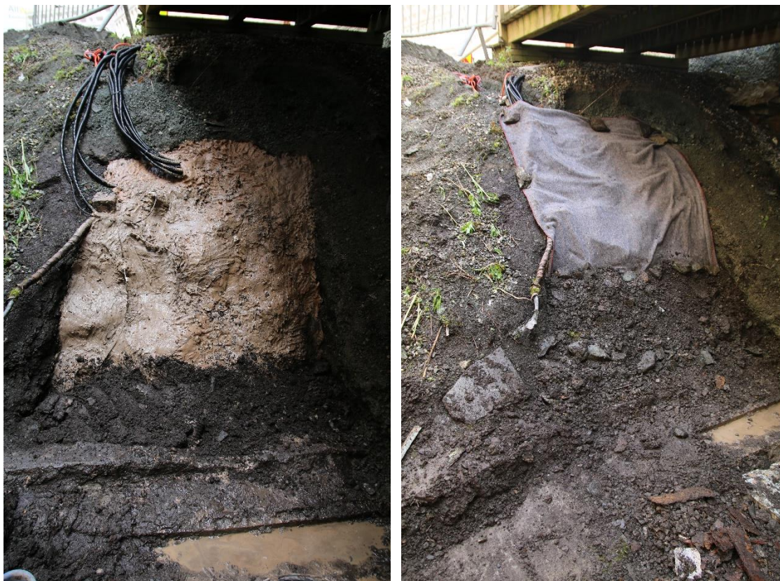
Figur 6: Miljøprofil 1 etter tildekking med leire, og midlertidig tildekket før tilbakefylling av masser. Sett mot vest. Foto: Da64649_0007, Da64649_0008.
