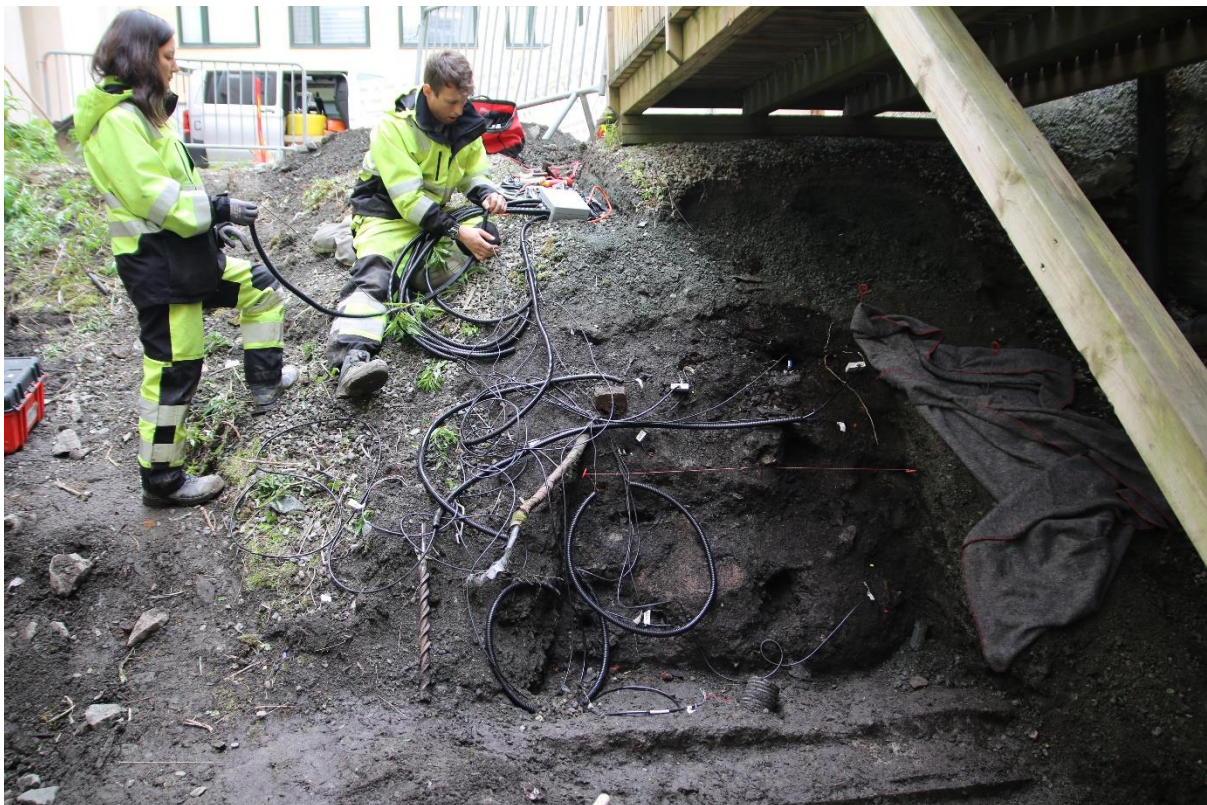
Figur 3: Installasjon av sensorer ble utført av Cautus Geo AS. Sett mot vest. Foto: Da64649_0004.
