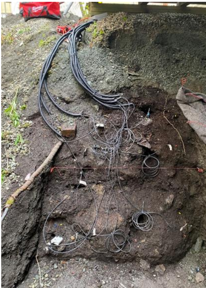
Figur 12: Jordprofilen i Kjøpmannsgata 16 ferdig instrumentert, før tildekking. Foto: Cautus Geo AS.
