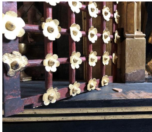
August 2023. Metallgitteret var blitt åpnet av kirkens brukere og en av kilene lå løst. Gitteret ble igjen lukket i halvåpen posisjon.
