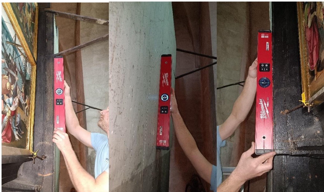
Figur 24. Viser hvor vatermålinger på skapets baksider utført. Bildene er ifra måling 3. Numrene i gul boks på bildet viser til tallene i Tabell 2.
