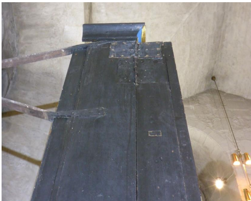
FOTO 1: Stabiliserende stag, nordre side.
