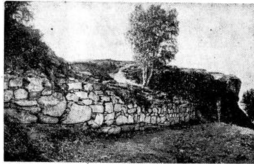
Ovenfor en del av borgens avdekte murrester med brønnen i nærheten. Treet på billedet vokser ved brønnkanten.
