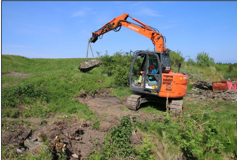
Figur 7. Oversiktskart (NIKU). Undersøkellesområdet innenfor Sverresborg borgruin ID 6869 øverst, og forholdet mellom Gravemaskin i felt. Foto: Da64605_007.
