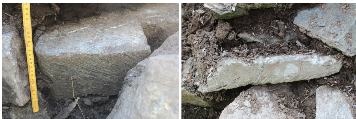
Figur 28B Kvaderstein i brønnen uten spor av «slaget». Figur 28B Diagonalhugging i motsatt retning på nedre kant. Er dette spor av en overhugging over «slaget»? (Foto RM 14.06.2016)
