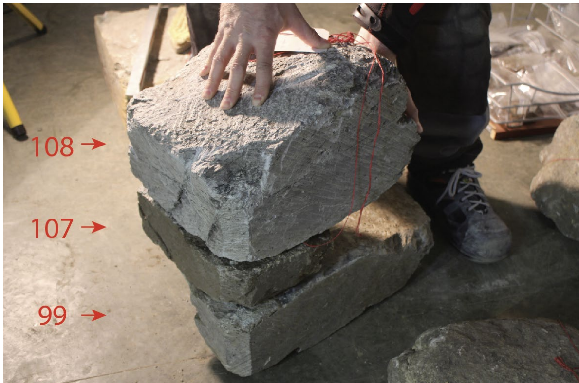
Figur 30 Som et eksperiment ble stein nr.99, nr.107 og nr.108 plassert nedenfra og opp ut fra samsvarende hjørner. Alle tre har avfasede hjørner med breddemål 3,5cm. Steinene kan ha inngått i en felles døråpning men andre tilsvarende steiner kan ha kommet i mellom. De to nederste steinene kan i dette tilfellet ha vært hjørnet i en døråpning med vegglivet til høyre, dørvangen til venstre og døranslaget i bakkant. Den øverste steinen har inngått i døråpningens bue (foto RM 06.10.2016).
