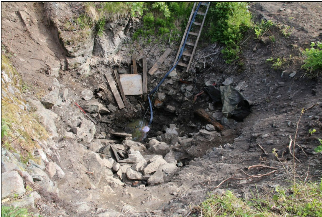
Figur 21. Ansamling med bygningsstein (11) i søndre og sørvestre del av brønnsiden. Bilde tatt ovenfra og mot N. Foto: Da64605_038.
