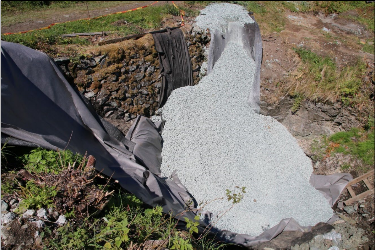
Figur 9. Midlertidig sikring av brønnen med veiduk og pukk som stabilisering. Foto: DA64605_97.
