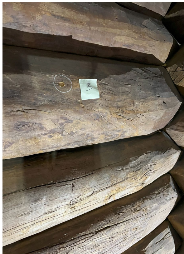
Figur 10 Prøve 3 teken i søndre yttervegg i vestre løa.
