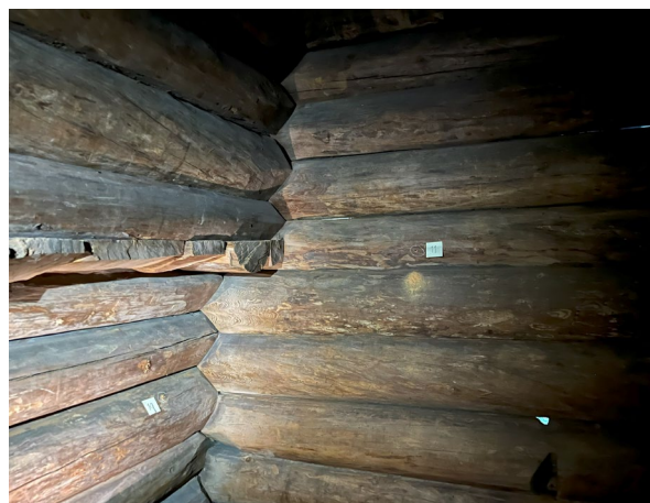
Figur 18 Prøvene 10 og 11 vart tekne i austre delevegg mot underlåven og i yttervegg mot nord.
