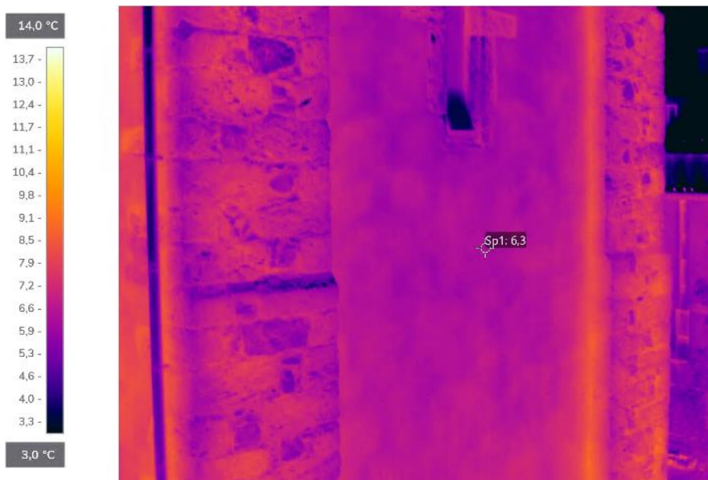
Figur 32 Nordveggen i nordtårnet mot midten av tårnet. Figur: J. Causevic.
