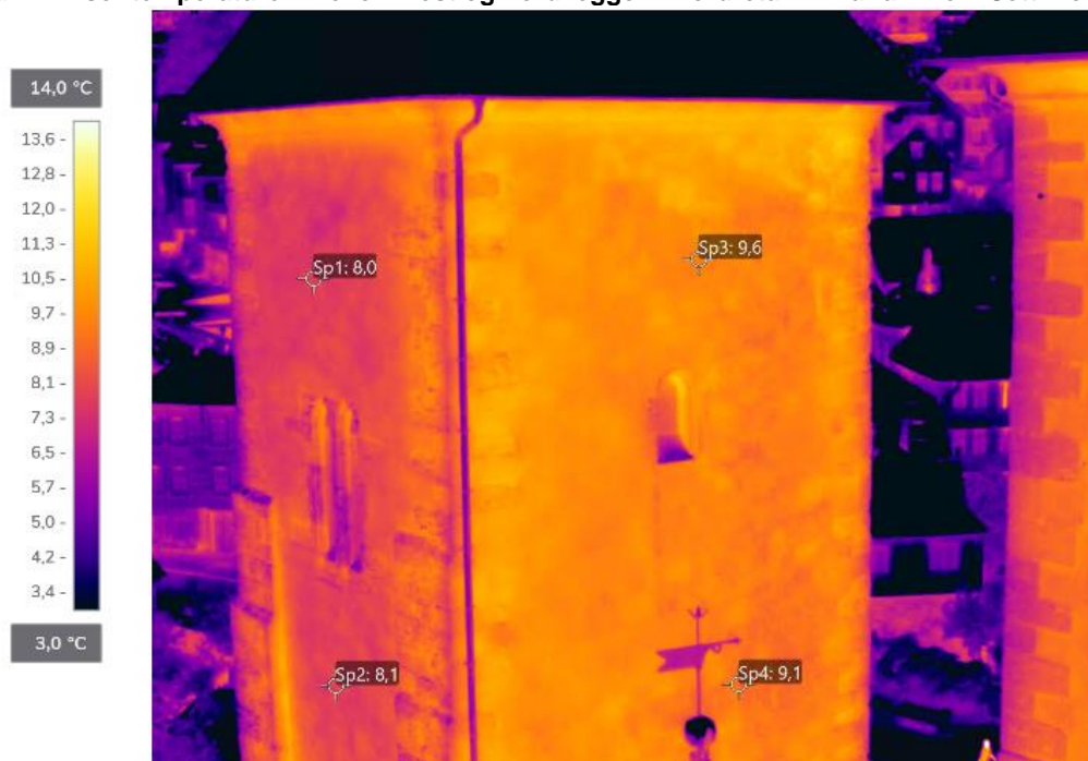
Figur 27 viser temperaturen mellom vest og nordveggen i nordretårn i Mariakirken. Sett mot VSV.
