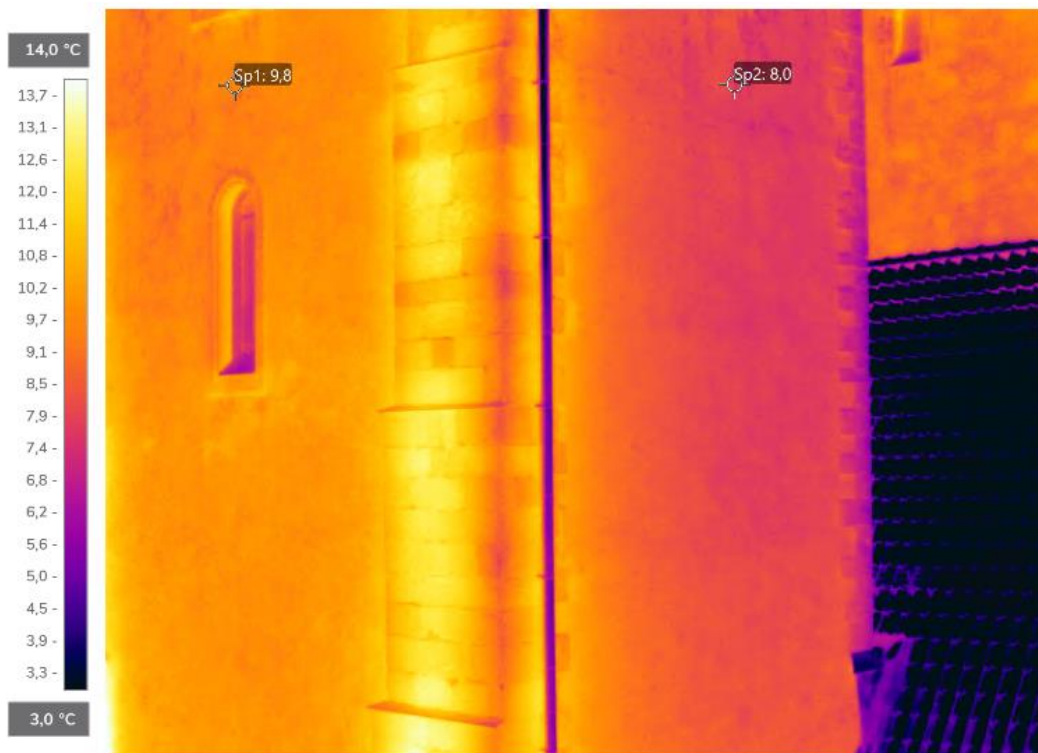
Figur 19 Temperaturene på sør- og østveggen i det sørlige tårnet i Mariakirken. Figur: J. Causevic. Sett mot NV.
