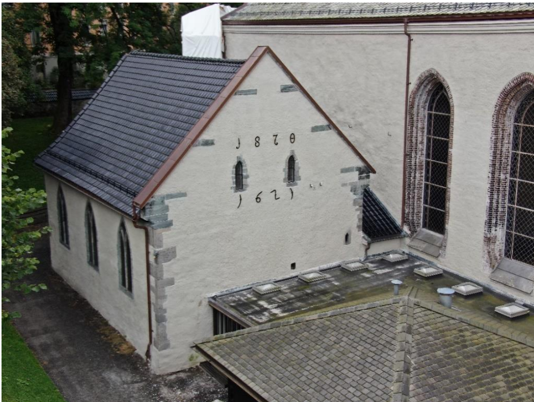
Figur 18 Et vanlig bilde av den samme bygningen som i Figur 17. Foto: J. Causevic. Sett mot SØ
