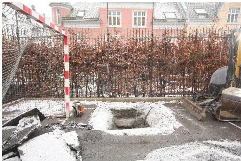
Figur 4: Plassering av Prøvehull B. Sett mot SV. Foto: NIKU
