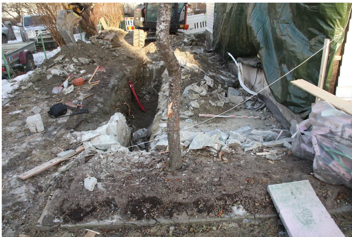
Figur 7: Oversiktsbilde, område 2 før utgravning. Målestokk 1 m. Sett mot nordøst.
