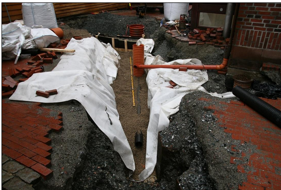
Figur 14: Etablering av I/T-system, Bryggen i Bergen. Foto: NIKU prosjekt 156132936, Arkeologisk overvåking, infiltrasjonstiltak, Bryggen.
