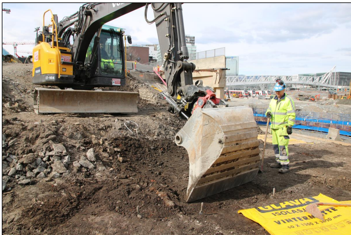
Figur 22: Ved avdekking av kulturlag står gravemaskin på kanten av feltet, og arkeolog følger arbeidet. Foto: NIKU prosjekt 1020900, Follobanen Bispegata.
