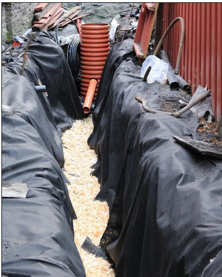
Figur 21: Utlekking av offersjikt av spon i infiltrasjons-/transportgrøft, Bryggen i Bergen. Foto: NIKU prosjekt 156132936, Arkeologisk overvåking, infiltrasjonstiltak, Bryggen.
