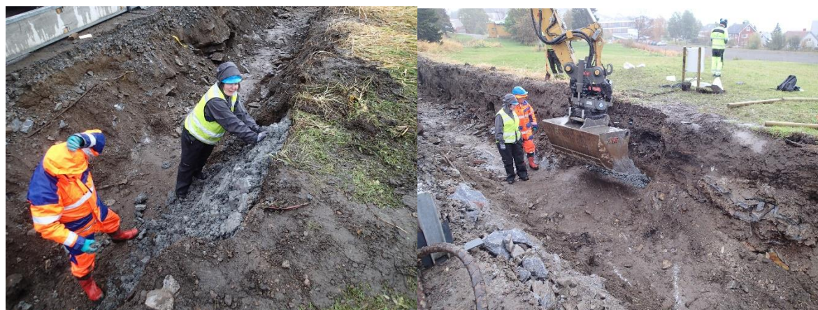
Figur 7: Foto av profil som sikres dels for hånd (til venstre) for å sikre installert MOV utstyr, dels med gravemaskin (til høyre). Saurbekken, Harstad. Foto: Michel Vorenhout, 2014.
