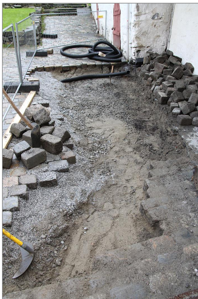
Figur 20: Etablering av permeabel overflate med perforerte rør under brostein. Foto: NIKU prosjekt 156132936, Arkeologisk overvåking, infiltrasjonstiltak, Bryggen.
