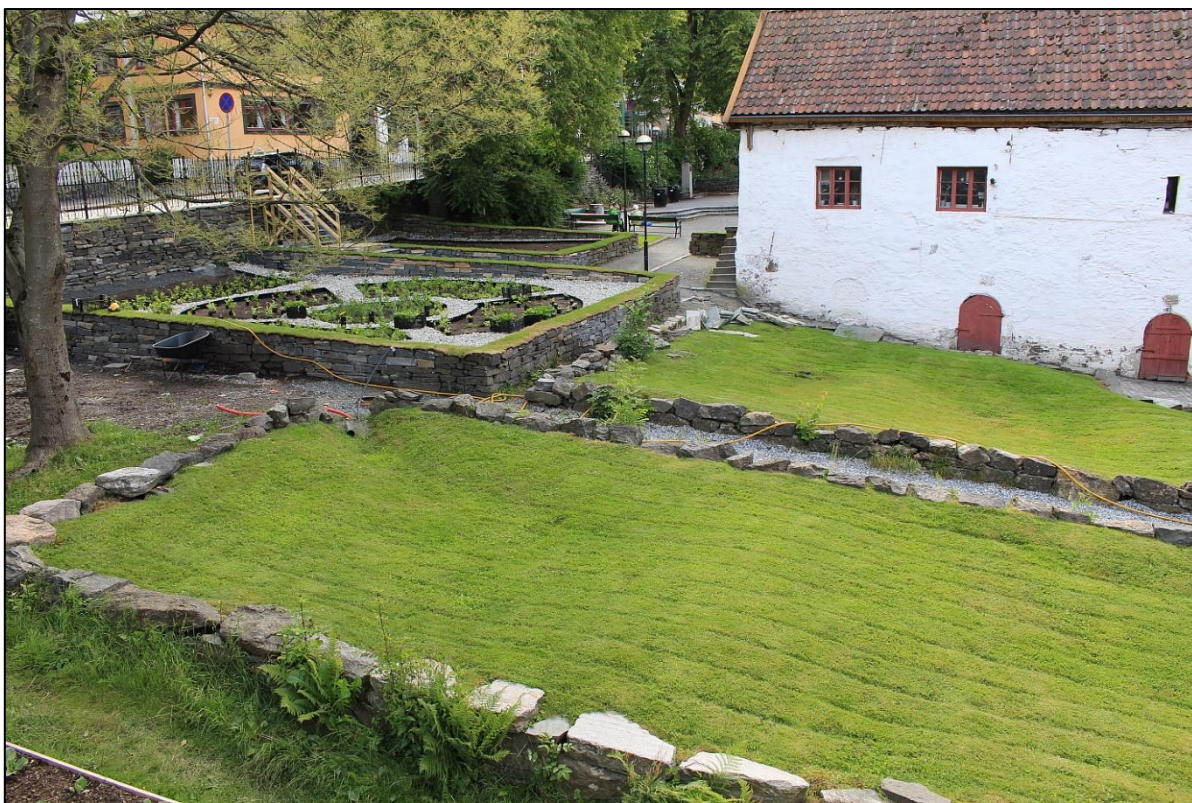
Figur 17: Installasjoner for vannoppsamling og infiltrasjon. Swales i forgrunnen, regnbed i bakgrunnen, Bryggen i Bergen. Foto: NIKU prosjekt 156132936, Arkeologisk overvåking, infiltrasjonstiltak, Bryggen.
