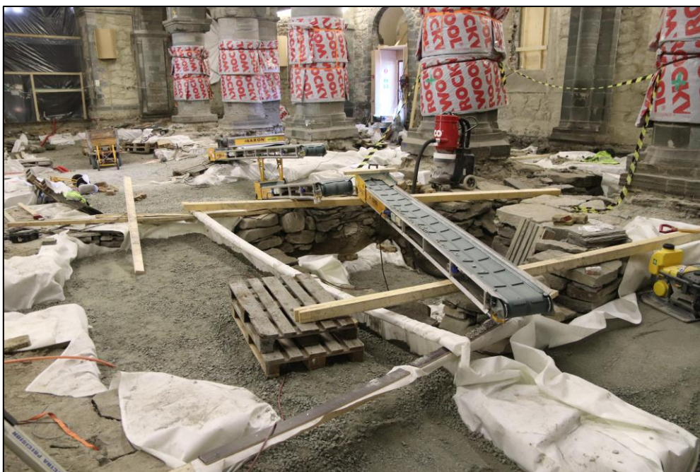
Figur 10: Eksempel på utskifting av masser i Stavanger domkirke, hvor stedlige, tyngre masser ble anvendt til igjenfylling av deler av kirkens krypkjeller. Foto: NIKU prosjekt 1021779, Stavanger domkirke.
