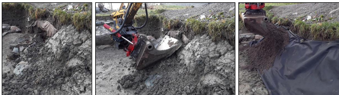
Figur 6: Maskinell tildekking av profil med leire. V: Profil tildekkes med leire. M: Leire pakkes med maskin. H: Leire dekkes med duk og grøften gjenfylles med ønsket masse.
