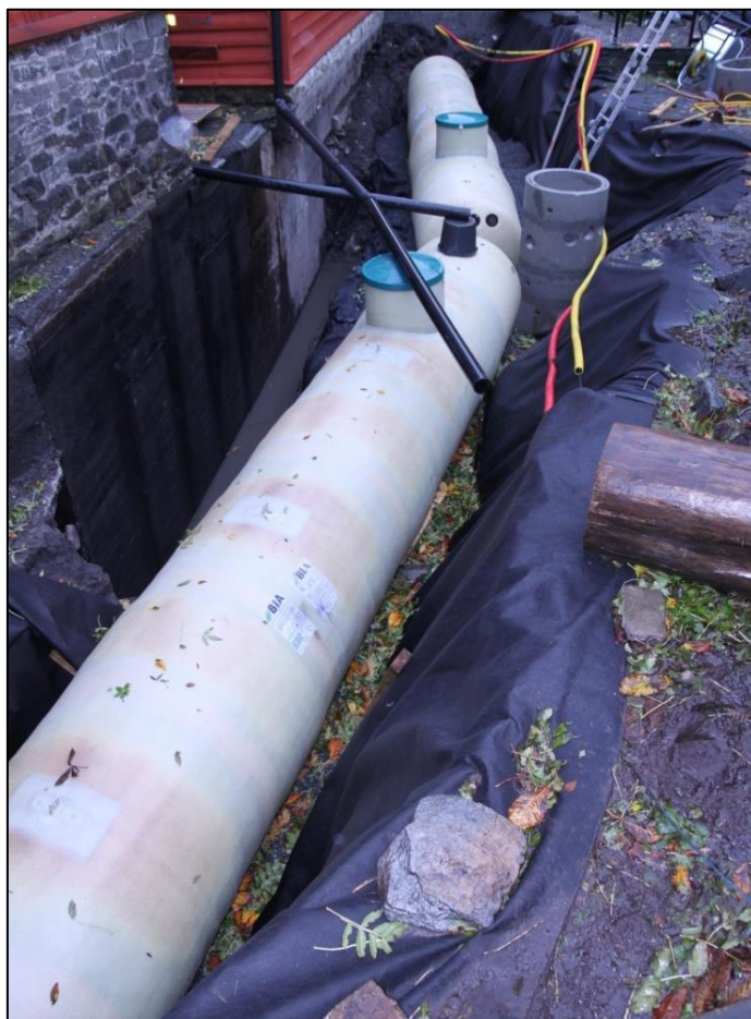
Figur 16: Nedgravde vannmagasineringsstanker ved Schøtstuene, Bryggen i Bergen. Foto: NIKU prosjekt 156132936, Arkeologisk overvåking, infiltrasjonstiltak, Bryggen.
