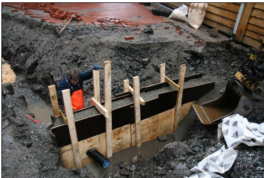
Figur 15: Bygging av bentonittdemning, Bryggen i Bergen. Foto: NIKU prosjekt 156132936, Arkeologisk overvåking, infiltrasjonstiltak, Bryggen.
