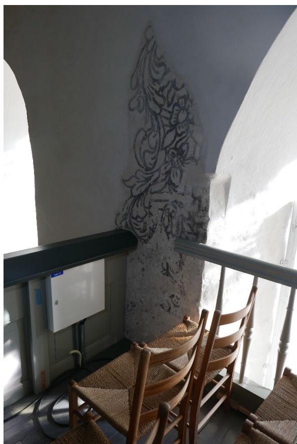
Figur 6: Rankedekorfragment ved vestre vindu på sørsiden i skipet, og som er tilgjengelig fra galleriet. Dekoren er svært utsatt for støt og berøring, og det har satt sine spor. Foto: NIKU
