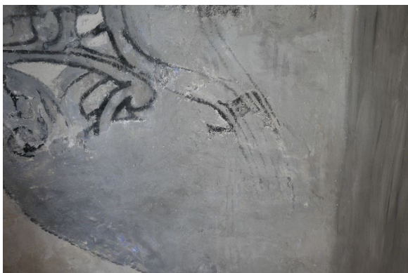
Figur 2: Alvorlige sprekker og løs puss langs dørkarmen. Foto: NIKU
