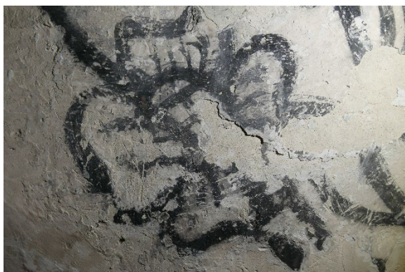
Figur 8: Detalj. Avskallinger i kalken og løse kalklag.
