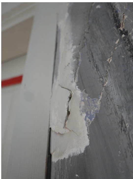
Figur 2: Alvorlige sprekker og løs puss langs dørkarmen. Foto: NIKU
