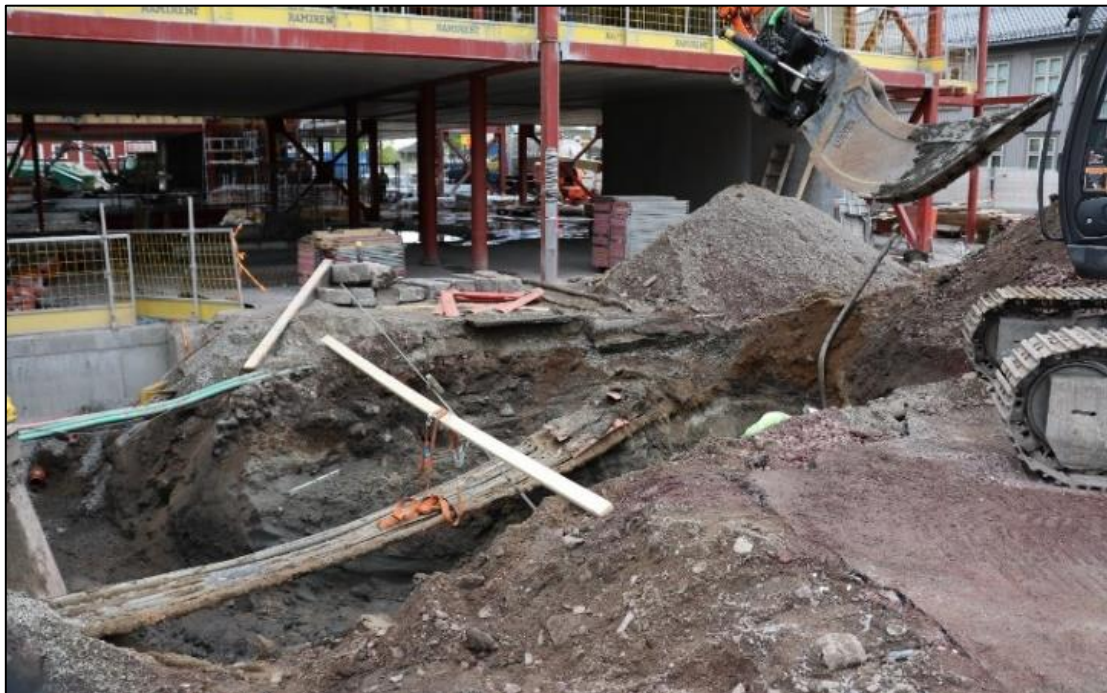
Figur 7 Grøft i Conrads gate, mot sørøst. Cf54074_NIKU_003.JPG.
