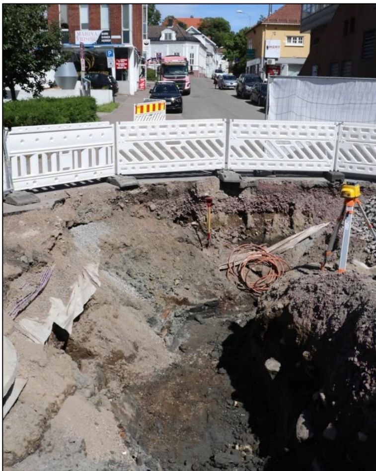
Figur 58 Oversikt utgravd grøft mot nordøst, samt stolper ST3592 og ST3586. Cf54074_NIKU_045.JPG
