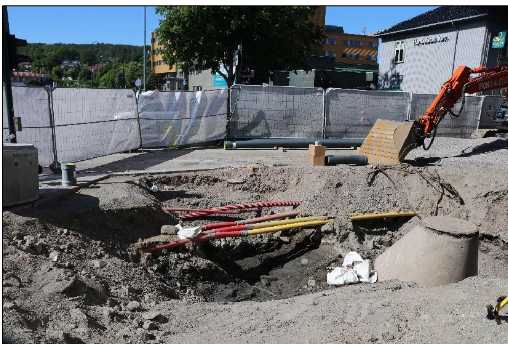
Figur 23 Oversikt graving i Klostergaten, mot sørvest. Cf54074_NIKU_025.JPG.
