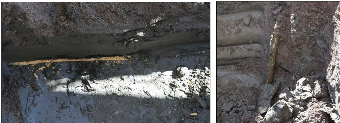
Figur 32 Liggende og stående påler i grøft for kum, Klostergaten / Nedre Langgate. V: mot sør Cf54074_NIKU_024.JPG, H: mot vest, Cf54074_NIKU_026.JPG.
