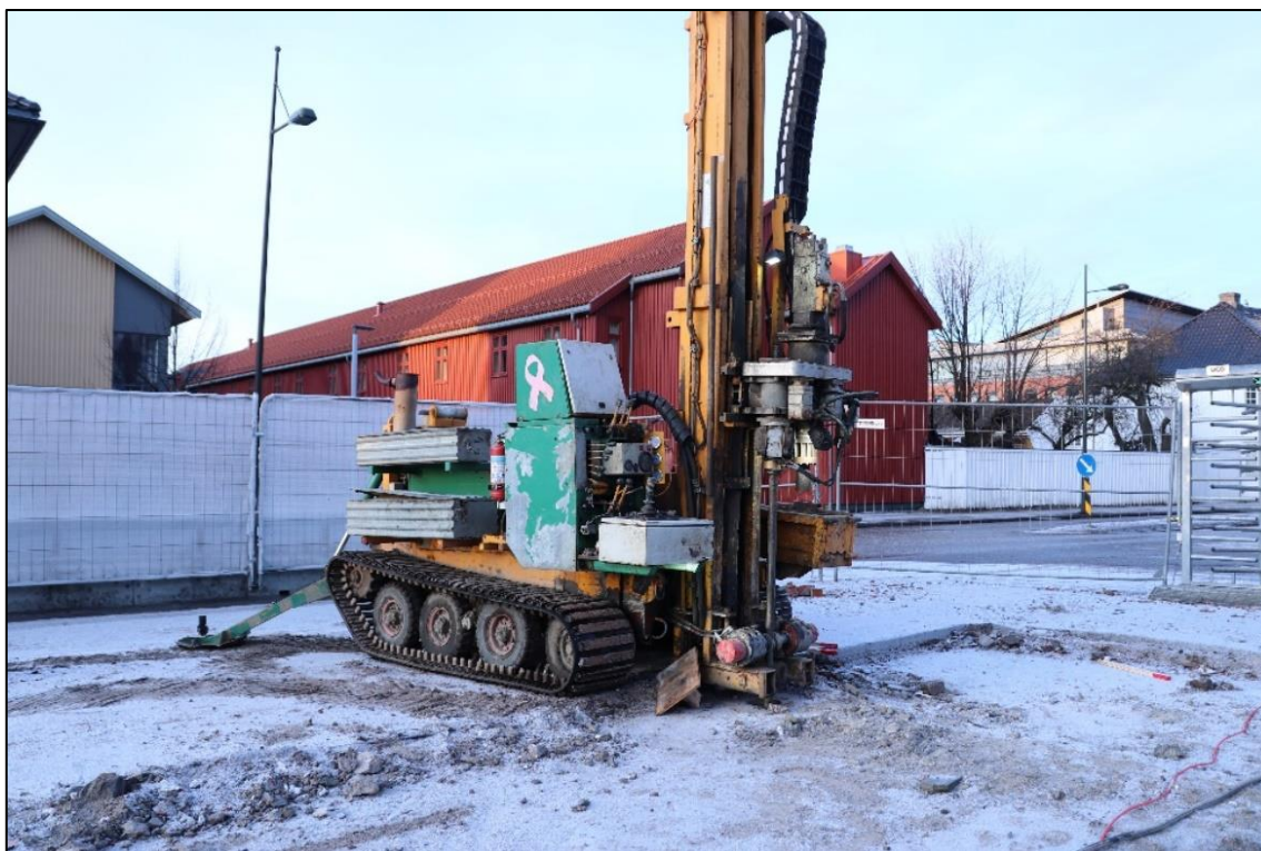
Figur 4 Oversikt, boring, mot nordvest. Cf54074_NIKU_001.JPG
