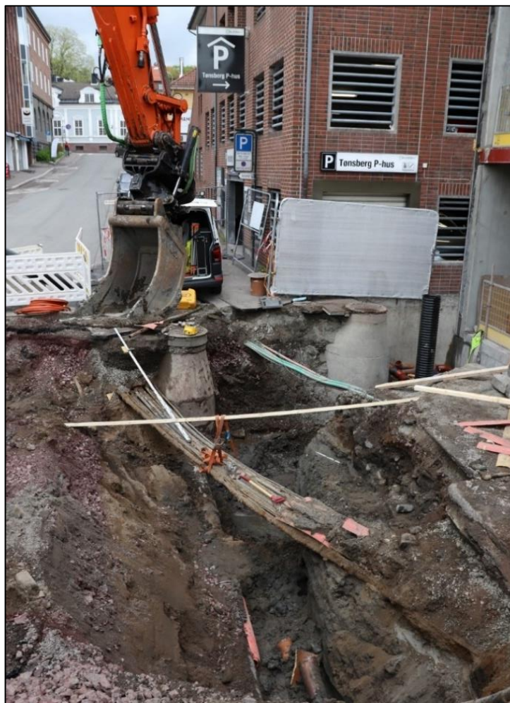
Figur 8 Oversikt, grøft i Conradis gate, mot nord-nordøst. Cf54074_NIKU_004.JPG.
