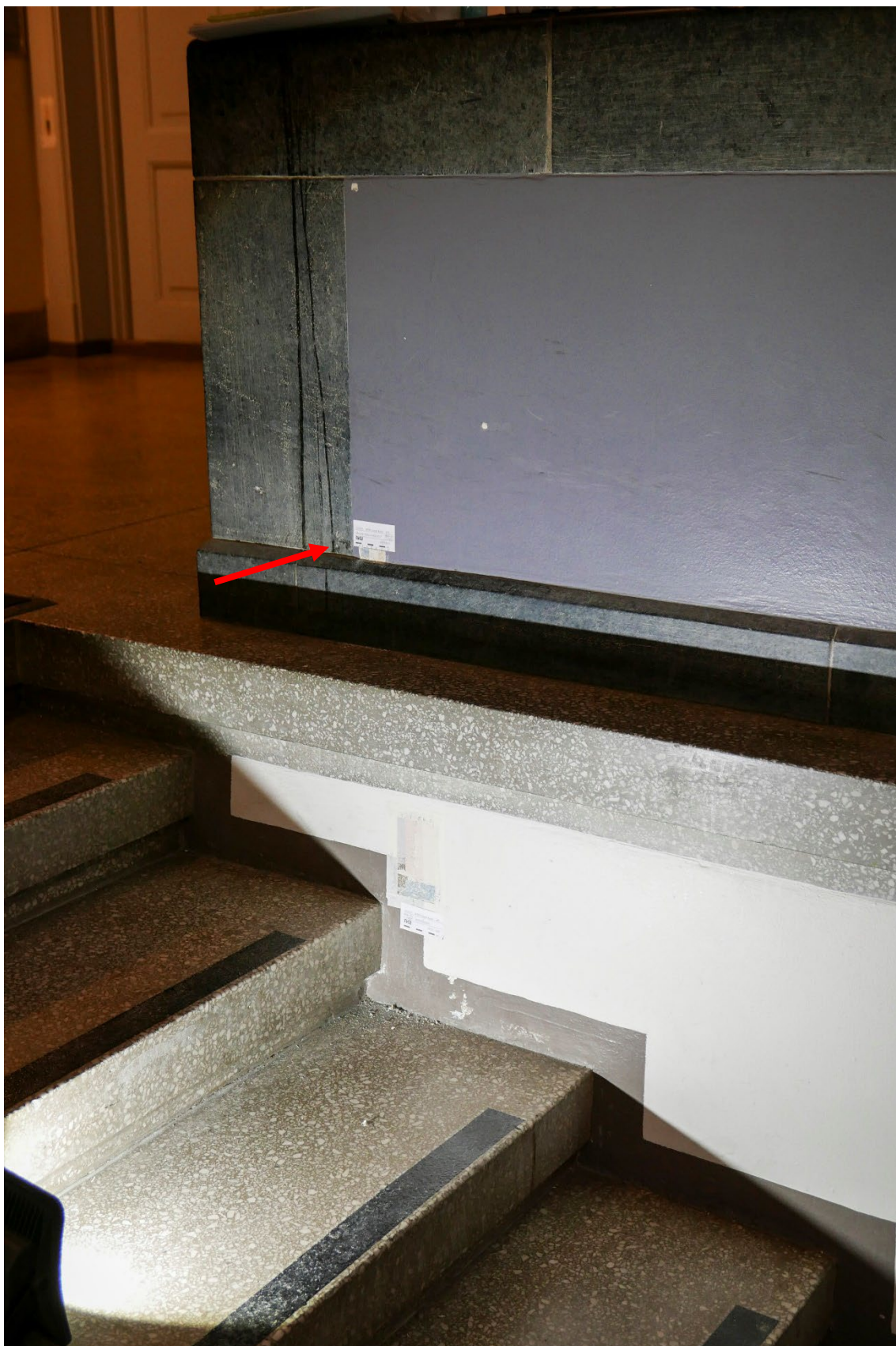
Figur 47 Rom 123. Plassering av avdekking på pusset rekkverk mot nord, mot rom 120 (rød pil). Foto: NIKU, 2023.
