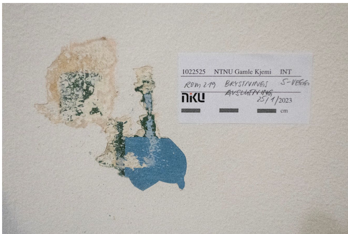
Figur 56 Rom 219. Avdekning av tidligere malte brystninger. De samme vegg- og brystningsfargene har vært malt inn i dør- og vindussmyg. Foto: NIKU, 2023.
