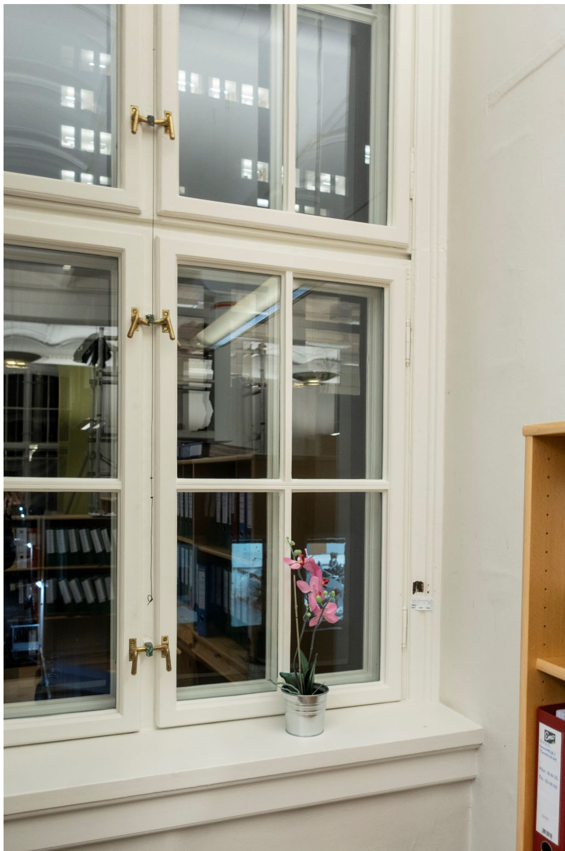
Figur 18 Rom 202. Vindu mot sør. Andre vindu fra østvegg. Foto: NIKU, 2023.
