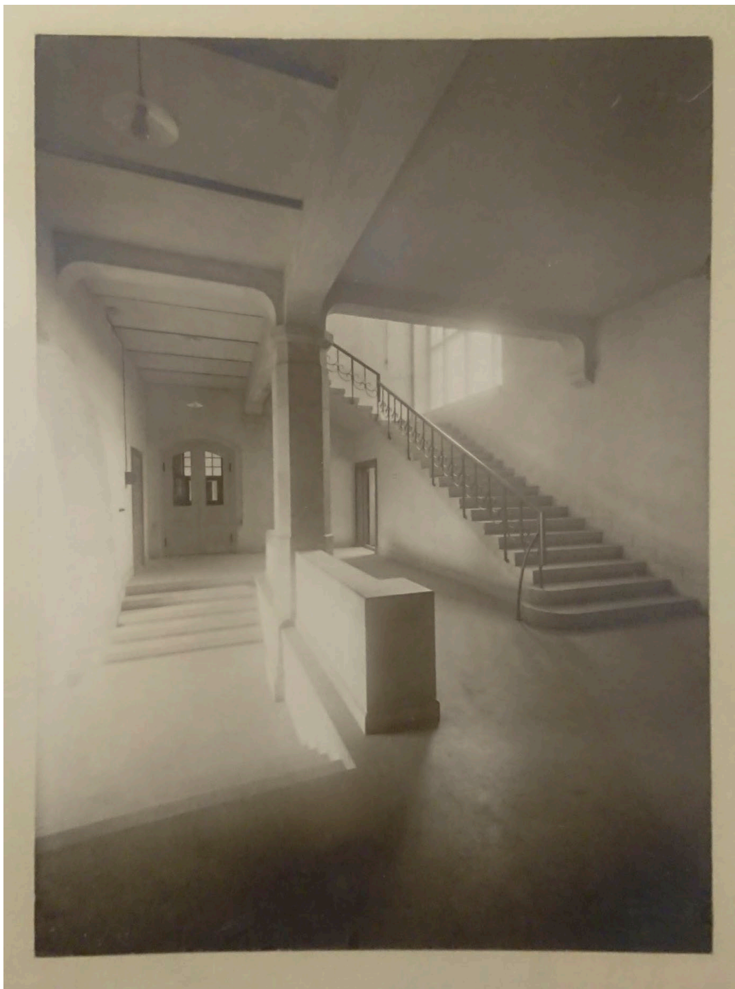
Figur 19 Rom 123. Datering: ukjent. Trolig rett etter oppføring. Kilde: tilsendt fra oppdragsgiver. Vindusåpningen i trappen opp til rom 219 er høyere. Skomakerlampene i taket er opprinnelige. Disse ble byttet til dagens taklamper på 1920-tallet (se figur 4). 8
