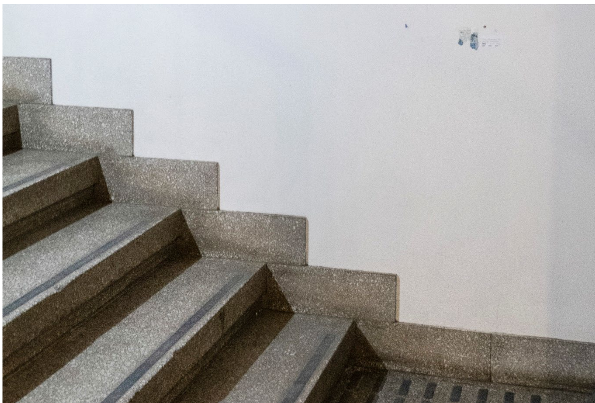
Figur 60 Rom 123. Avdekning for å kartlegge utstrekning av malte brystninger i trappen mellom rom 219 og rom 123. «Knekken» ligger ca. 113 cm opp på veggen. Foto: NIKU, 2023.
