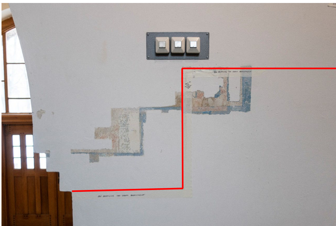
Figur 41 Rom 123. Avdekking på nordvendt vegg, øst for buen til rom 120. L3 er som L2 i resten av rommet, men med malt avtrapping mot buen (rød markering). Det er ikke helt klart hvordan den mørk grønne brystningslisten har vært malt i avtrappingen. Noen steder har den vært bredere? Foto: NIKU, 2023.
