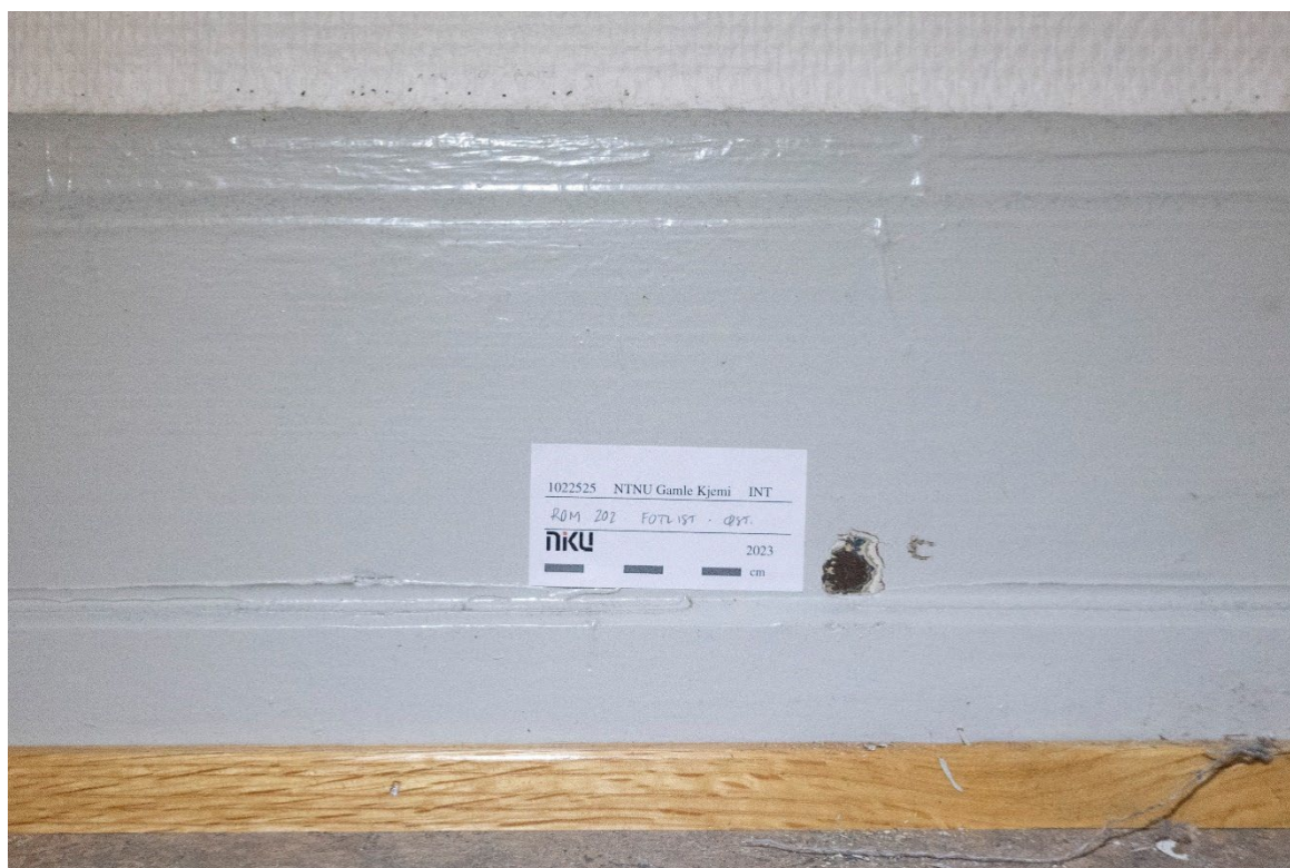
Figur 69 Rom 202. Avdekking av opprinnelig farge på fotlisten. Foto: NIKU, 2023.
