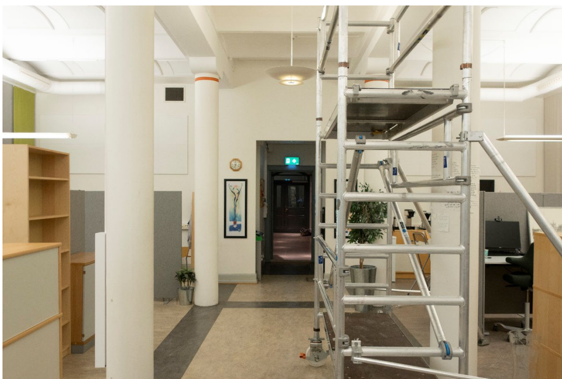
Figur 15 Rom 202. Fotografert fra øst mot vest. Foto: NIKU, 2023.
