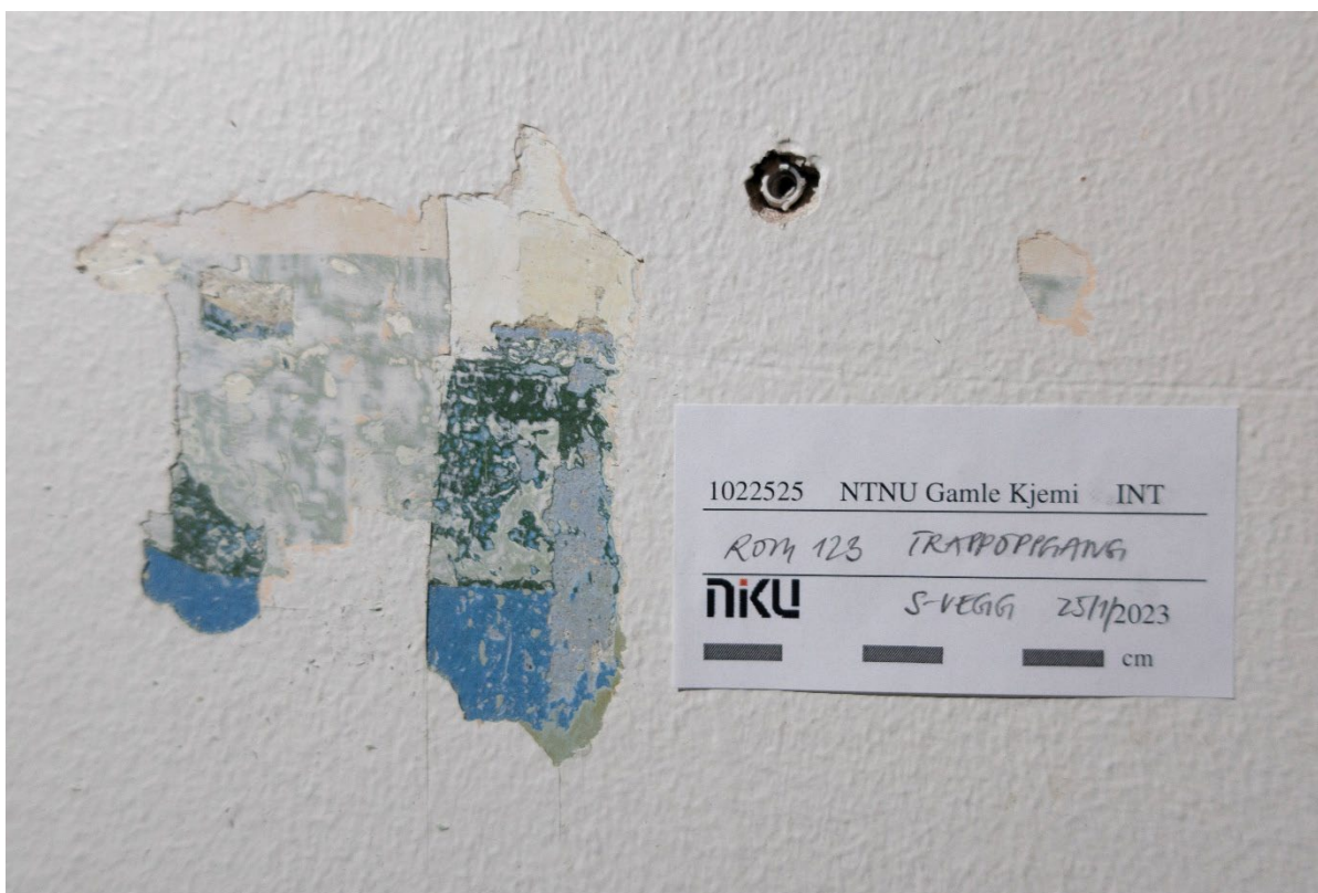
Figur 61 Rom 123. Avdekning for å kartlegge utstrekning av malte brystninger.. Foto: NIKU, 2023.
