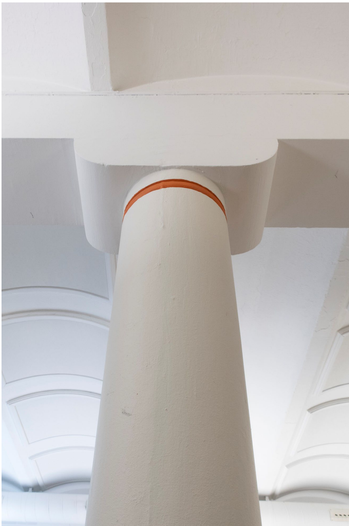
Figur 16 Rom 202. Øvre del av søyler og kappehvelv med stålbejler i himlingen. Foto: NIKU, 2023.
