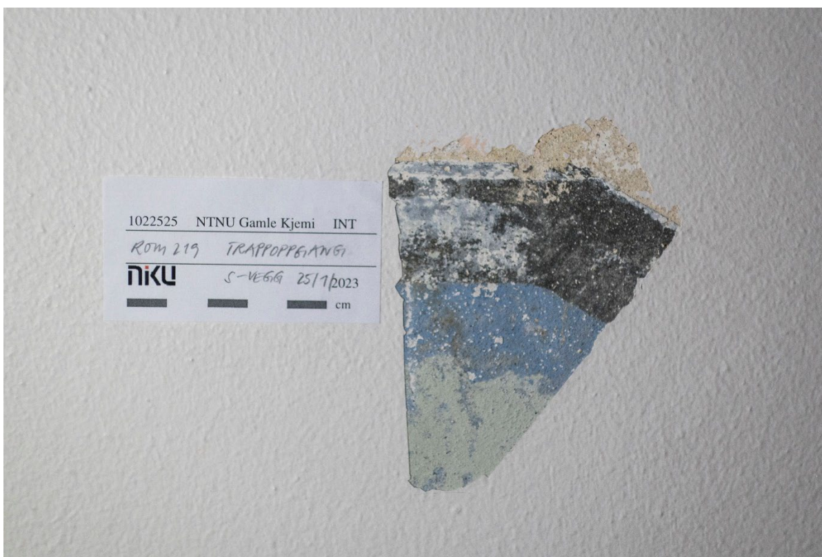
Figur 59 Rom 219. Avdekning for å kartlegge utstrekning av malte brystninger på vegg mot sør i trappen mellom rom 219 og rom 123. Foto: NIKU, 2023.
