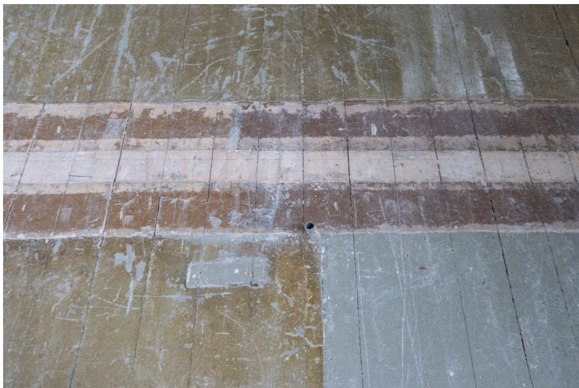
Figur 35 Gulv med en rekke negative fargespor. Foto: NIKU, 2023.
