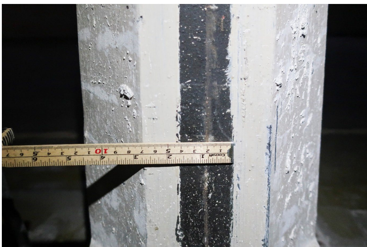
Figur 27 Negativt fargespor etter opprinnelige lettvegger på søylene. Ca. 4 cm bredt. Det mørke feltet er umalt jern. Lettveggene har gått fra alle søylene og ut på hver langvegg mot nord og sør. Foto: NIKU, 2023.
