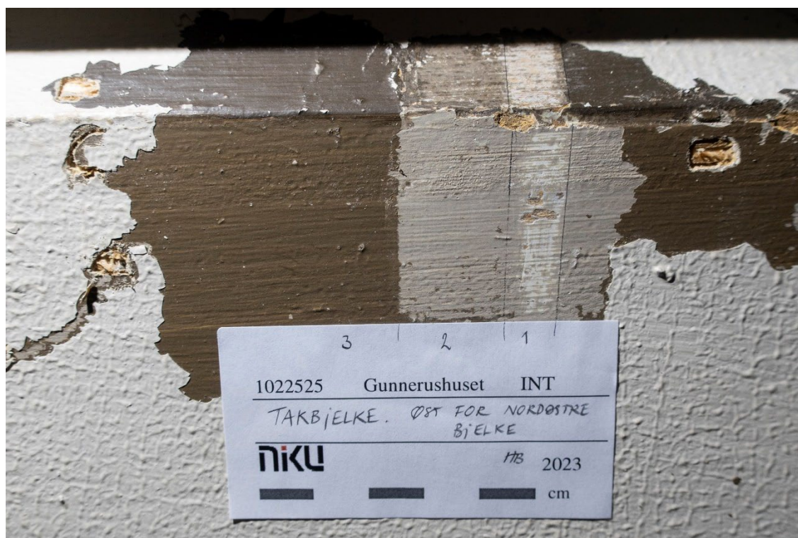
Figur 23 Lagvis avdekking av malingslag på undersiden og på avfasing på takbjelke. Avfasing er øverst i bildet. NB Feil markering på merkelappen. Avdekkingen er gjort vest for nordvestre bjelke. Foto: NIKU, 2023.
