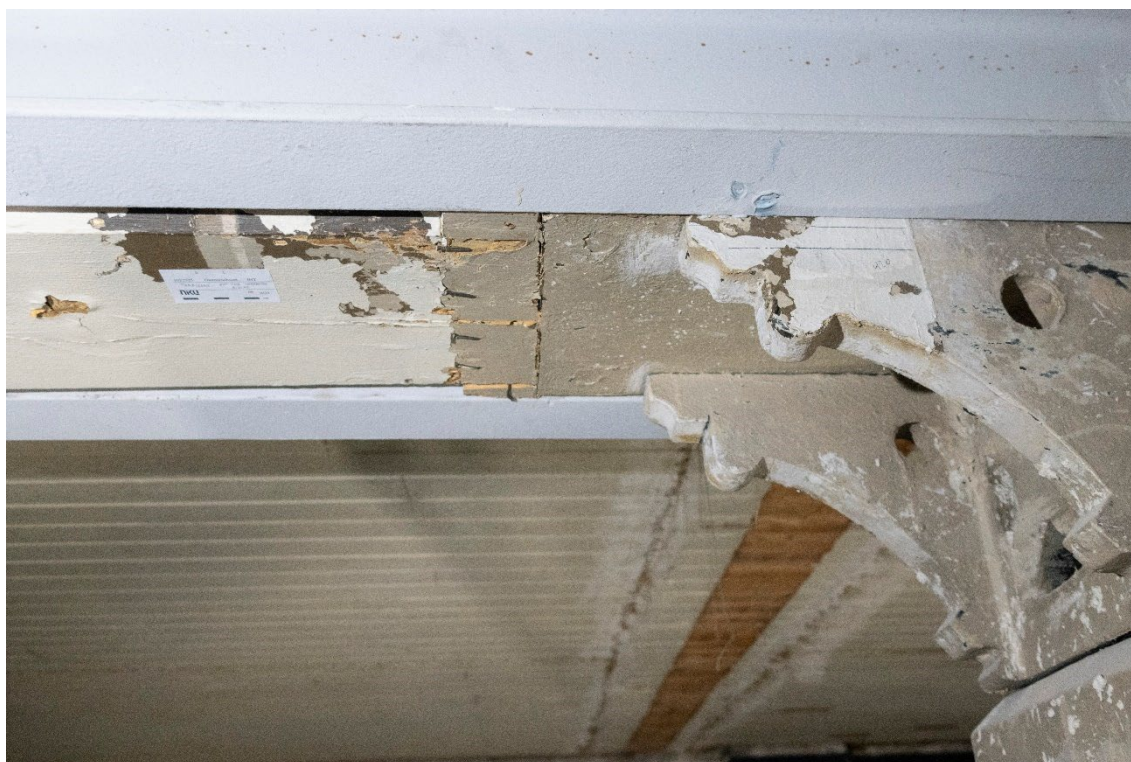
Figur 22 Plassering av avdekking på takbjelke. Mellom nordre søyle og vestvegg. Foto: NIKU, 2023.
