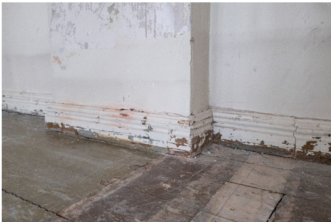
Figur 32 Fotlist på vegg mot øst. Foto: NIKU, 2023.
