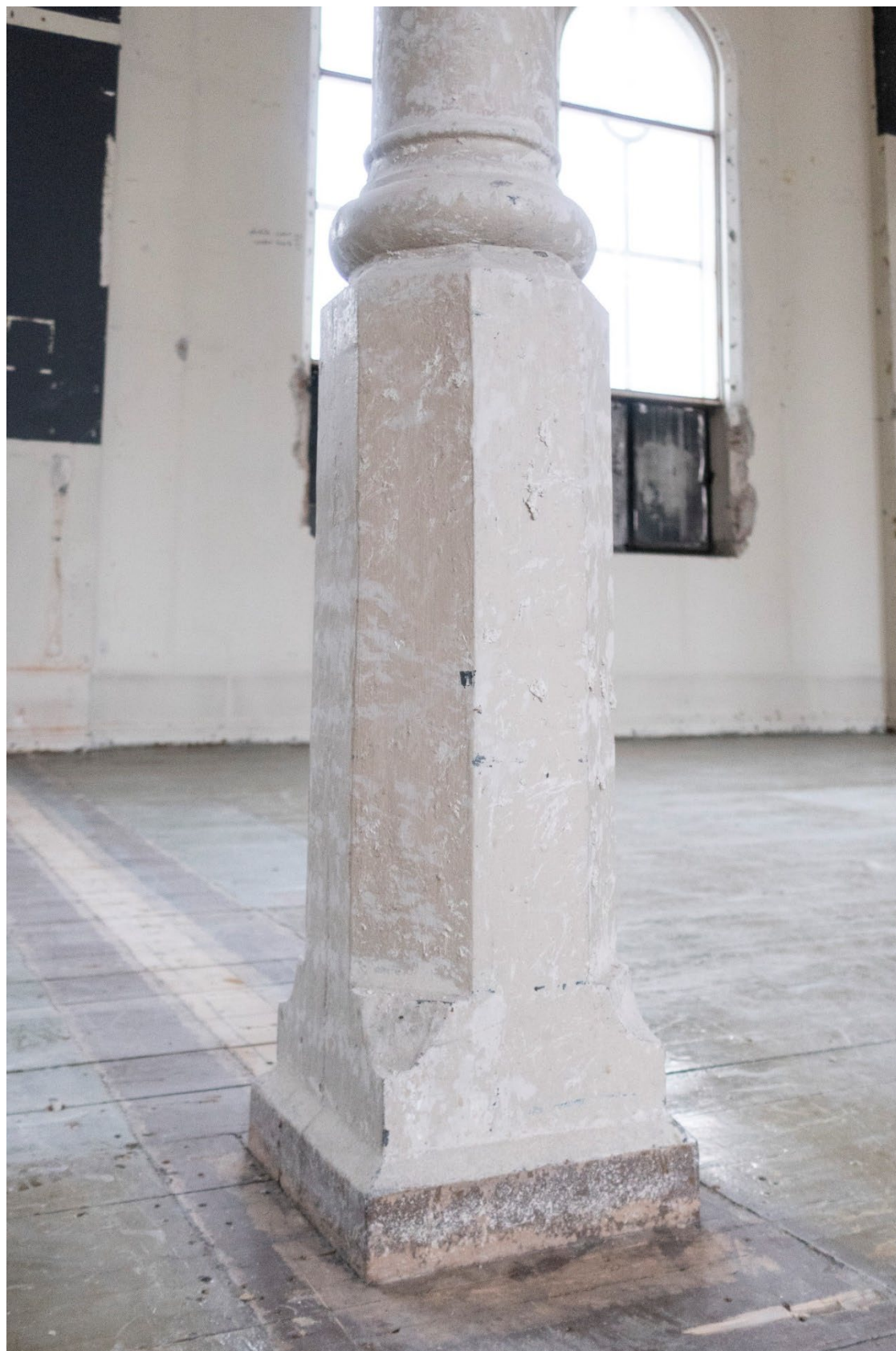
Figur 11 Gunnerushuset. Rom A220. Nedre del av søyler. Foto: NIKU, 2023.
