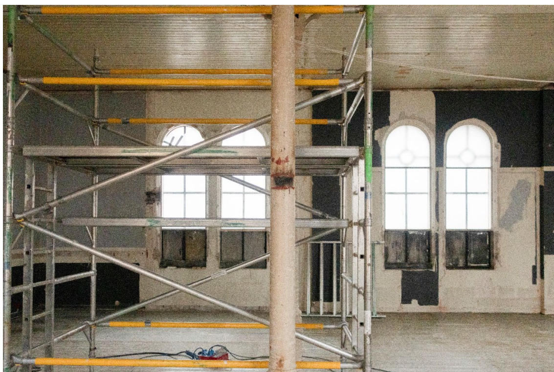
Figur 7 Gunnerushuset. Rom A220. Vegg mot nord. Vestre del. Foto: NIKU, 2023.
