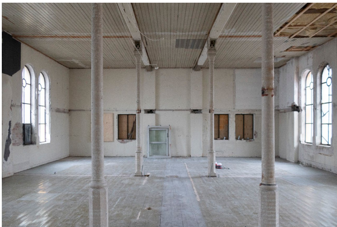
Figur 2 Gunnerushuset. Rom A220. Vegg mot øst. Foto: NIKU, 2023.
