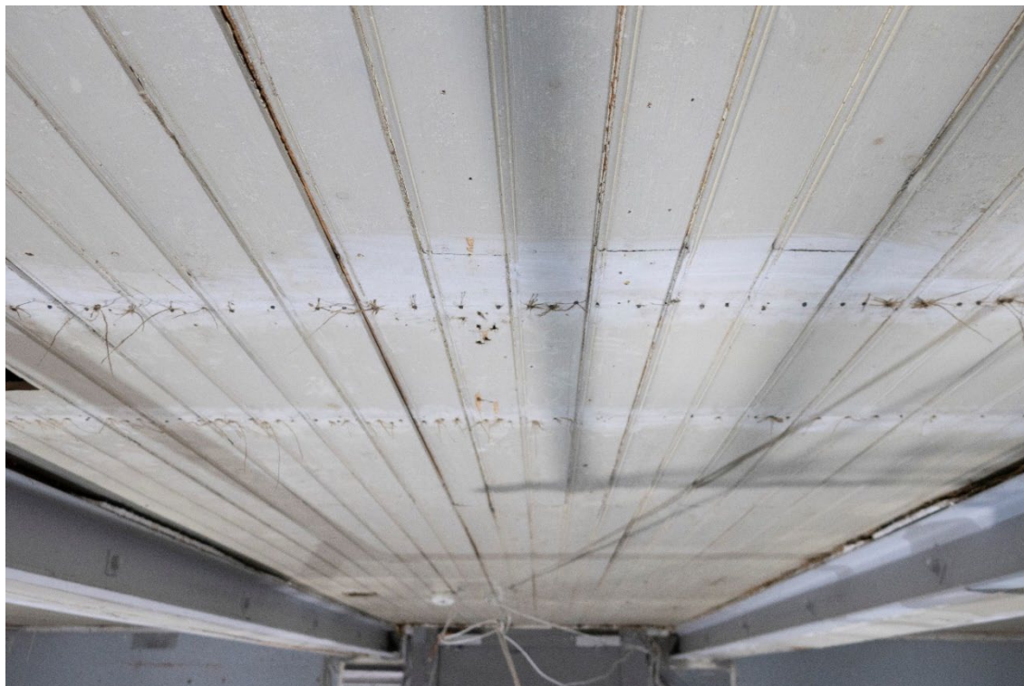
Figur 18 Himlingsbordene mellom de vestligste søylene. Fotografert mot vest. Hvitmalt og spør etter sekundært lerret. Foto: NIKU, 2023.
