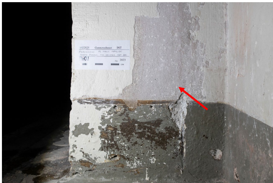
Figur 29 Avdekking av opprinnelig, grårøsa farge på siden av pilaster (rød pil). Foto: NIKU, 2023.
