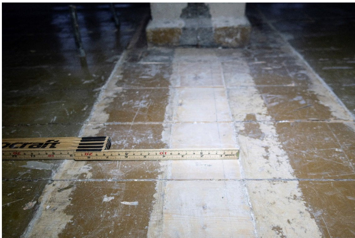
Figur 36 Negativt fargespor etter opprinnelig skillevegg. Umalt felt er ca. 10 cm. Foto: NIKU, 2023.
