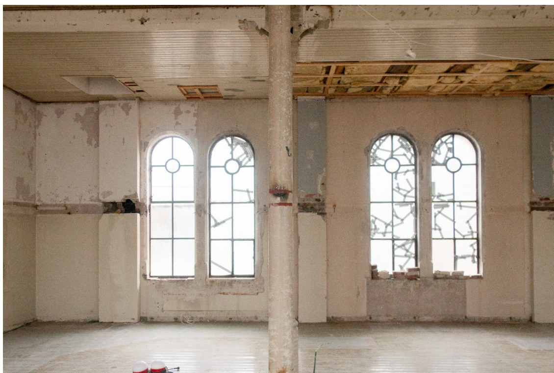
Figur 3 Gunnerushuset. Rom A220. Vegg mot sør. Østre del. Foto: NIKU, 2023.
