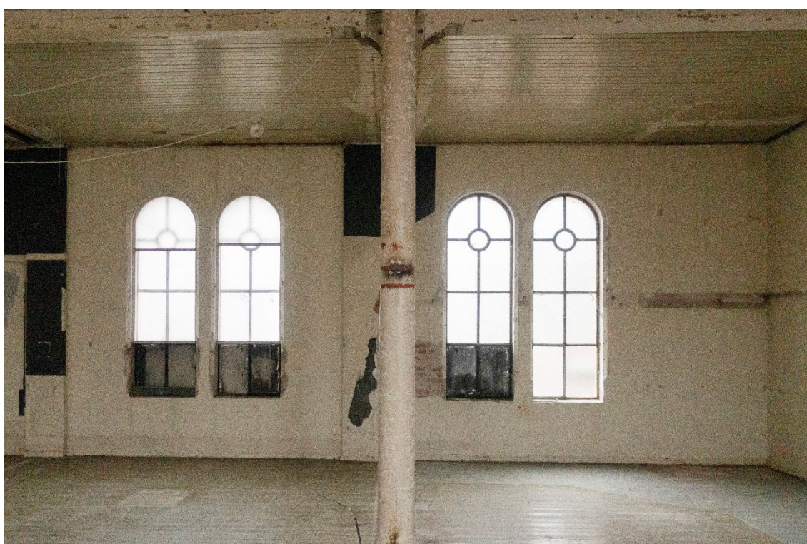
Figur 9 Gunnerushuset. Rom A220. Vegg mot nord. Østre del. Foto: NIKU, 2023.
