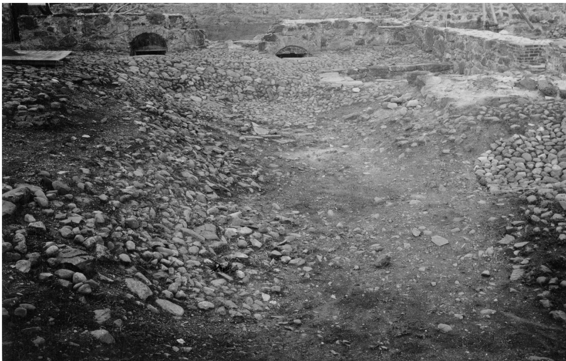
Figur 3: Bilde fra restaureringsarbeidene på slutten av 1800-tallet. Bildet er tatt mot øst i indre borggård og viser rester av den gamle steinsetningen samt en tydelig terrengforskjell som i dag er påfylt og utjevnet. Foto: Riksantikvarens arkiv.
