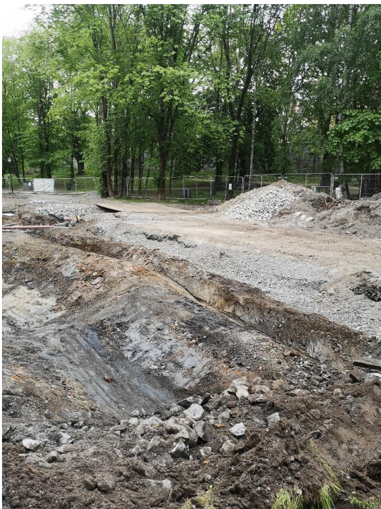
Figur 16: Grøft fra påkoblingspunktet og østover. Sett mot NV. Foto-nr: Cf54080_NIKU_0022.
