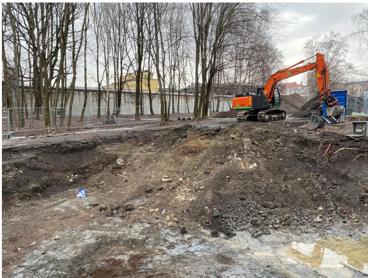
Figur 12: Oversikt grop for påkobling kulvert, med omrotet kulturlag og området med funn av menneskebein i venstre halvdel av bildet. Sett mot SV. Foto-nr: Cf54080_NIKU_0013.
