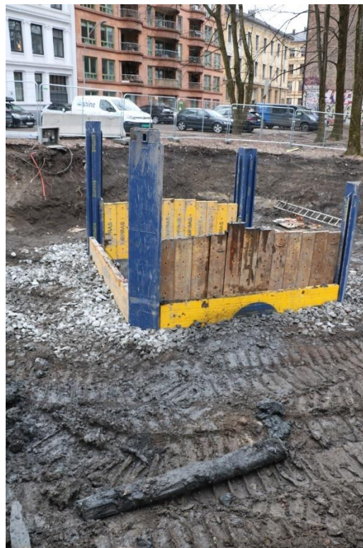
Figur 15: Påkoblingspunkt med grøftekasse. Her ble det gravd ca. 8 m dypt fra overkant terreng. Sett mot SØ. Foto-nr: Cf54080_NIKU_0019.
