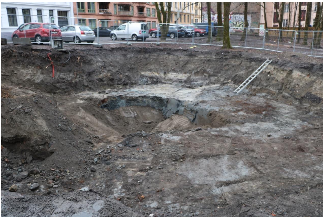
Figur 13: Grop for påkobling kulvert. Midt i bildet har graving ned til selve påkoblingspunktet startet, mens resten av gropa er ferdig gravd. I denne halvdel av gropa ble det kun observert moderne omrotede masser. Sett mot SØ. Foto-nr: Cf54080_NIKU_0015.
