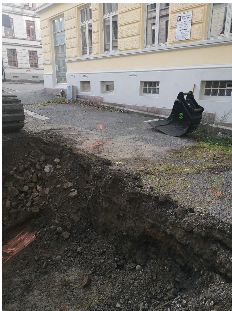
Figur 6: Avdekking av kabelgrøft Nonnegata. Sett mot SØ. Foto-nr: Cf54080_NIKU_0002.
