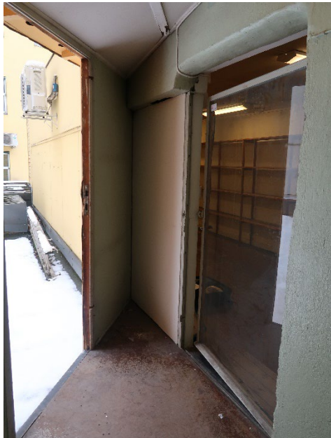
Foto 1: Stålvindu med den malte siden
