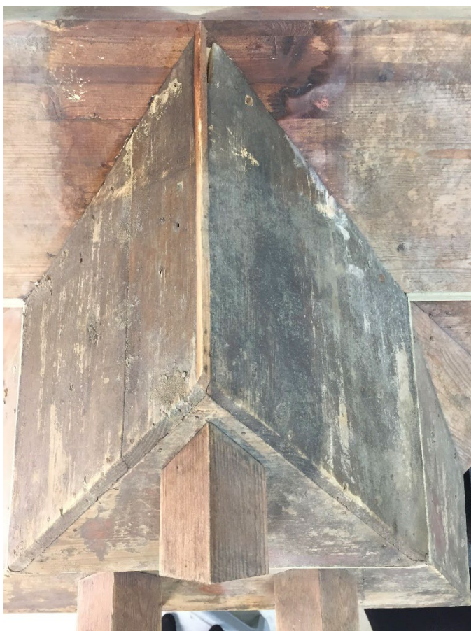
Figur 23 Taket har best bevart maling under det midtre tårnet. En transparent rødbrun overflatebehandling (beis?) er synlig på langskipet, mens en mørkere, brunsvart maling er bevart på det valmede taket på arken. Foto: NIKU 2021
