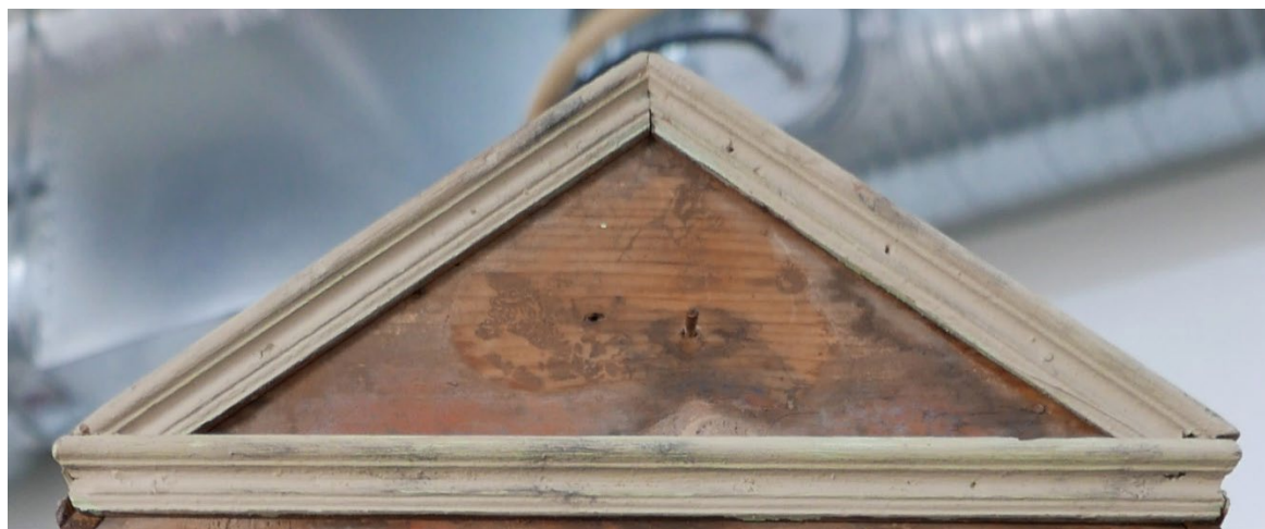
28 Negativt fargespor etter forsvunnet treelement i gavlfelt. Ën treplugg er bevart. Foto: NIKU 2021.
