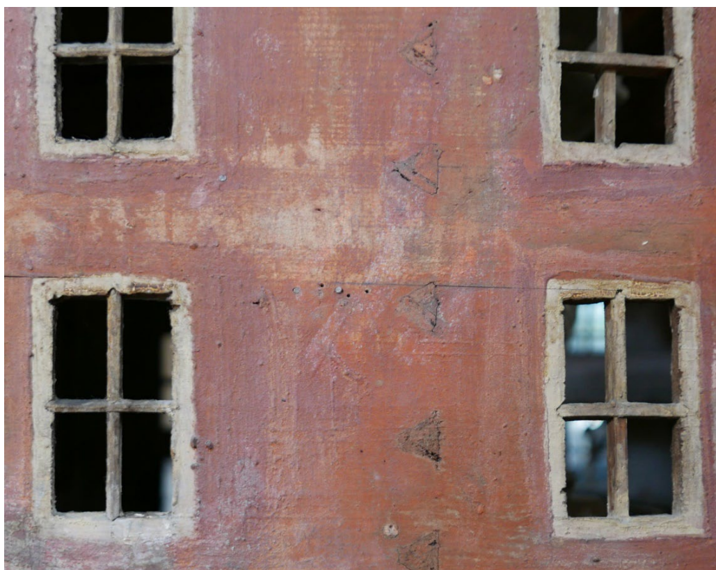
Figur 33 Malingssøl er fjernet mekanisk. Foto: NIKU 2021
