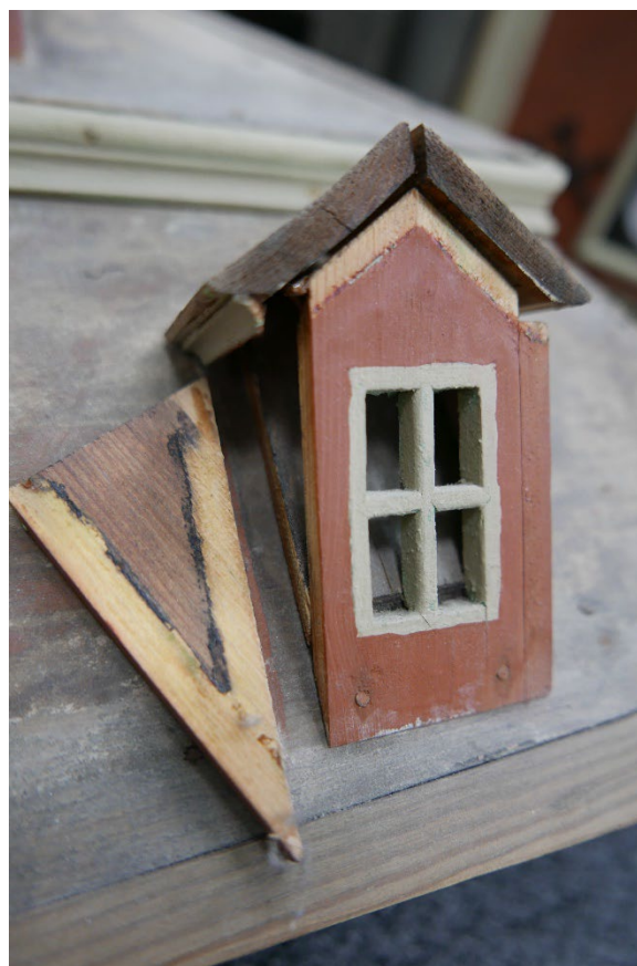
Figur 25 Sprukket bord ved vindu på skråvegg. Bordet har vridd seg løs fra veggfestet. Foto: NIKU 2021
