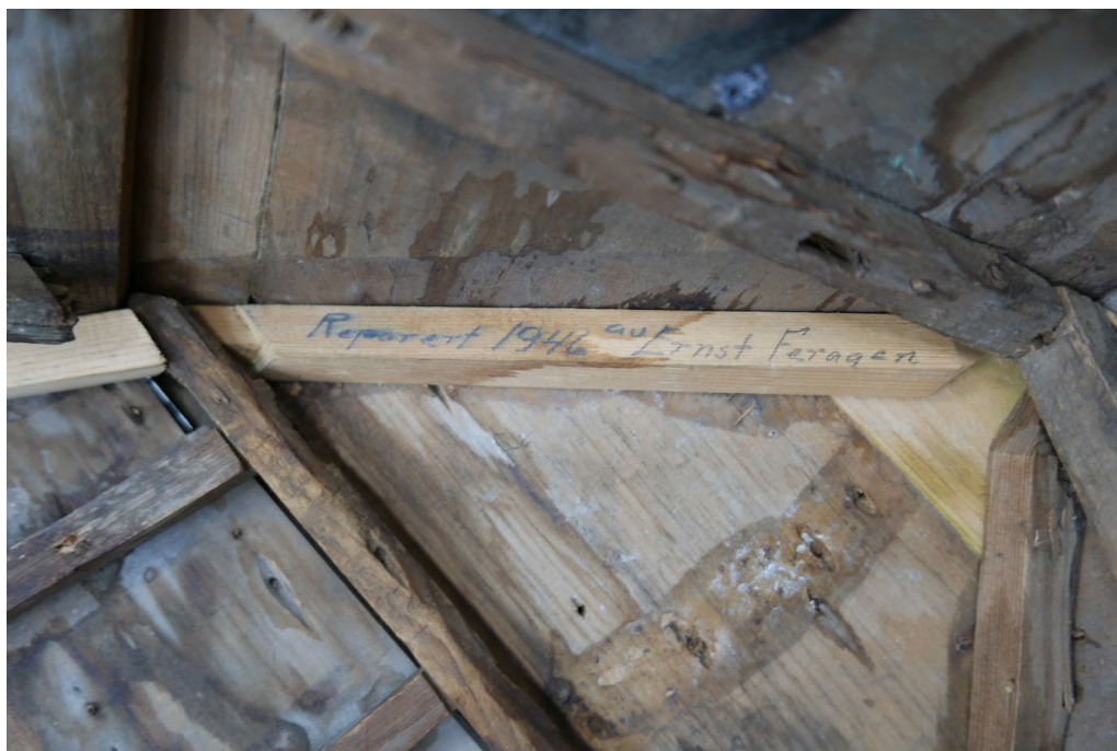
Figur 19 Restaureringshistorikk i takkonstruksjonen: «Reparert 1946 av Ernst Feragen». Foto: NIKU 2021
