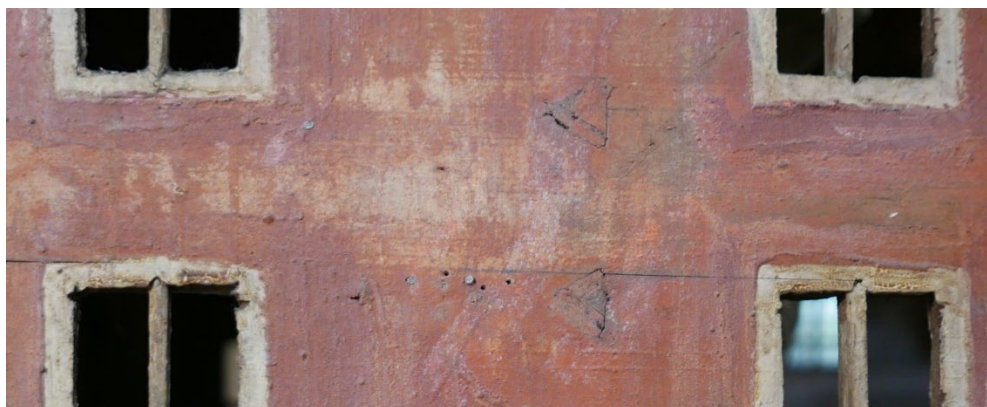
Figur 17 Trekantede innfellinger fester innvendig gjennomgående skillevegg i våpenhus og kor til ytterveggen. Foto: NIKU 2021
