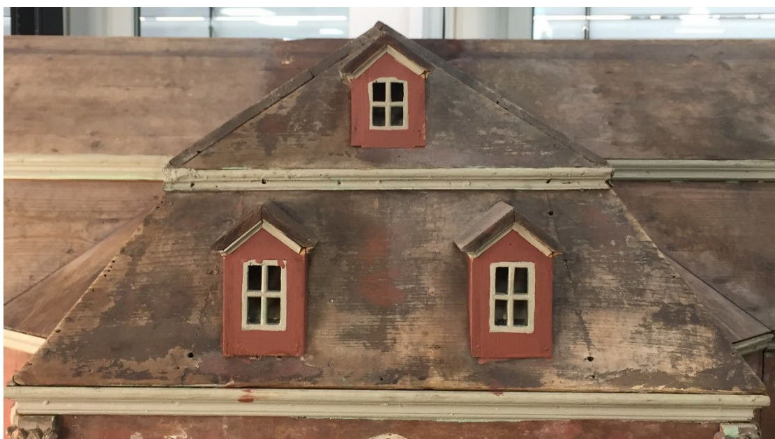
Figur 29 Under rensing. Den venstre halvparten av det valmede sidetaket er renset for støv. Foto: NIKU 2021
