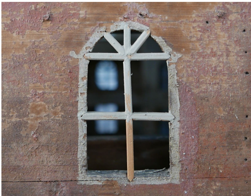
Figur 30 Område med løs maling. Det er stedvis kun øyer igjen av malingen. Vinduets sprosser er ikke opprinnelige. Foto: NIKU 2021
