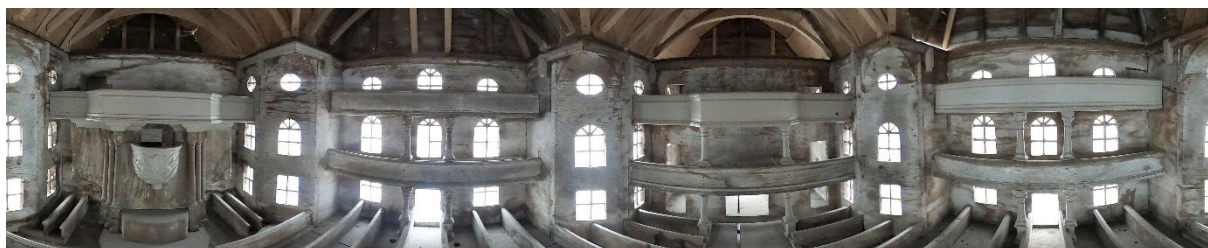
Figur 21 Jevnt gråmalte tredeler i alteret, galleriene og benkeradene er nyere, trolig fra reparasjonen i 1946. Flere søyler, en del listverk og mange vindussprosser er også nyere. 360° opptak av kirkemodellen innvendig. NIKU 2020
