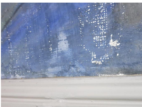
Figur 54. Detalj av oppskallinger og malingsutfall ned til hvit grundering i maleriet av Moses.
