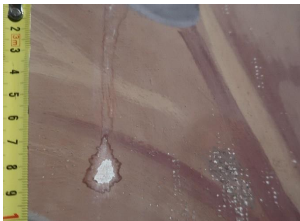
Figur 56. Detalj av fuktskade og fargetap på maleriet av Kristi himmelfart.
