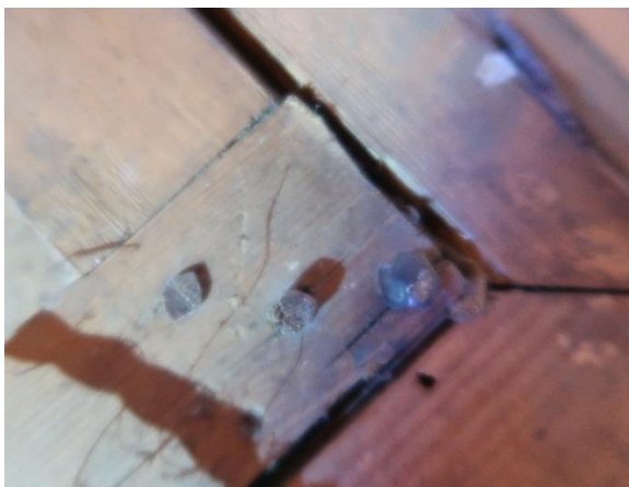
Figur 76. Detalj av fastramme med treplugger.
