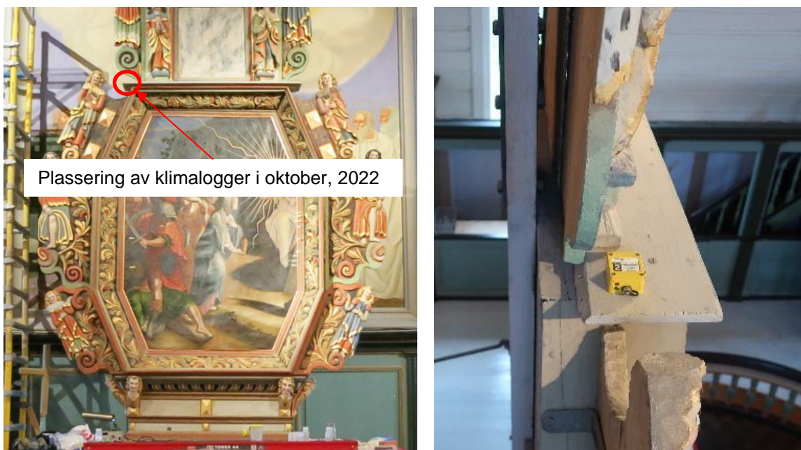
Figur 100 og 101. Plassering av klimalogger ved basen til toppstykket.
