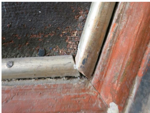
Figur 20. Detalj av halvstaver som er brukt til å feste og dekke deler av oppspenningskantene til lerretet
