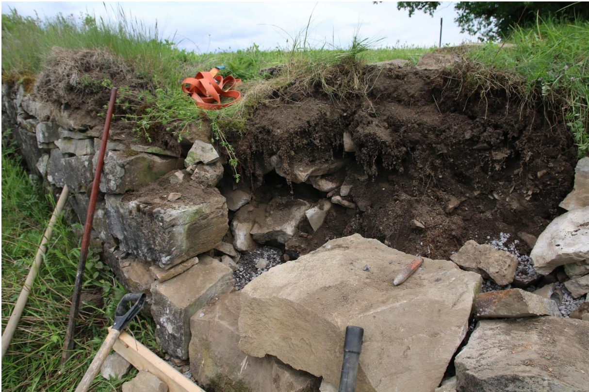
Figur 5: Den nordvestre delen av kirkegårdsmuren etter påstartet gjenoppmuring. Kirkegårdens profil, samt bakfyll, kan sees bak muren. Sett mot øst. Foto: Cf54079_NIKU_19.
