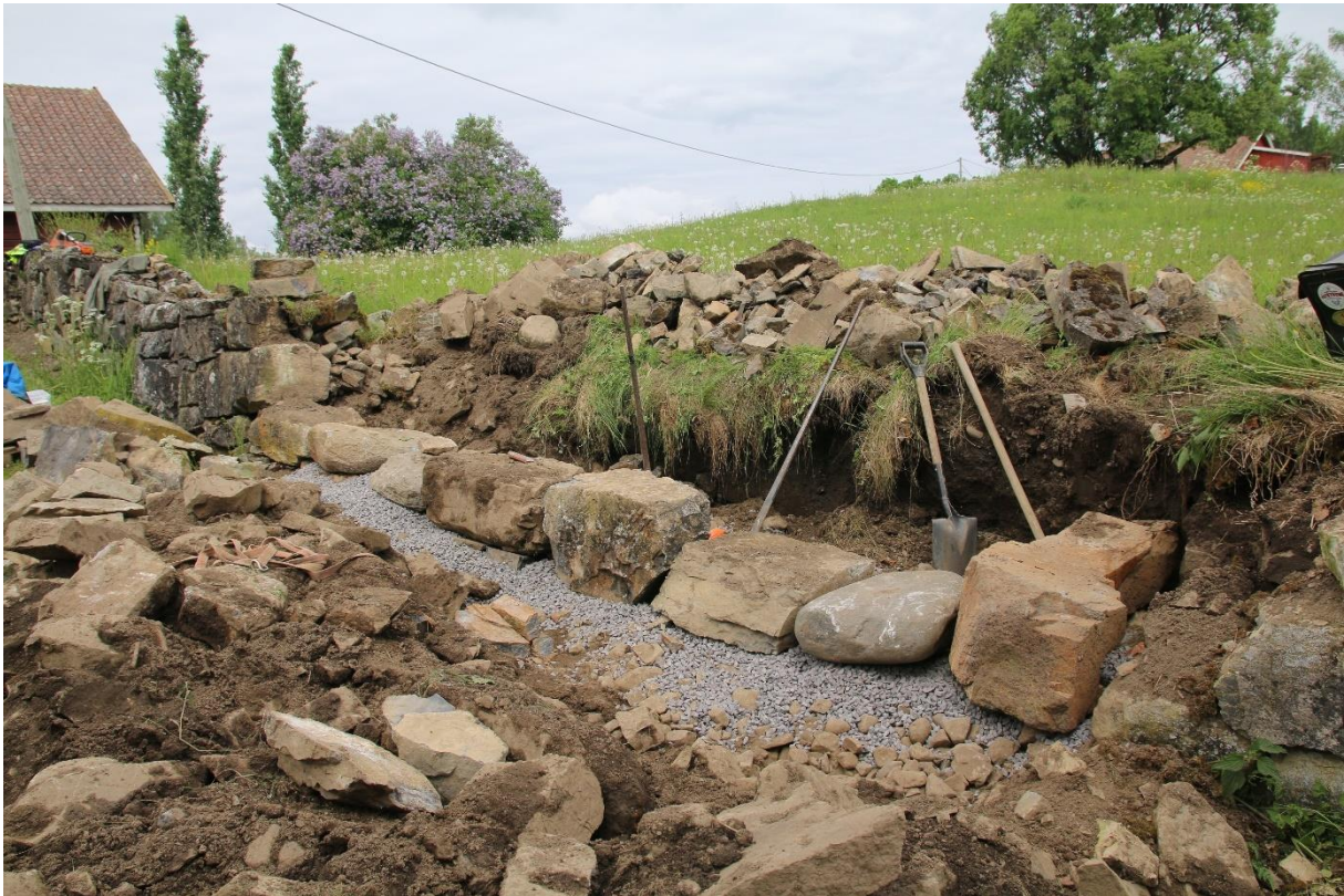
Figur 13: Påstartet gjenoppmuring ved et punkt langs den søndre delen av kirkegårdsmuren. Sett mot vest. Foto: Cf54079_NIKU_72.
