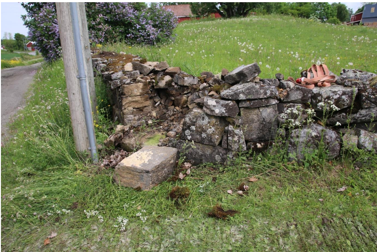
Figur 14: Hjørnet i den sørvestre delen av kirkegårdsmuren tatt ned. Sett mot nord. Foto: Cf54079_NIKU_73.
