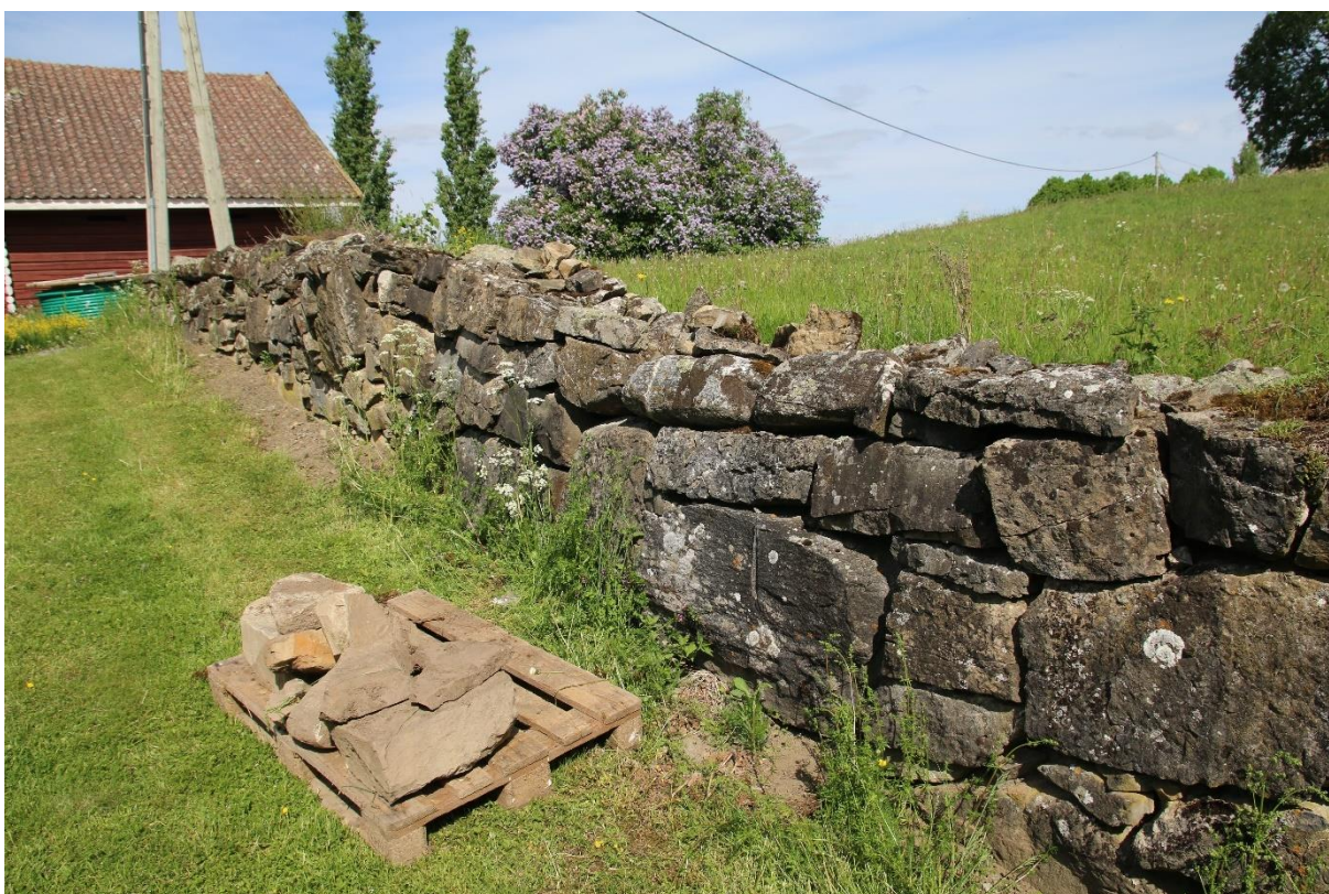
Figur 10: Søndre del av kirkegårdsmuren var i svært dårlig forfatning. Sett mot vest. Foto: Cf54079_NIKU_03.
