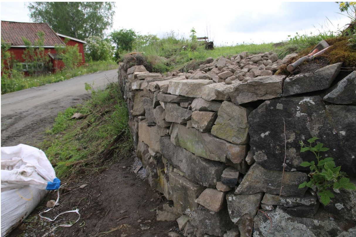
Figur 8: Den nordvestre delen av kirkegårdsmuren etter gjenoppmuring. Muren buler ikke lenger ut, jf. Figur 3. Sett mot nordøst. Foto: Cf54079_NIKU_67.
