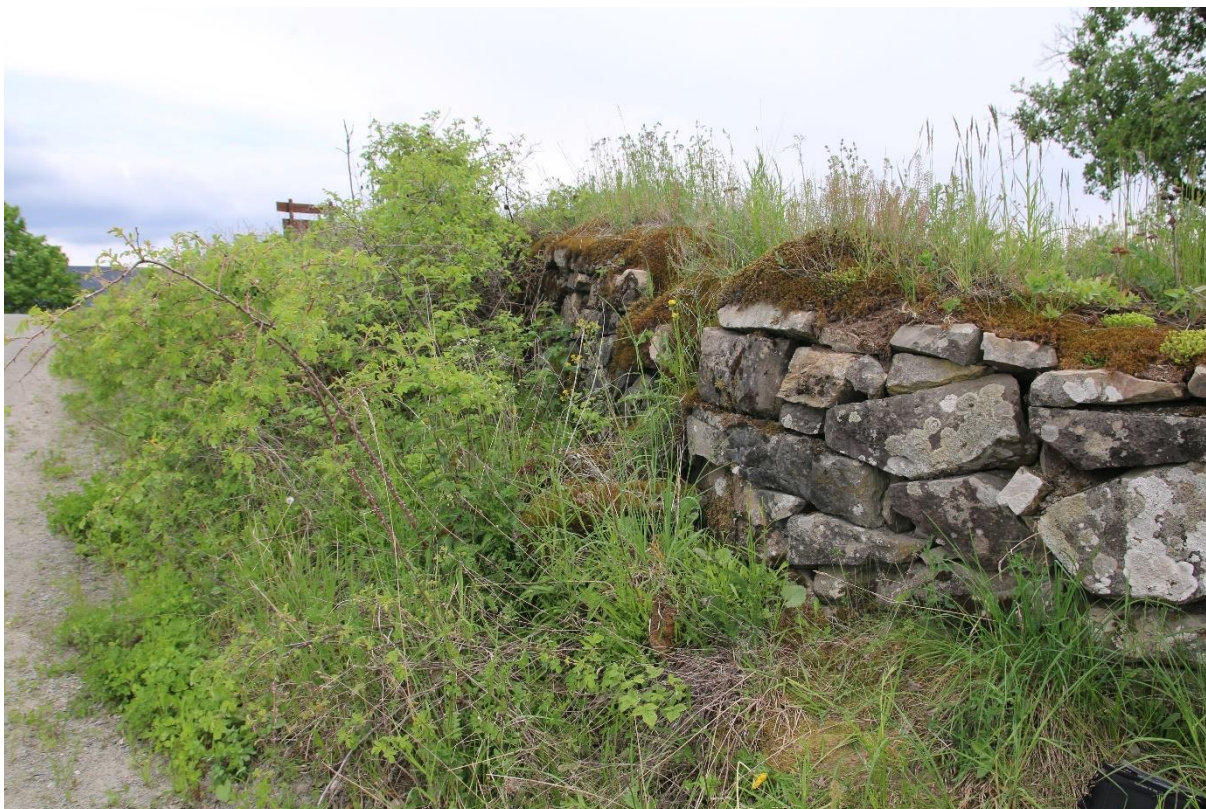
Figur 3: Nordvestre del av kirkegårdsmuren, hvor stein buler utover ved flere punkter i muren. Sett mot nordøst. Foto: Cf54079_NIKU_21.
