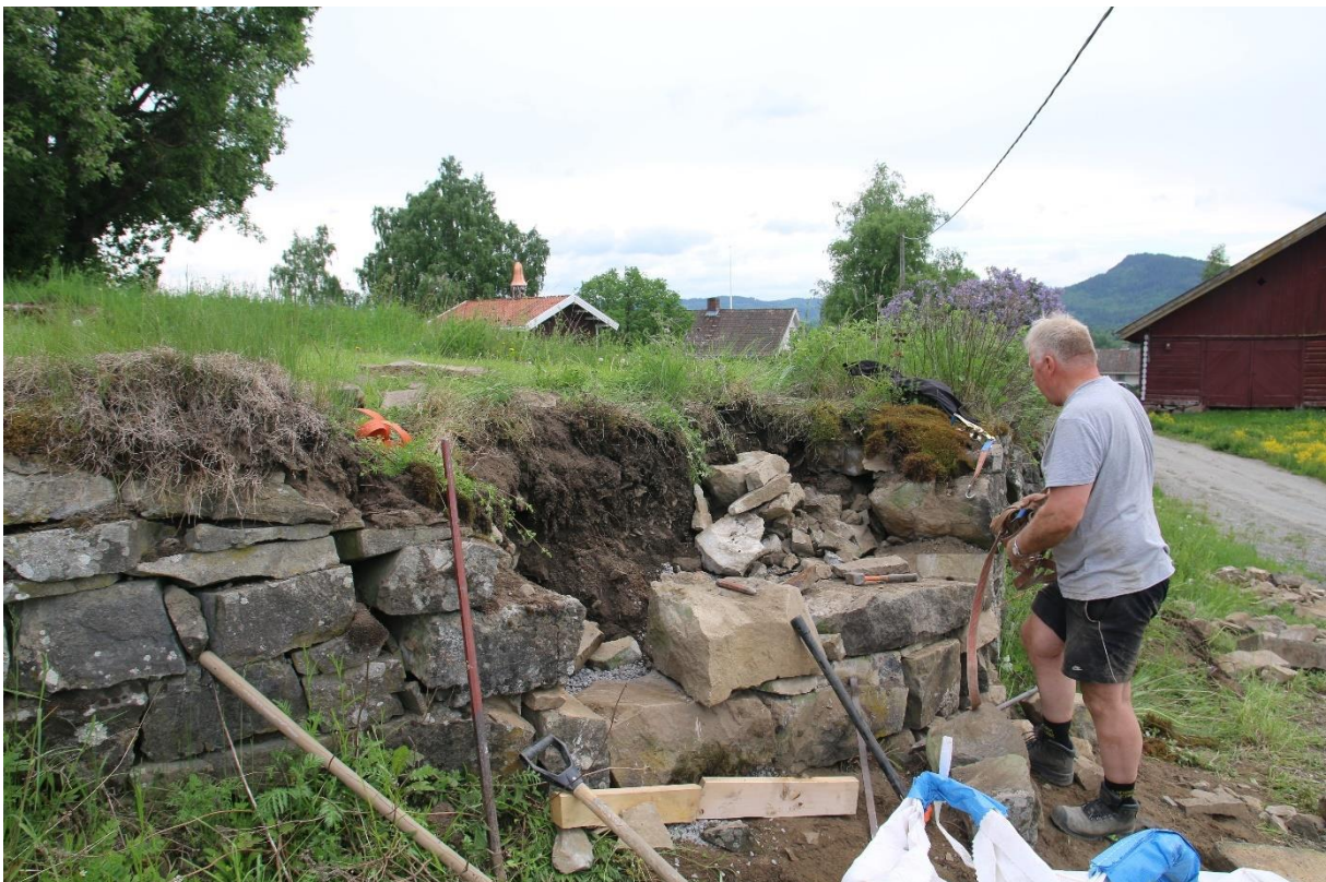
Figur 6: Et punkt langs den nordvestre delen av kirkegårdsmuren tatt ned og gjenoppmuring påstartet. Sett mot sør. Foto: Cf54079_NIKU_17.
