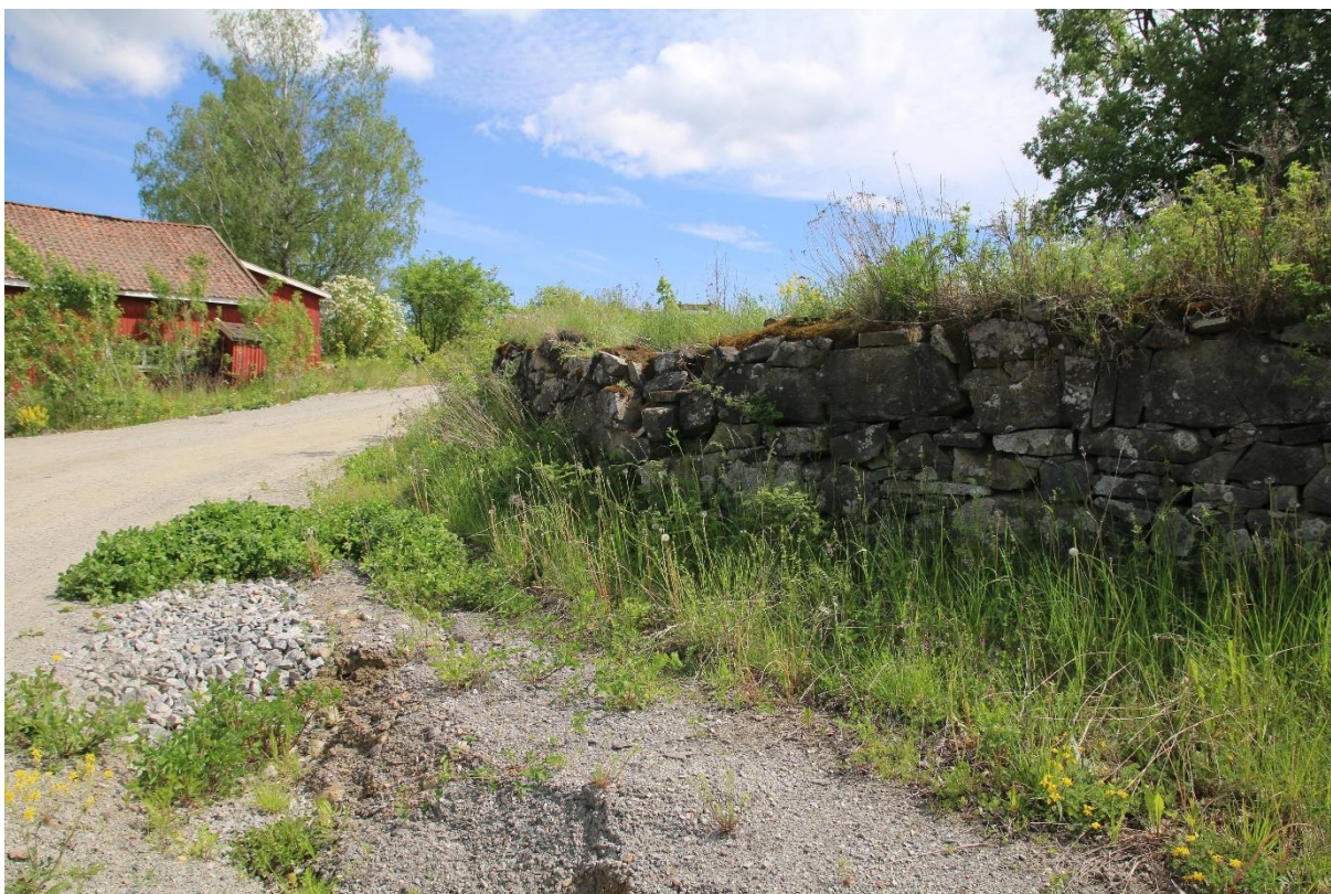
Figur 4: Nordvestre del av kirkegårdsmuren, som sto i fare for å rase ut. Sett mot nordøst. Foto: Cf54079_NIKU_10.
