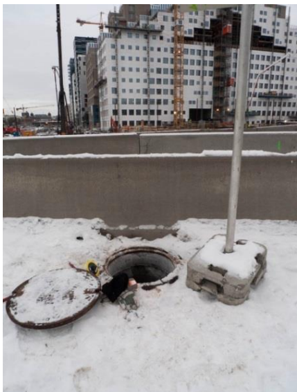
Miljøbrønnen MB7 i Dronning Eufemias gate. Frost i røret. Foto: NIBIO.
