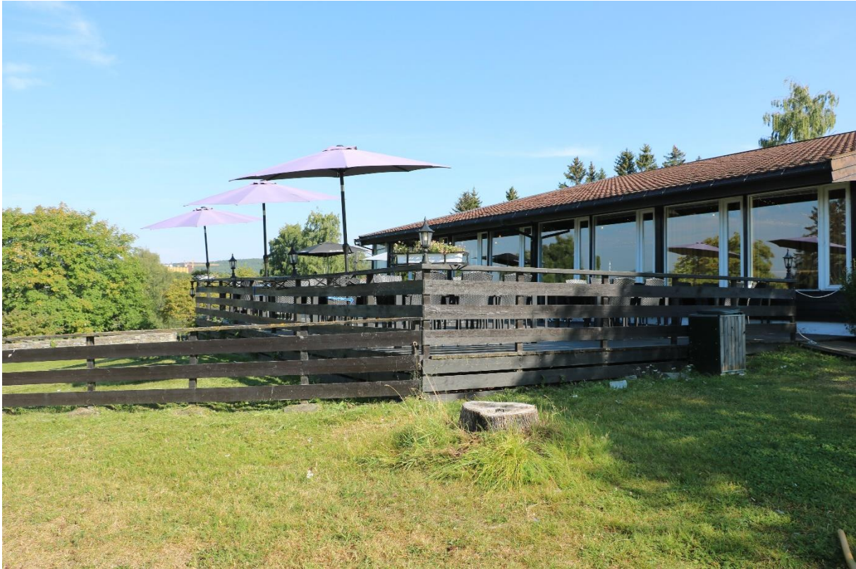
Figur 5: Eksisterende kafebygning. Sett mot nord. Foto-nr: Cf54082_NIKU_0001
