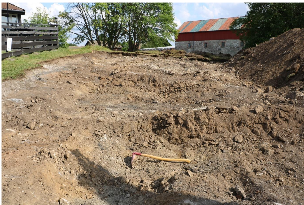
Figur 8: Område A ferdig gravd. Sett mot sørøst. Foto-nr: Cf54082_NIKU_0005
