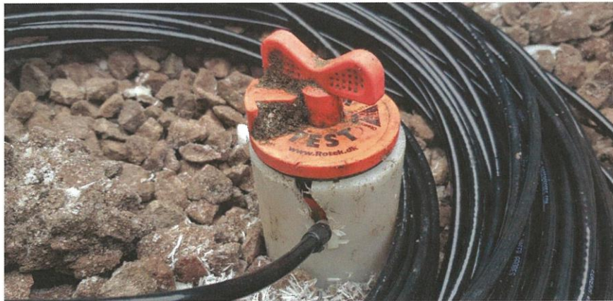
Fig. 3: Eksempel på kabelføring
