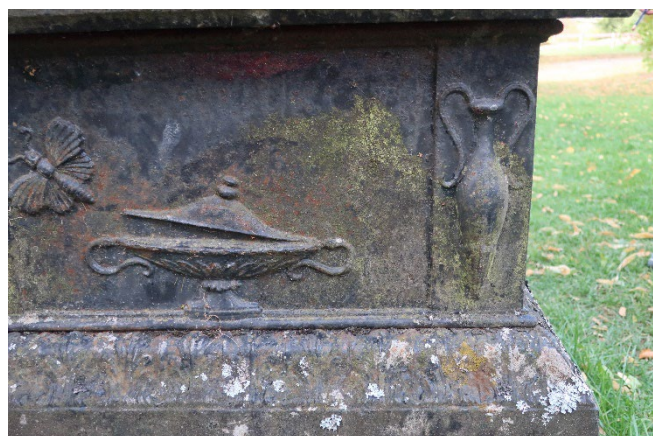
Korrosjon og økt mikrobiell vekst på postamentet
