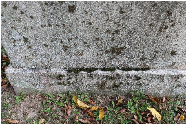
Fugen mangler, vann samles her og gir grobunn for biologisk vekst i form av mose og lav.
