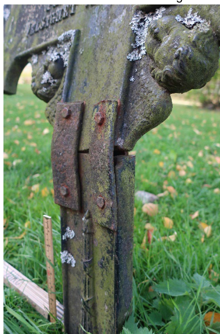
Brudd med sekundær stabilisering
