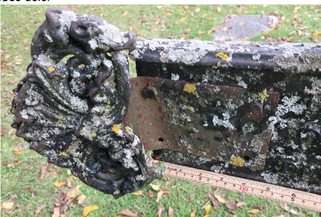
Flere sekundære tiltak (skruer) for å sikre løse deler
