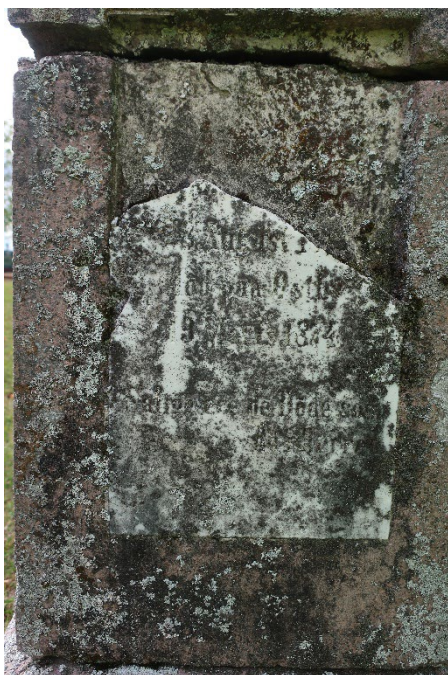
Knust marmorplate, biologisk vekst og svart gipsskorpe
