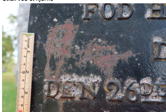
Korrosjon, antaglig grunnet rissing/ hærverk
