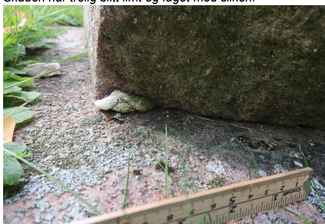
Skaden har trolig blitt limt og fuget med silikon.
