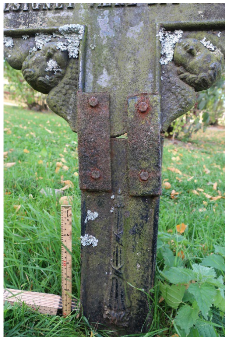
Brudd med sekundær stabilisering
