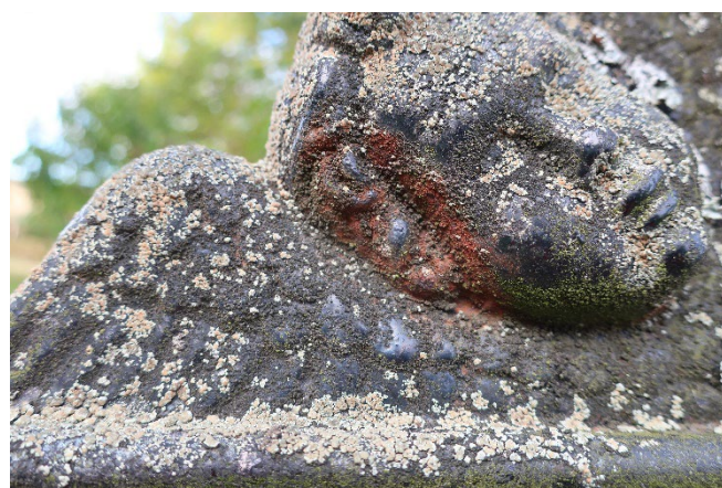
Korrosjon og tett mikrobiell begrodd
