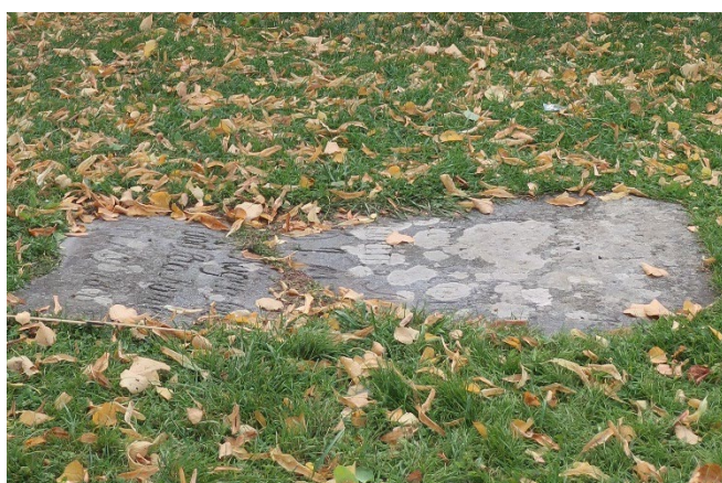
Platen er sprukken i to deler. I spekken samles jord og vann og det vokser gress. De to platene ligger ikke flatt.
