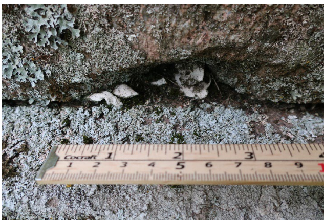
Bildet viser materialtap, mikrobiell vekst og rester av en eldre silikonfuge.
