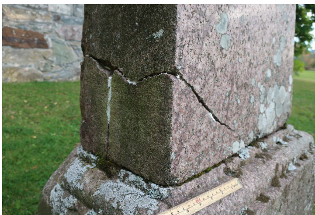
Skaden har trolig blitt limt og fuget med silikon.
