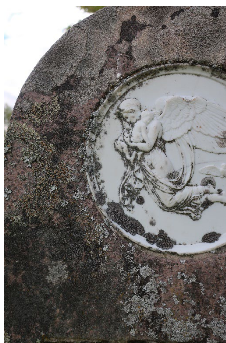
Biologisk vekst på stein og uglassert porselen, svart gipsskorpe
