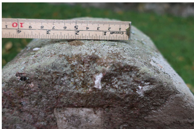
Materialbortfall. Et større brudd på framsides topp. Fugleskitt.
