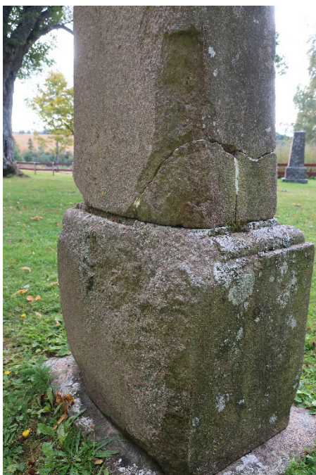
Store skader med brudd og materialbortfall som følge av et fall.
