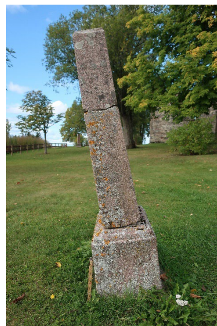
Eksempel på en gravstein som heller kraftig. Risikoen for at gravsteinen velter er høy.
