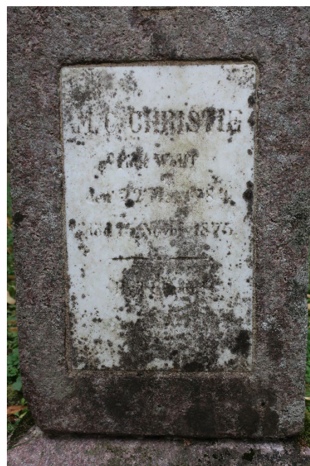
Svarte misfarging på den hvite marmordekoren som gjør innskriften uleselig. En aktiv skade som øker.
