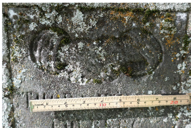
Den hvite marmorplaten er svart og har mye mikrobiell vekst på overflaten som gjør at innskriften er vanskelig å lese. Den svarte misfarging på marmoroverflaten kan være en gipsskorpe.
