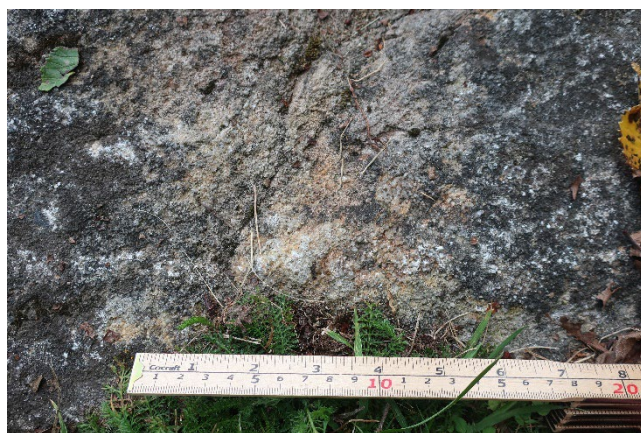
Sprekk og forvitring der vann kan samles.
