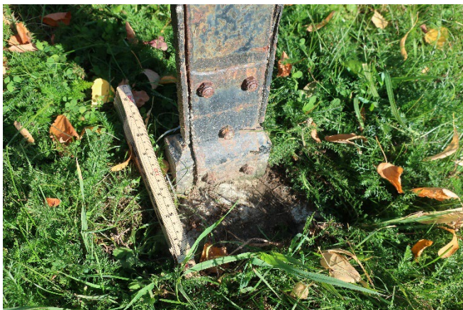
Forankring med betongplate i jorden
