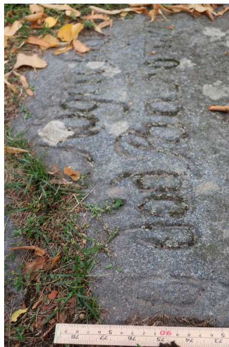
I den nedsenkte innskriften samles vann og organisk materiale. Fordypningene danner dermed en god grobunn for mikrobiologi.
