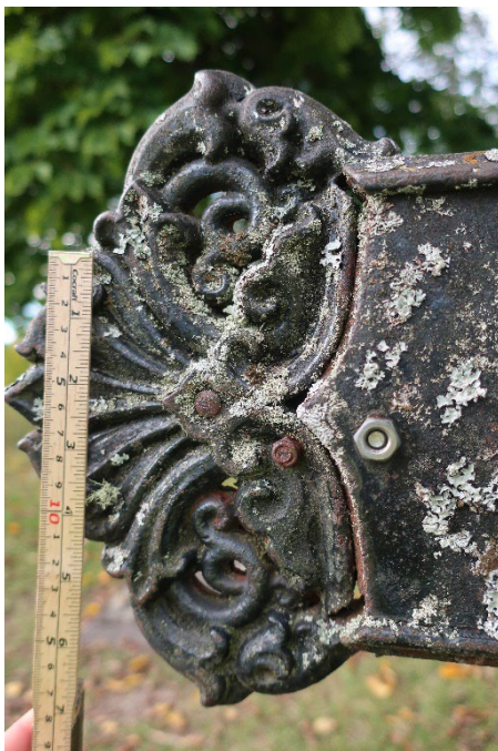
Flere sekundære tiltak (skruer) for å sikre løse deler
