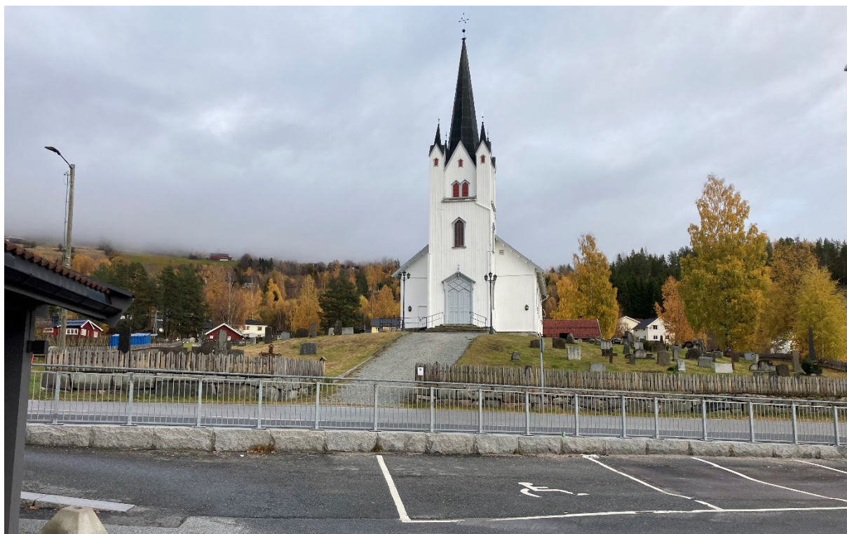
Kirkens hovedatkomst sett fra handelslagets parkeringsplass/inngangsparti med redusert tilgjengelighet til kirkens hovedinngang.
