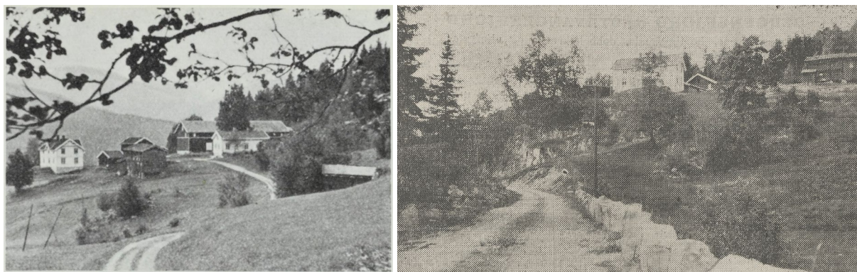
Pletan (149/1) fotografert fra øst ca. 1940. Bildet til høyre viser tunet med våningshuset sett fra Eggedalsveien, den gang Nyveien, i 1928. Her står en gruppe eldre bygninger, herunder våningshuset på sydsiden av tunet som er antatt bygd på midten av 1600-tallet, men påbygd med en etasje på 1900-tallet. Bilde: Norske gårdsbruk (1948) / Fremtiden 02.02.1929
