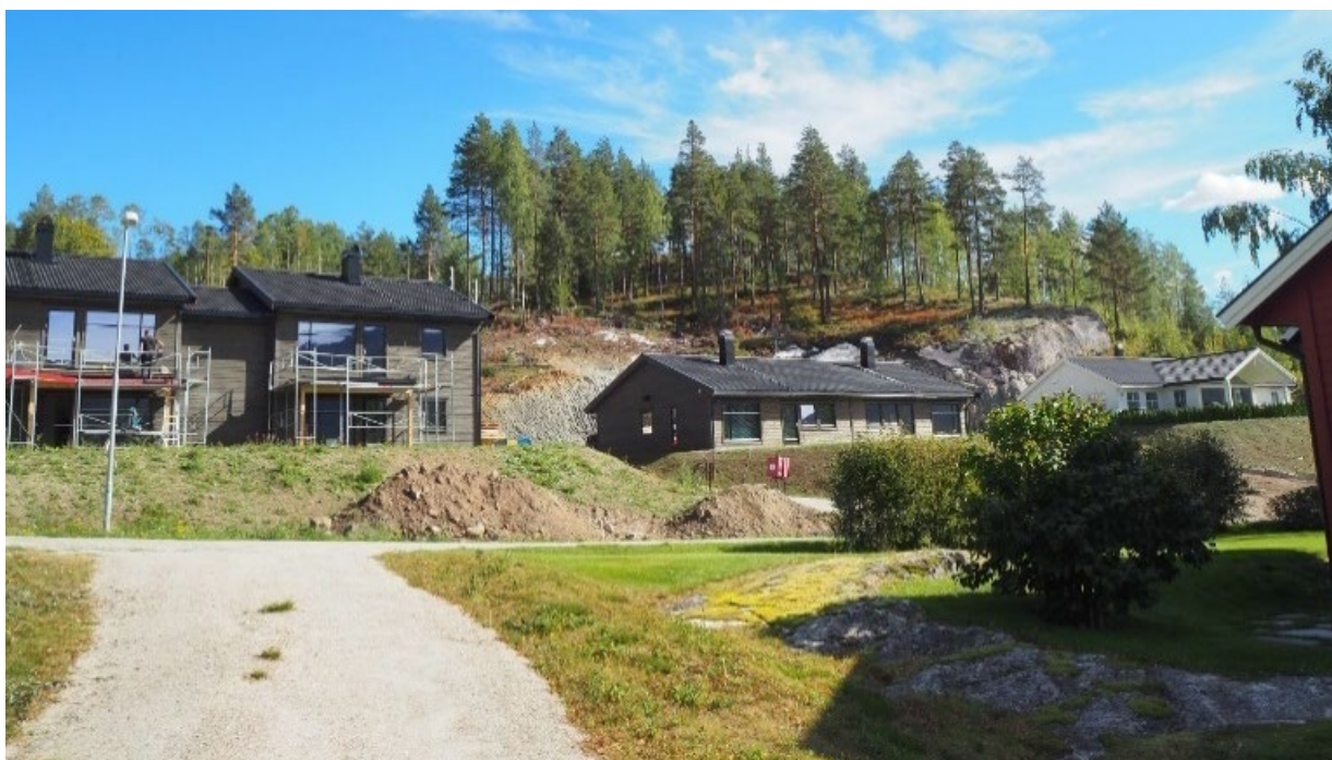
Boliger øverst i området langs Gamle Tempelvei, under oppføring i 2022.
