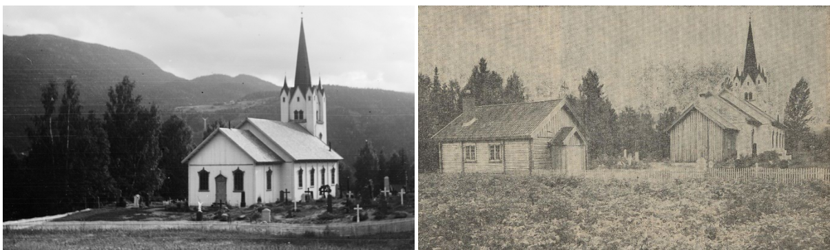
Fotografiet til venstre viser Eggedal kirke sett fra øst i 1932, før restaurering. Til høyre et fotografi fra 1948 da sakristiet (fortsatt umalt) var nybygget, og inntilliggende gravkapell innviet. Bilde: Sigdal Museum / Buskeruds Blad 25. september 1948
