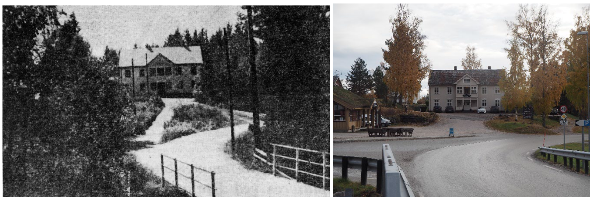
Eggedal borgerstue fotografert fra nord i 1951 og i dag. På det venstre bildet den gamle brua over Jelleelva. Dagens bru (Teige, bru nr. 781) er fra 1969. Bilde: Drammens Tidene, fredag 8. juni 1951
