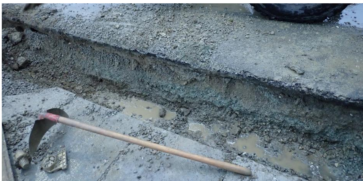
Figur 10: Profil i grøft gravd for trekkør. Foto: Anders Hesjedal, NIKU.
