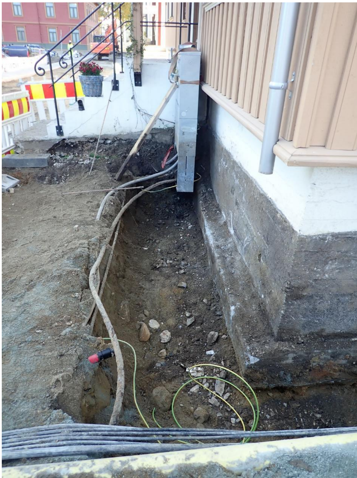
Figur 14: Dreneringsgrøft langs sørsiden av Tollbodgate 6B. Foto: Anders Hesjedal, NIKU.
