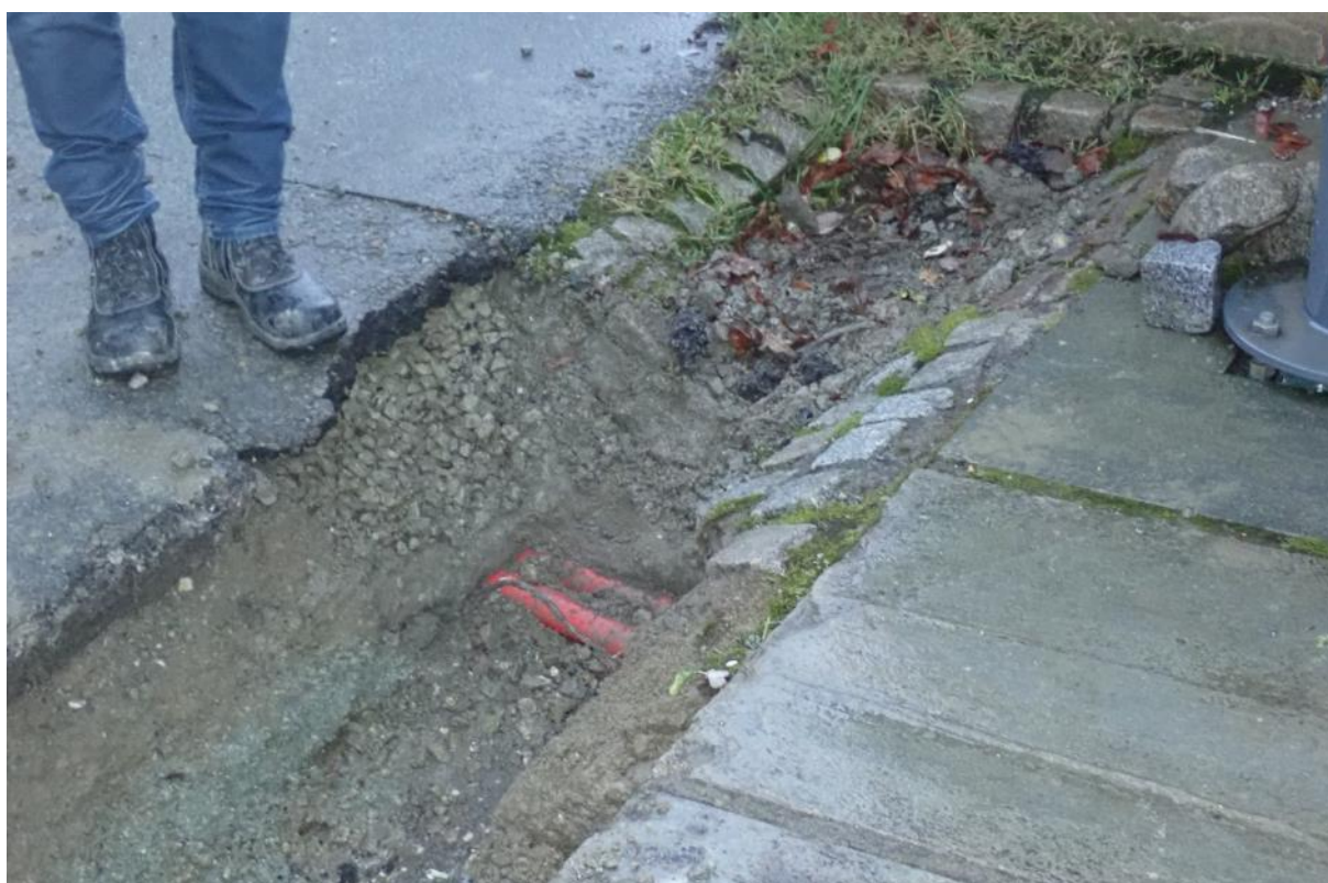
Figur 12: Trekkør i bunn av grøft gravd for trekkør. Foto: Anders Hesjedal, NIKU.
