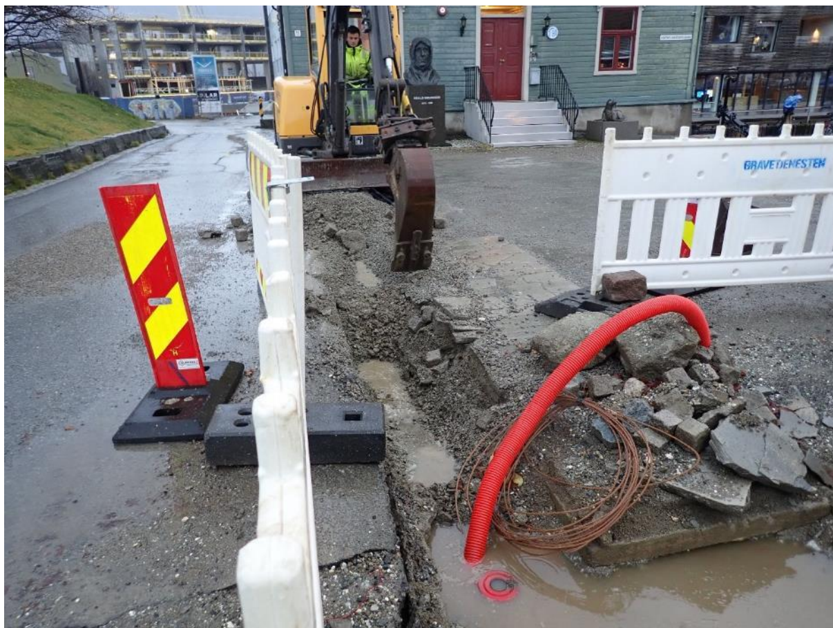
Figur 9: Oversiktsbilde tatt under graving av sjakt for trekkør. Sjakten går mellom det røde trekkøret og det grønne huset. Skansen er synlig til venstre i bildet. Foto: Anders Hesjedal, NIKU.
