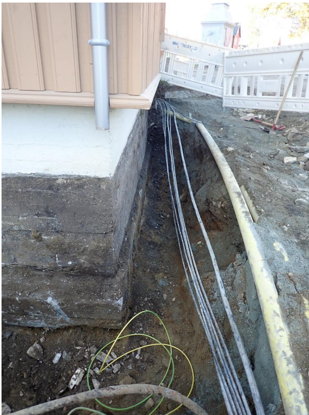
Figur 13: Dreneringsgrøft langs østsiden av Tollbodgate 6B. Foto: Anders Hesjedal, NIKU.
