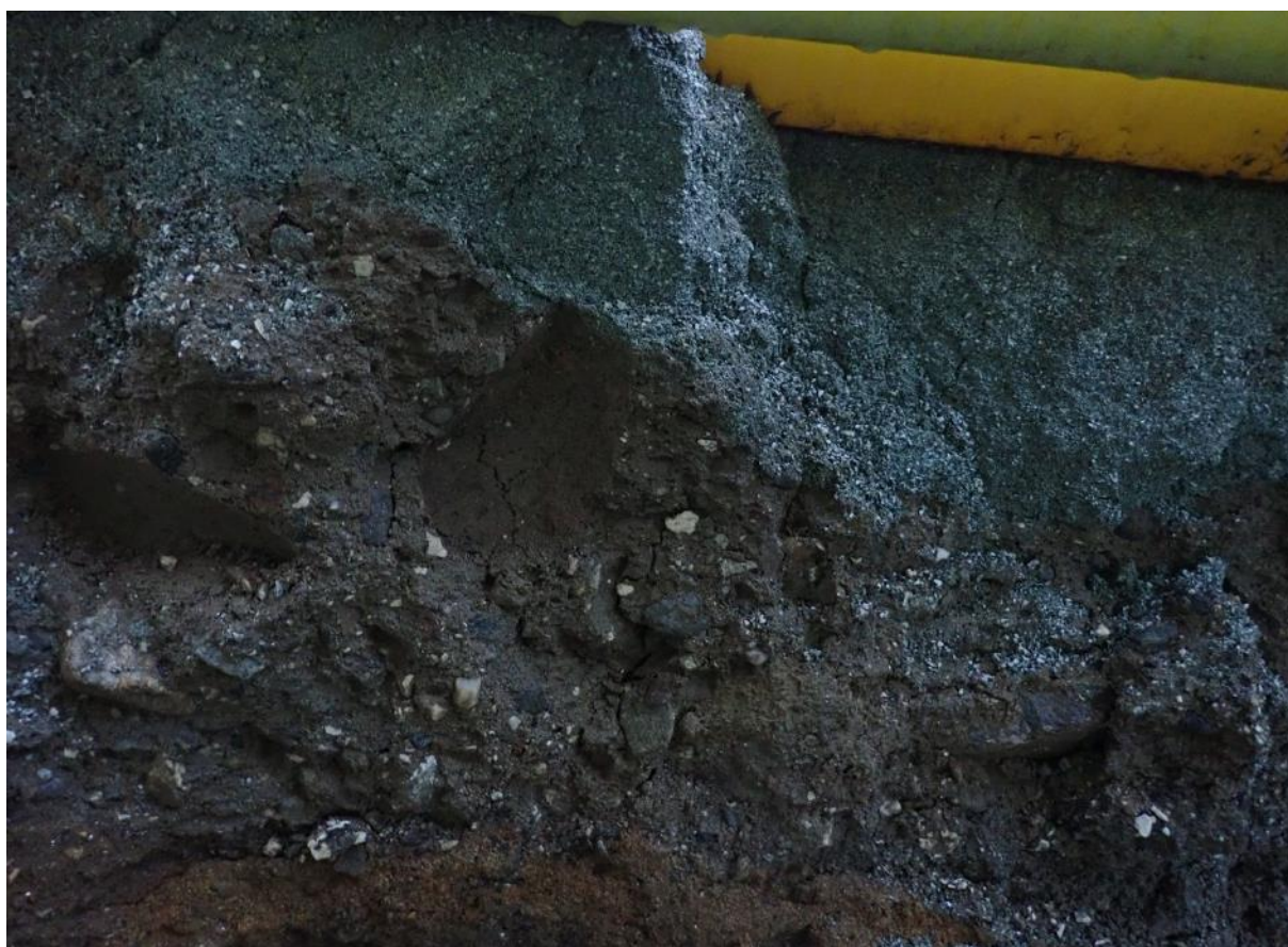
Figur 16: Profil (nærbilde) i dreneringsgrøft ved Tollbodgate 6B. Foto: Anders Hesjedal, NIKU.
