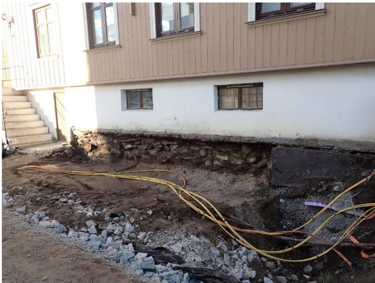
Figur 19: Tollbodgate 6B mot sør. Foto: Anders Hesjedal, NIKU.
