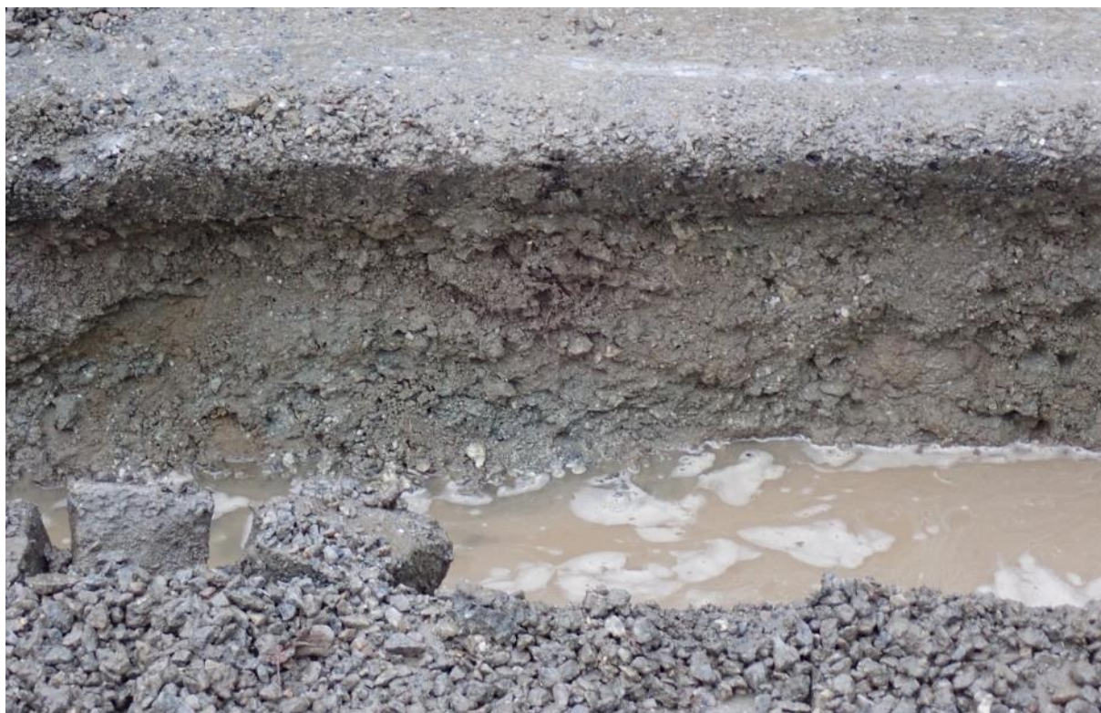
Figur 11: Profil (nærbilde) i grøft gravd for trekkør. Foto: Anders Hesjedal, NIKU.
