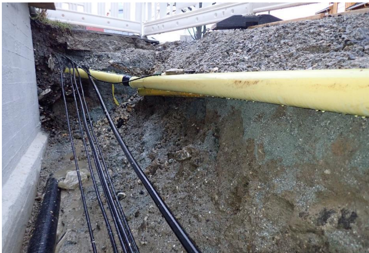
Figur 15: Profil i dreneringsgrøft ved Tollbodgate 6B. Foto: Anders Hesjedal, NIKU.
